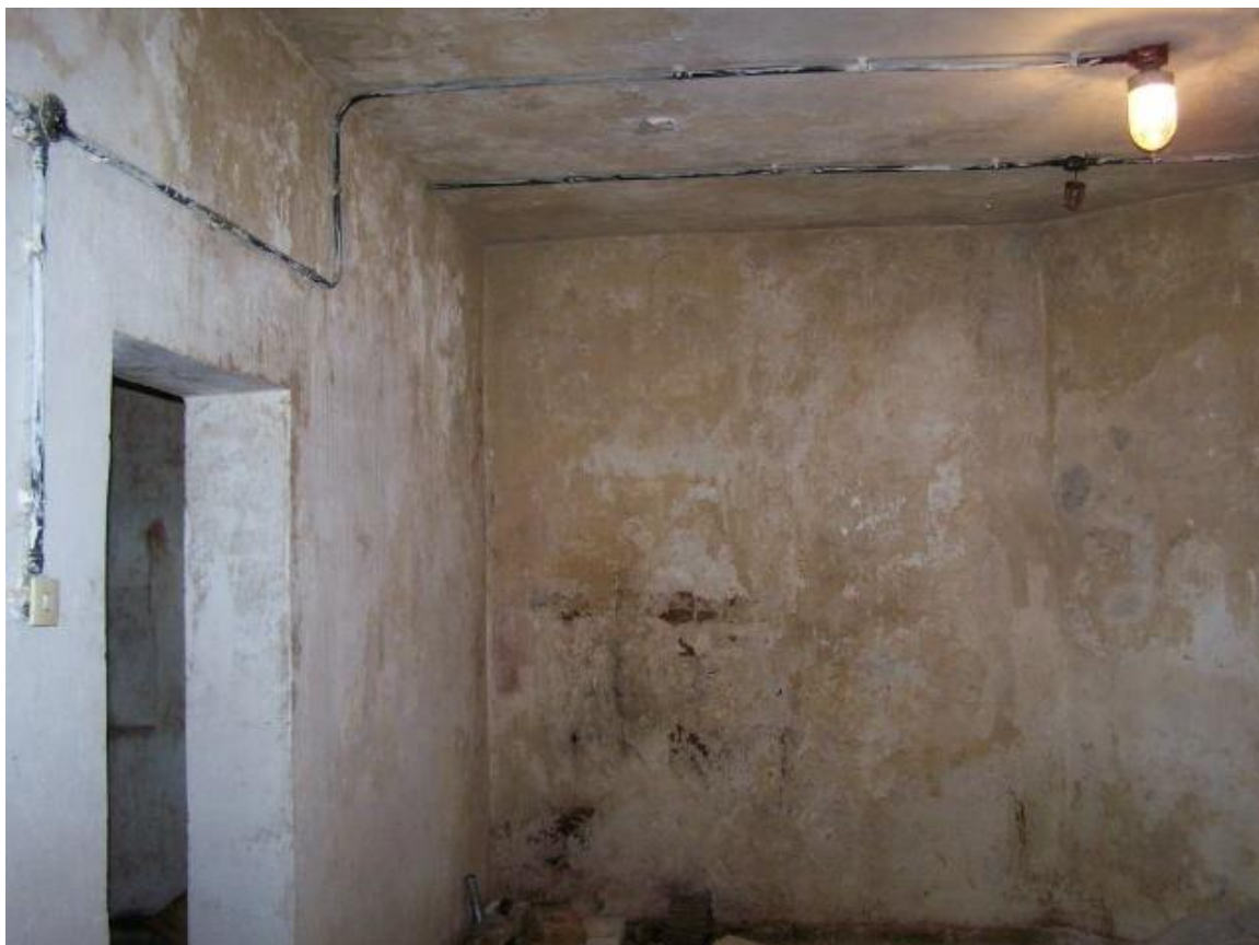
Fot.29. Piwnica – przykładowe zagrzybienie i zawilgocenie ścian i stropu w pomieszczeniu w trakcie północno - wschodnim
