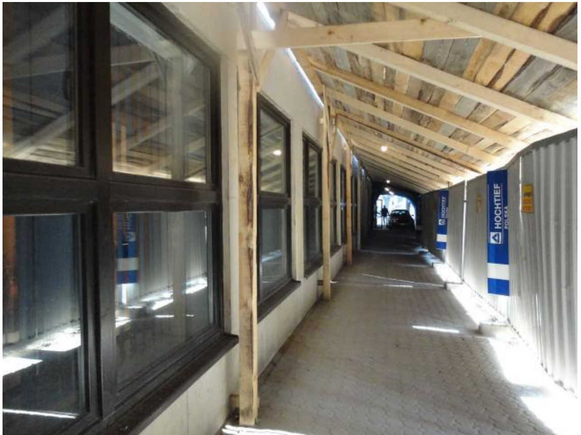
Fot.135 Elewacja boczna teatru z wejściem głównym – widok zadaszania od strony budowy
