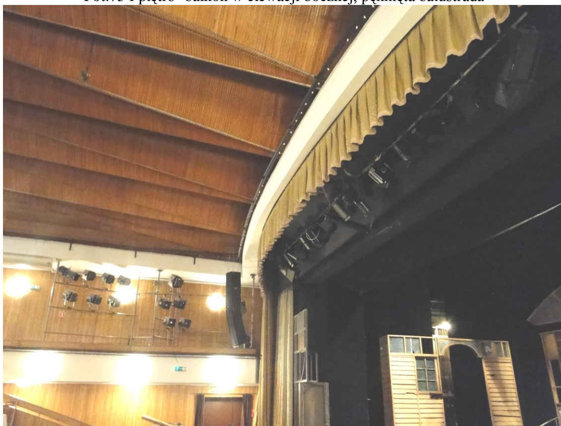
Fot.76. I piętro – widok drewnianego sufitu podwieszonoego nad widownią teatru
