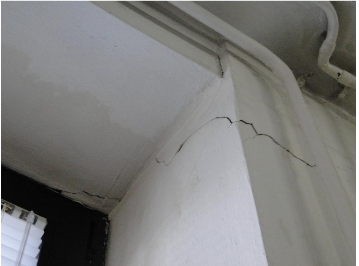
Fot. 93. II piętro – zarysowania ścian zewnętrznych w strefie nadproży – sala ćwiczeń teatru
