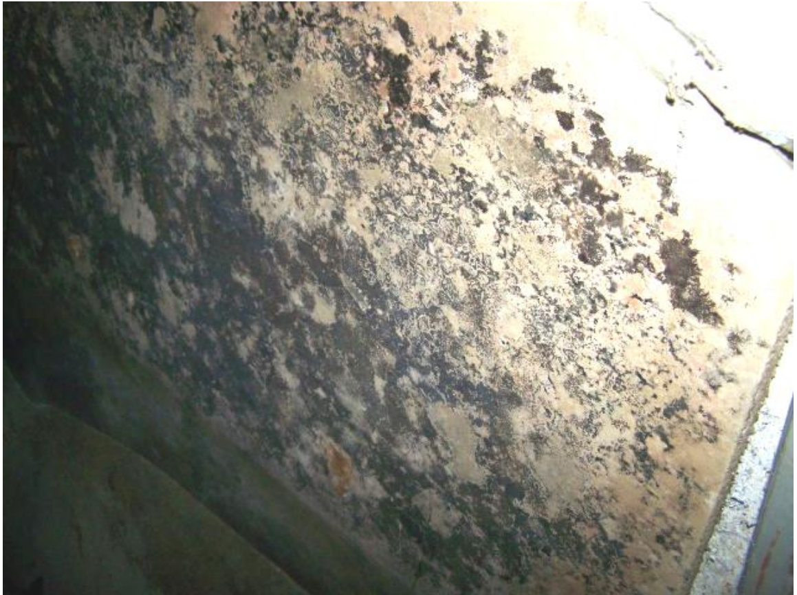
Fot.45 Piwnica – przykładowe zagrzybienie i zawilgocenie ścian
