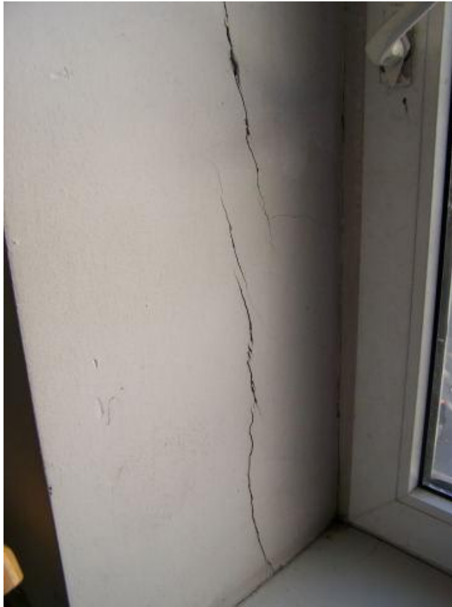
Fot.85. II piętro – zarysowania ścian klatki schodowej prowadzącej do banku
