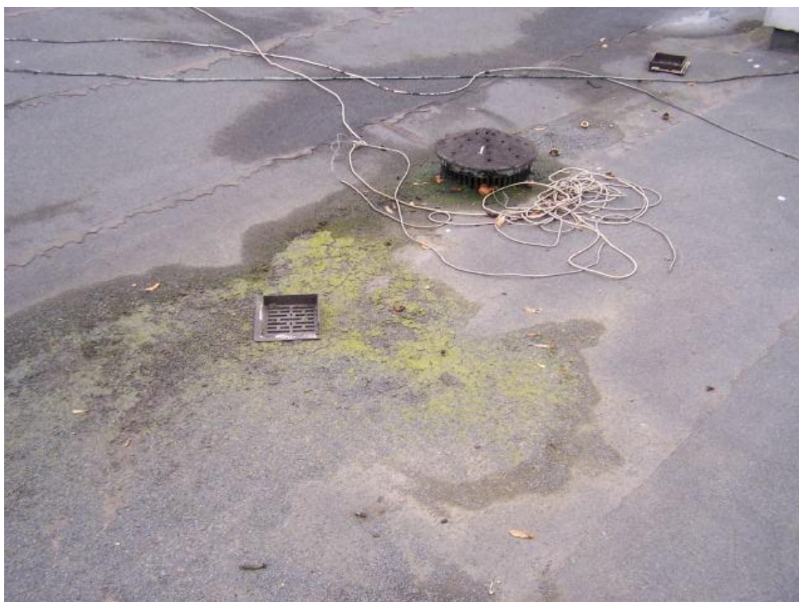
Fot.123. Dach - spękania papy i zastoiny wody.
