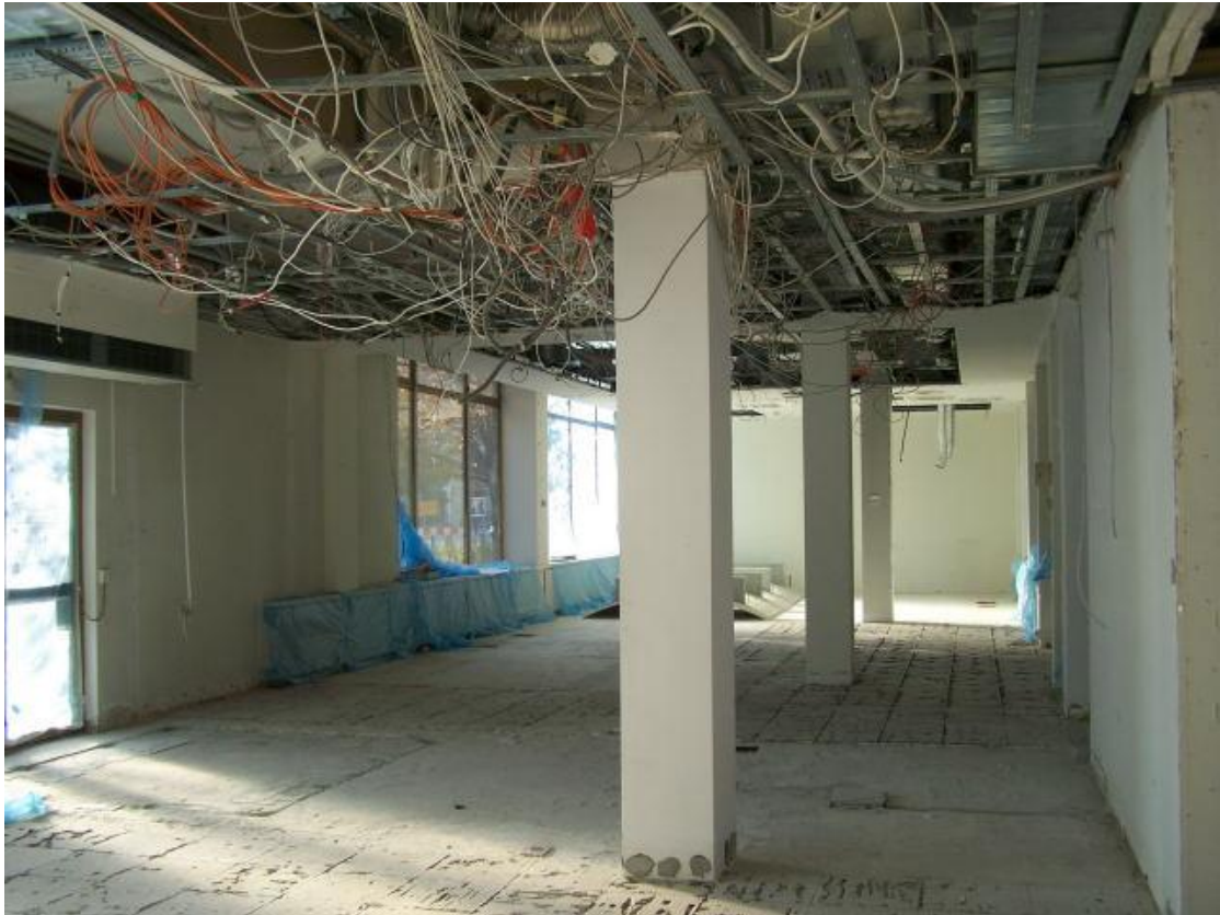
Fot.59. Parter – widok słupów konstrukcyjnych w pomieszczeniu od strony placu Grzybowskiego
