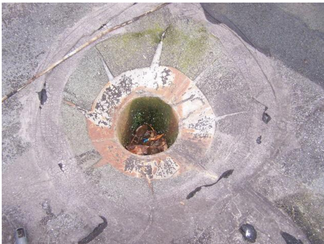
Fot.129 Dach – zanieczyszczone odpływy wody
