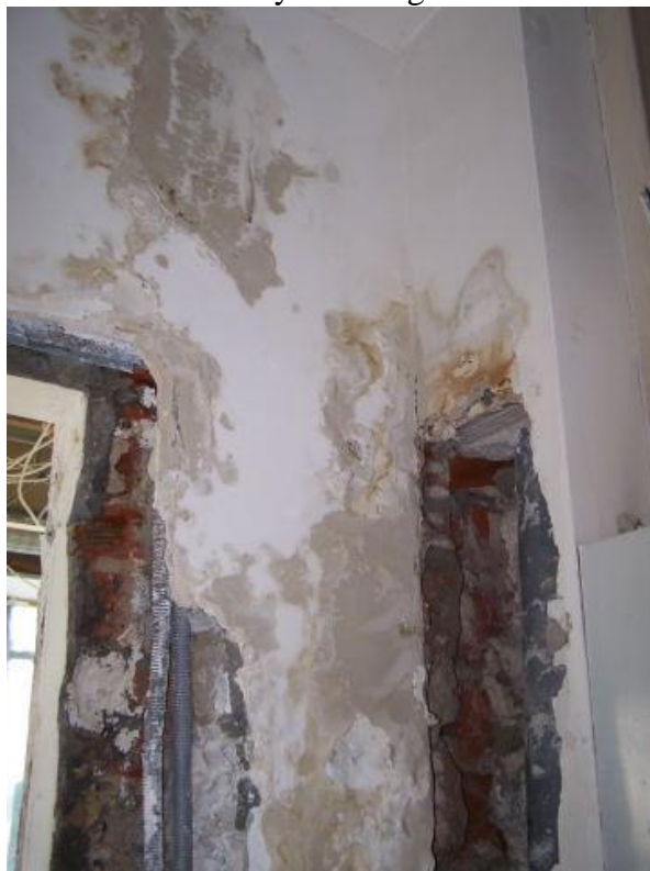
Fot.60 Parter – silne zawilgocenie ścian z płyt G-K
