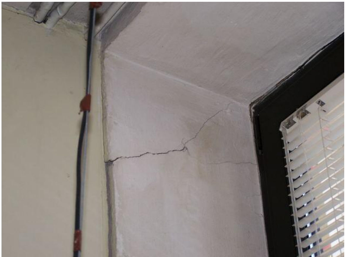
Fot. 102 II piętro – zarysowania w ścianie zewnętrznej nad widownią
