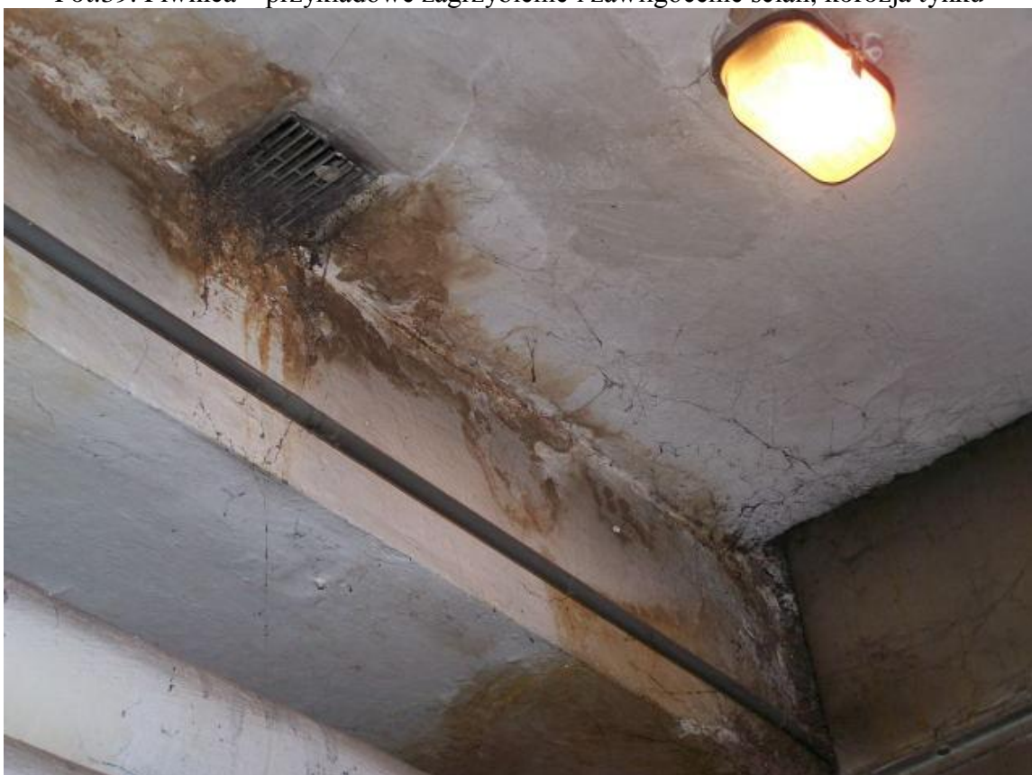
Fot.40. Piwnica – przecieki wody w strefie kominów, zarysowania płyty stropowej
