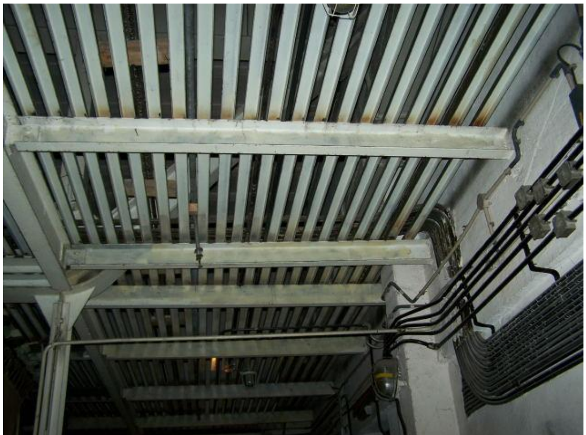
Fot. 96. II piętro – widok konstrukcji stropu technicznego nad sceną
