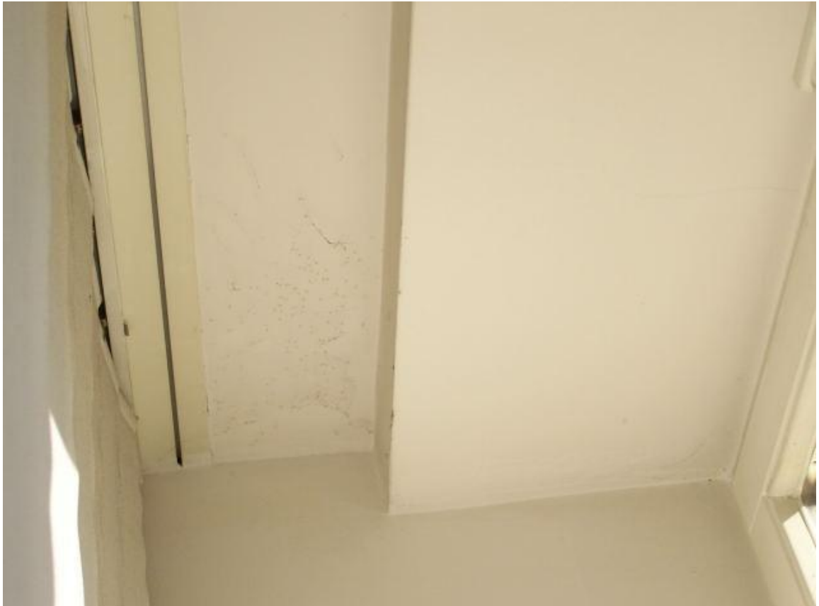
Fot. 79 I piętro – zawilgocenie nadproży okiennych
