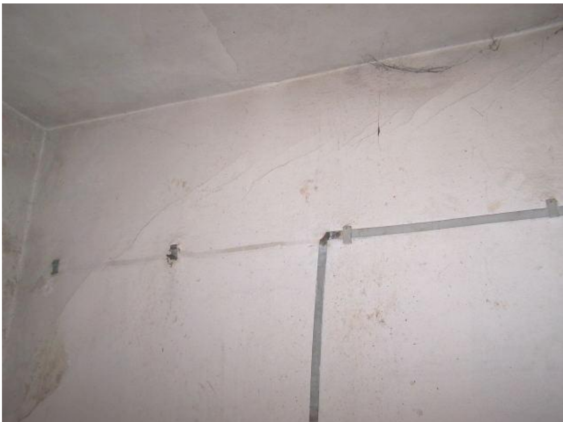
Fot.33. Piwnica – zarysowania ukośne ścian poprzecznych (w pomieszczeniu skrajnym w trakcie przy placu Grzybowskiem)
