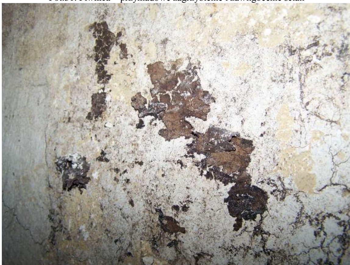
Fot. 32 Piwnica – przykładowe zagrzybienie i zawilgocenie ścian
