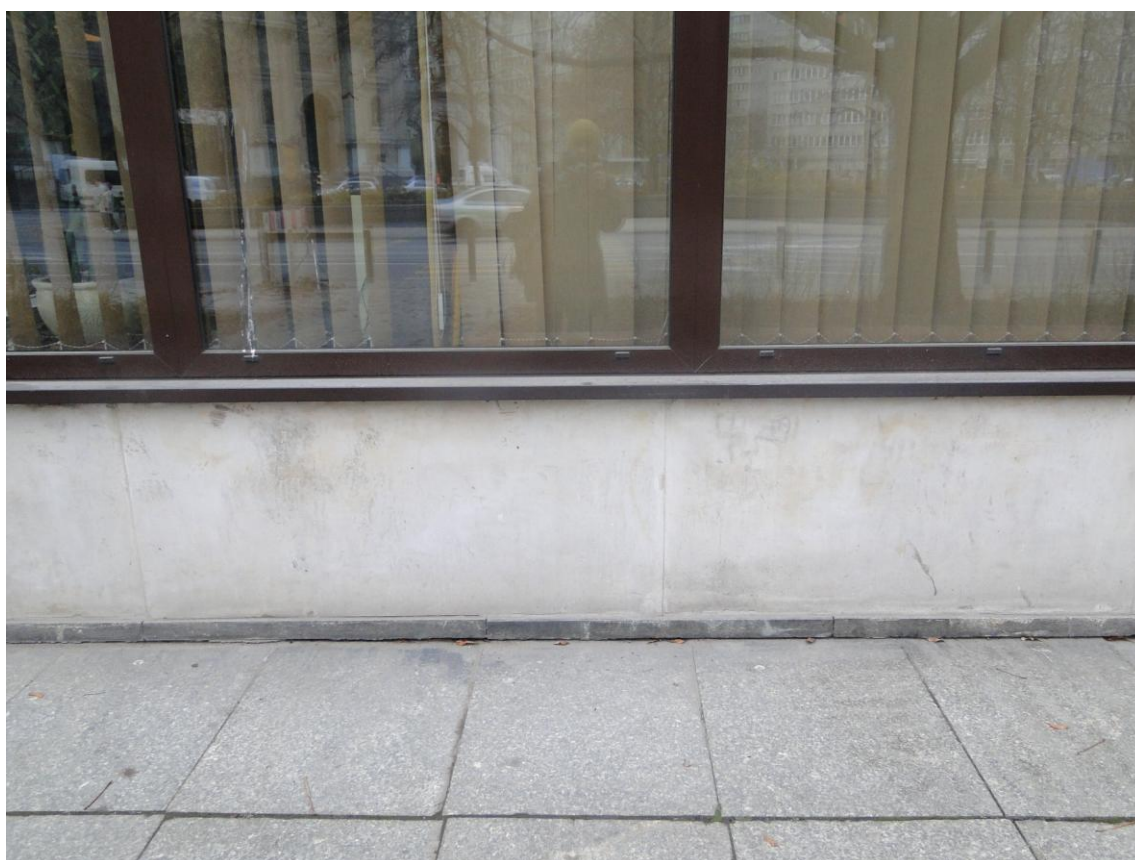
Fot. 134 Elewacja od strony placu Grzybowskiego – zarysowania ścian
