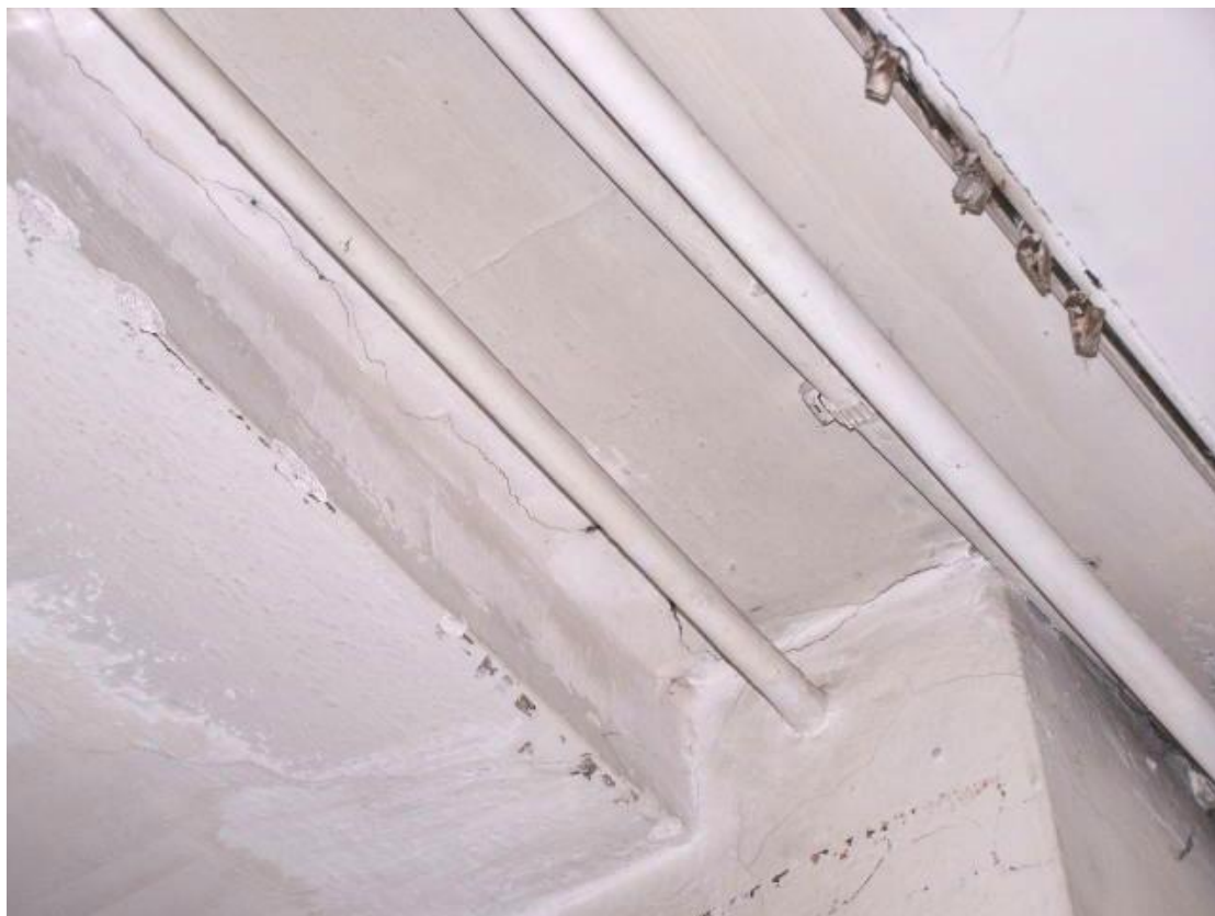
Fot.103 II piętro – zarysowania w strefie nadproży
