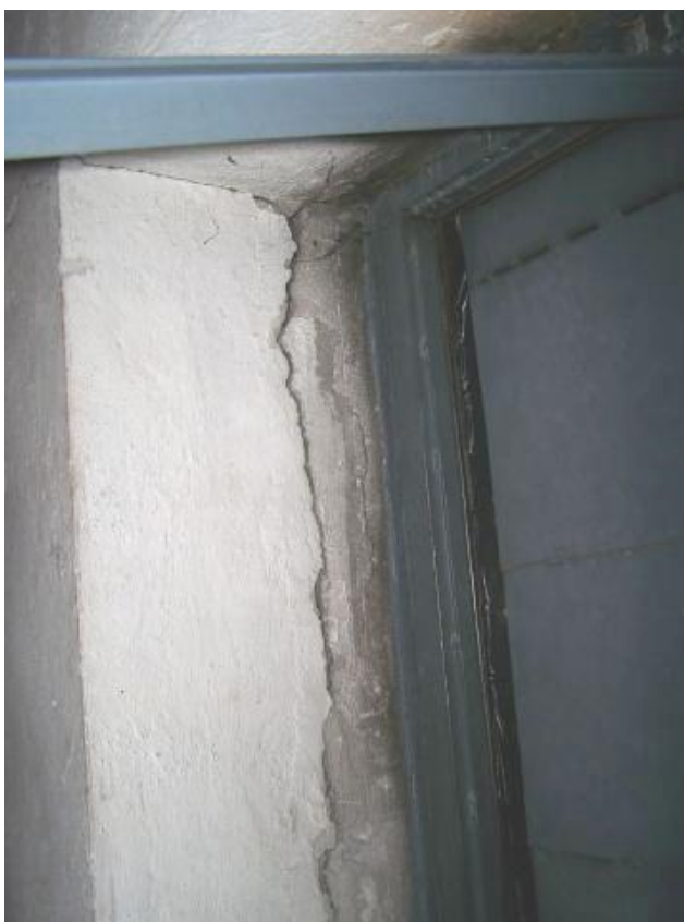
Fot. 114 Poziom techniczny nad sceną – przykładowe spękania ścian
