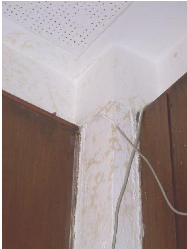
Fot. 77 I piętro - zacieki na ścianie. Przy słupie konstrukcyjnym
