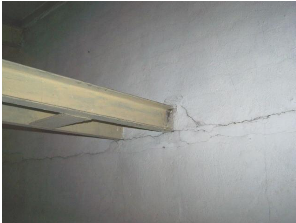
Fot. 110 Poziom techniczny nad sceną -rysy poziome w ścianie kolankowej dachu
