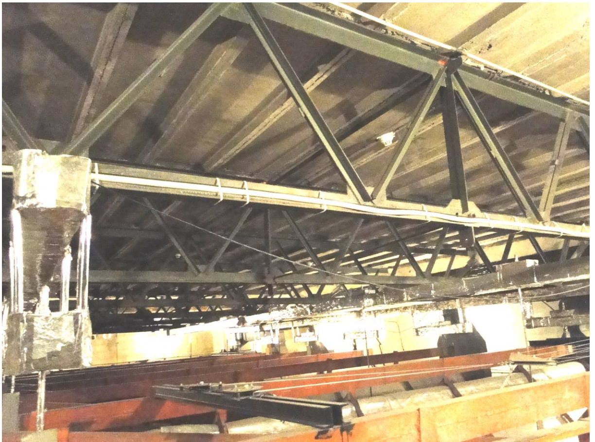
Fot.101 II piętro – konstrukcja przekrycia nad widownią
