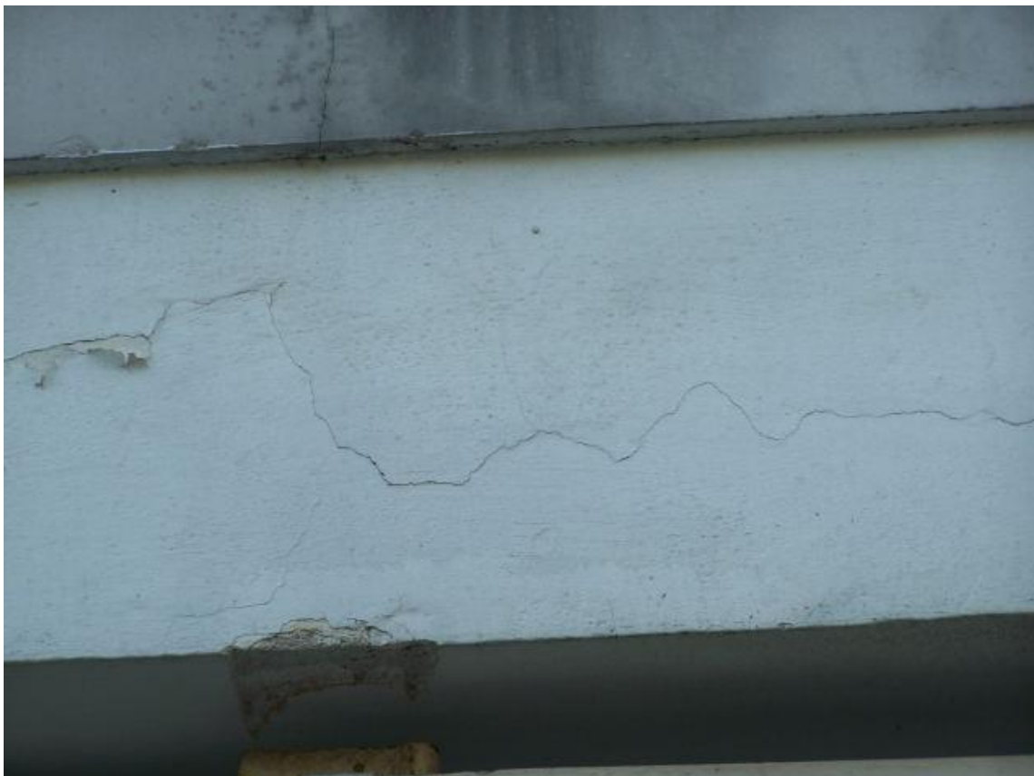
Fot.147 Elewacja boczna - zarysowania podciągu nad bramą przejazdową
