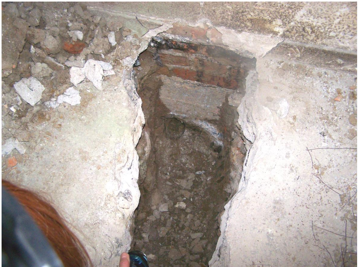
Fot. 2.2. odkrywka nr 2 – ściana wewnętrzna, wykonana z poziomu piwnic
