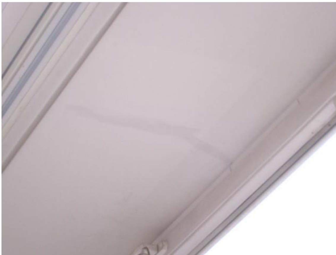
Fot.87. II piętro –rysy w nadprożu okiennym w pomieszczeniach banku
