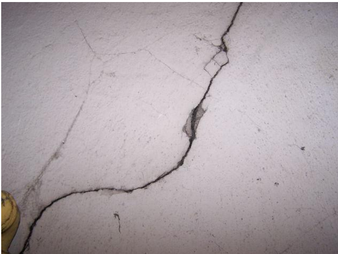
Fot.15. Piwnica – zarysowania ścian poprzecznych (w pomieszczeniu skrajnym w trakcie przy placu Grzybowskiem)
