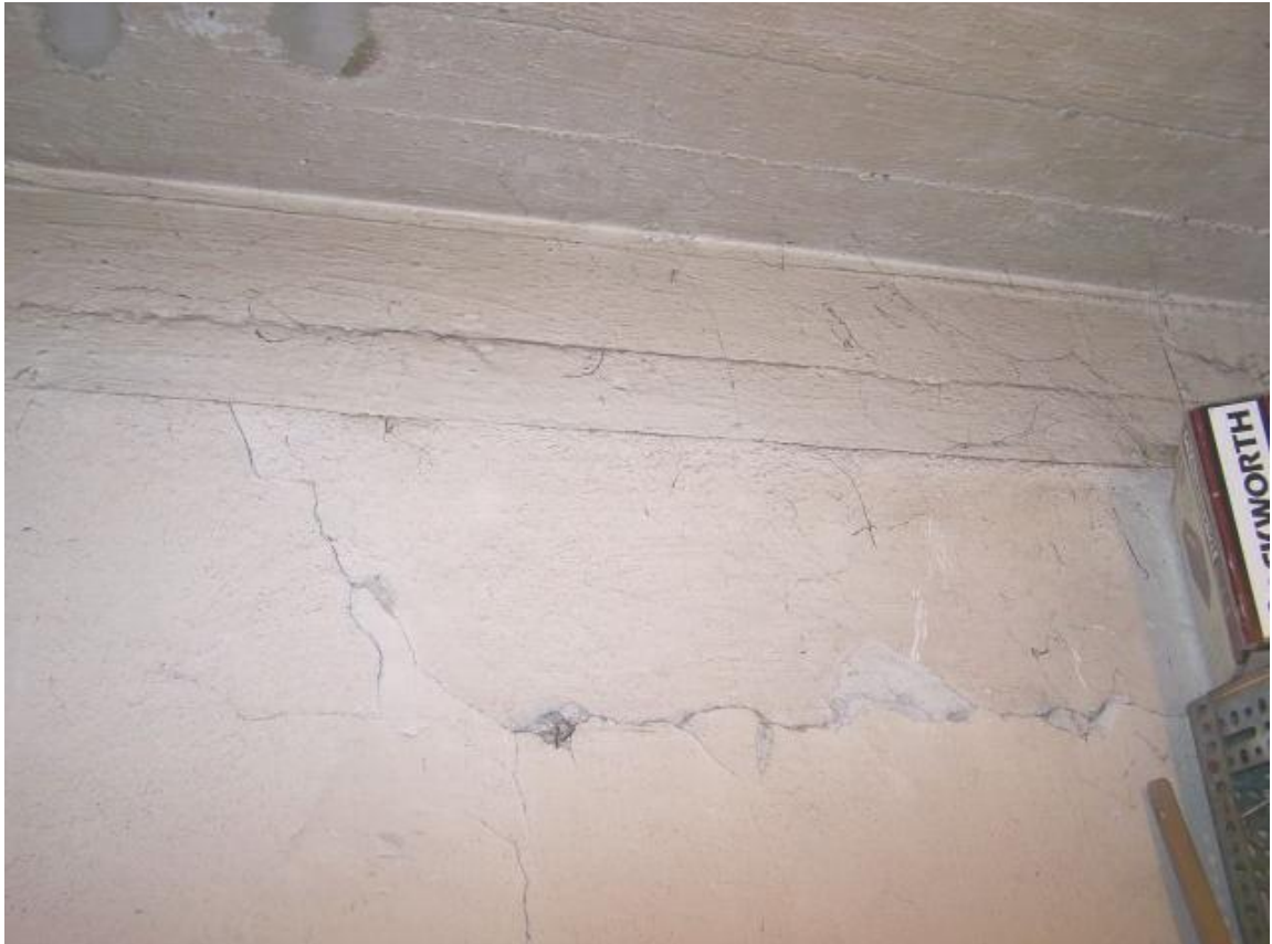
Fot. 51 Piwnica - zarysowania ściany poprzecznej w trakcie od strony podwórka
