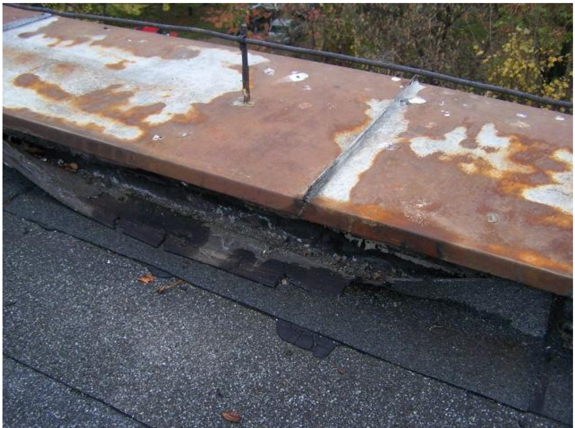
Fot. 128 Dach – skorodowane obróbki blacharskie
