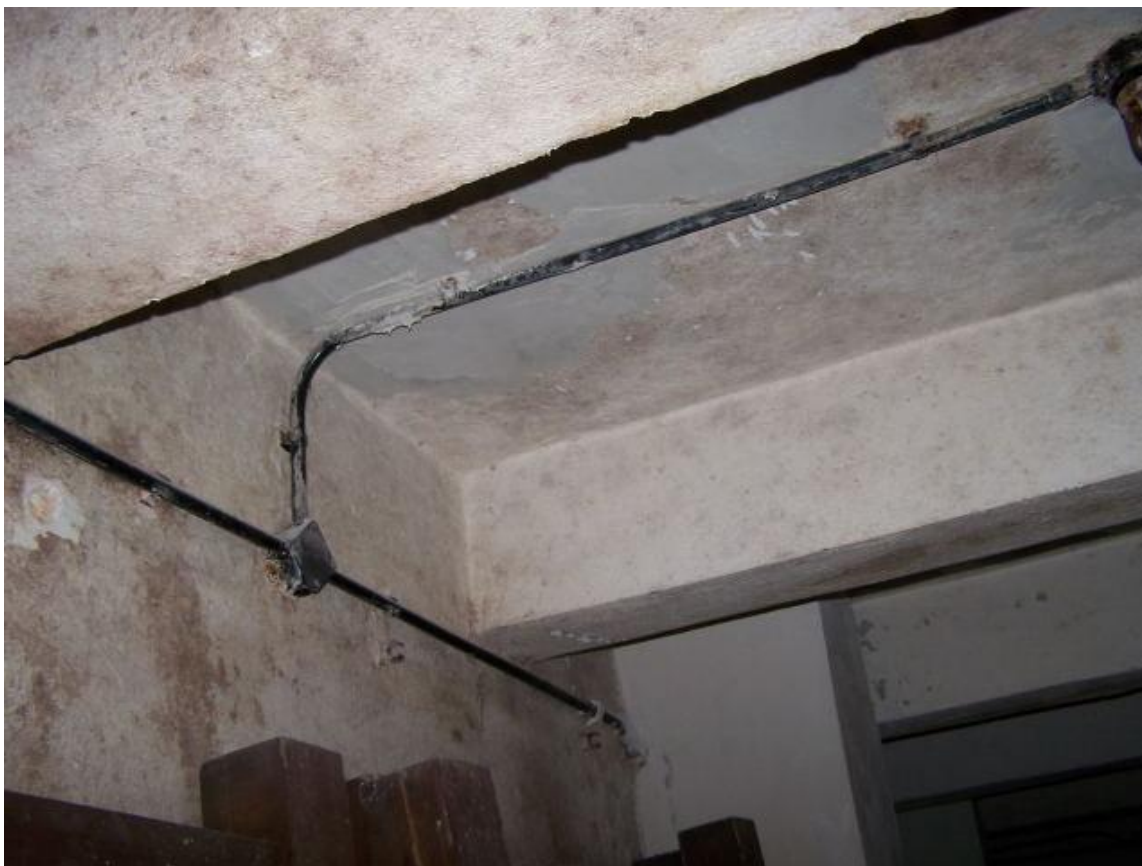
Fot.17. Piwnica - przykładowe zawilgocenie i zagrzybienie ścian piwnicznych(w pomieszczeniu skrajnym w trakcie przy placu Grzybowskiem)
