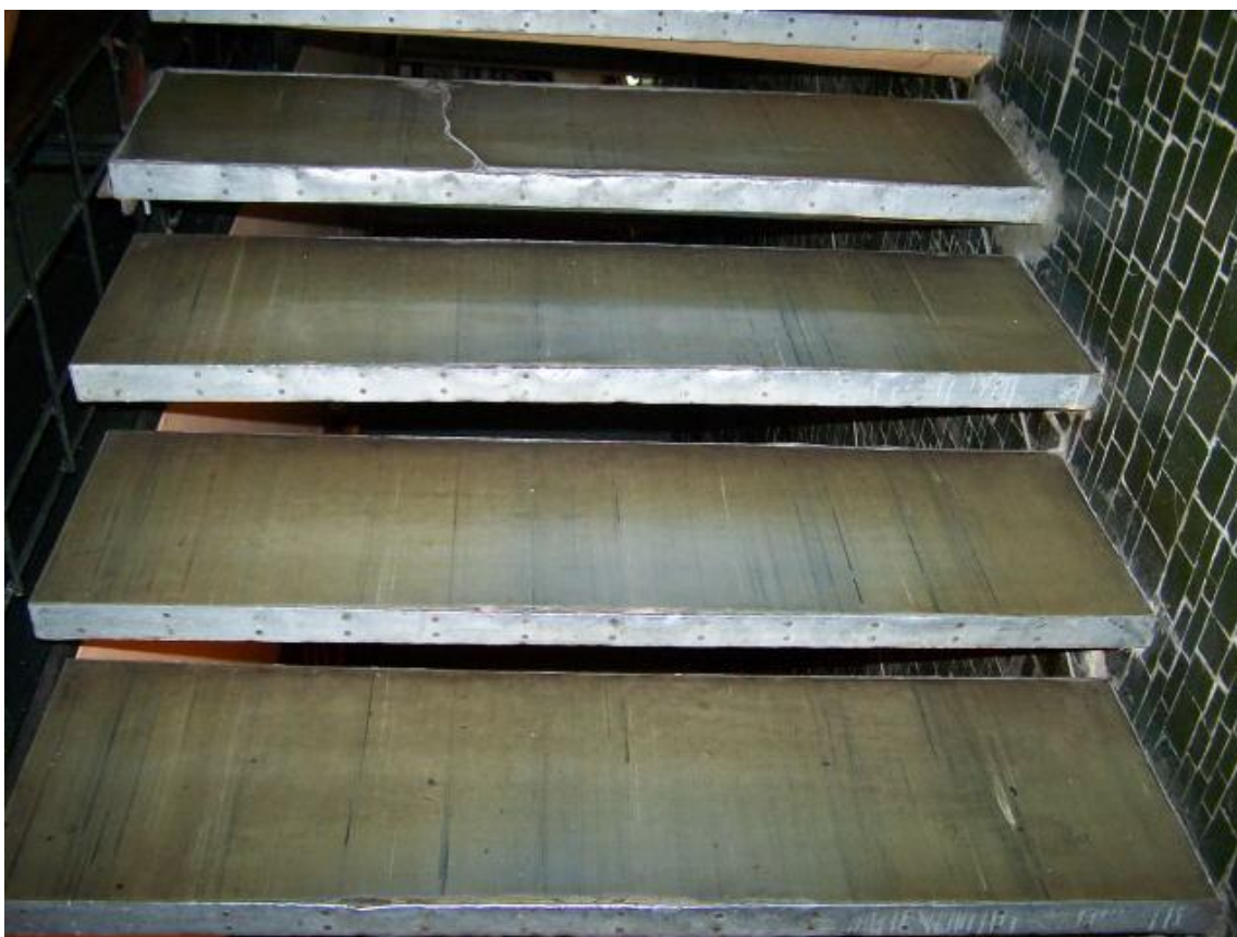
Fot.69. I piętro – zarysowanie stopni wspornikowych schodów
