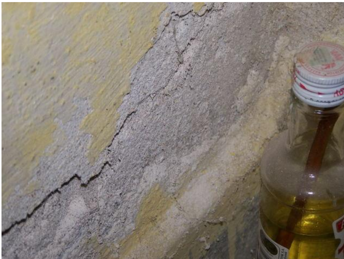
Fot. 9. Piwnica – przykładowa korozja biologiczna ścian piwnicznych, odspojenie tynku
