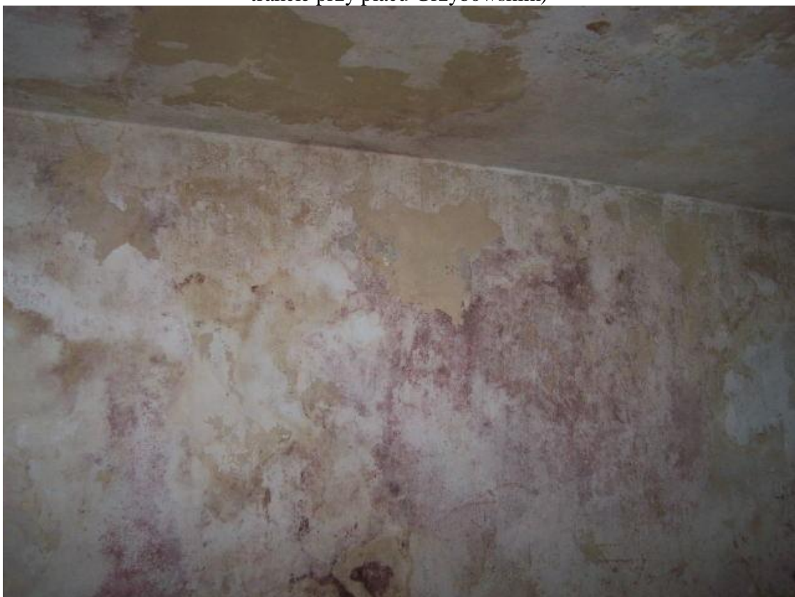
Fot.34. Piwnica – przykładowe zagrzybienie i zawilgocenie ścian
