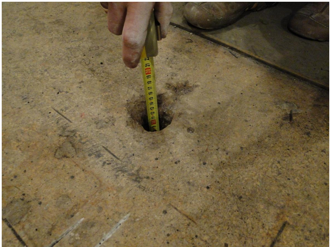
Fot. 2.10. Odkrywka nr 9 – posadzka w poziomie piwnic
