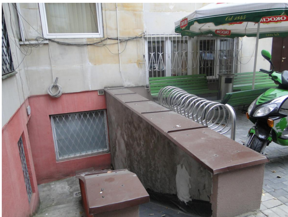
Fot. 150 Elewacja od strony podwórka – zewnętrzne schody, zawilgocenie murku oporowego
