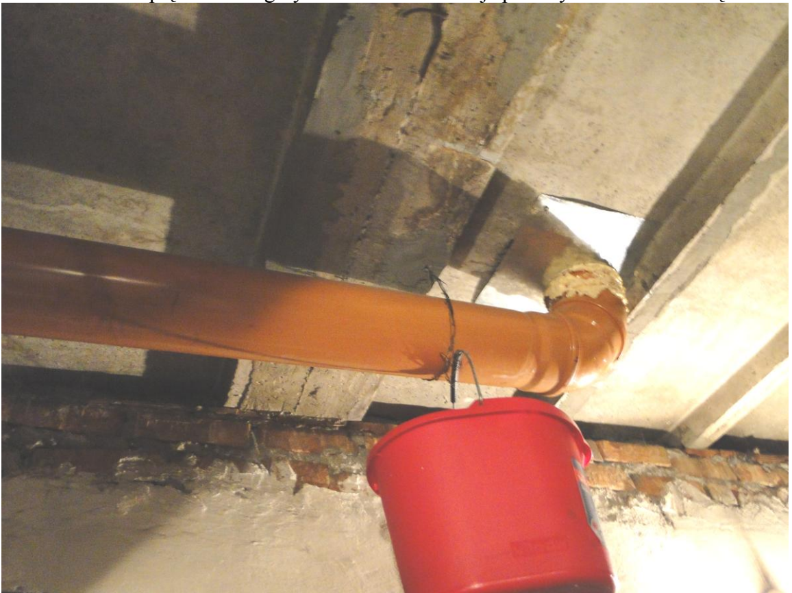
Fot. 100 II piętro – oparcie płyt korytkowych, przecieki wody z dachu
