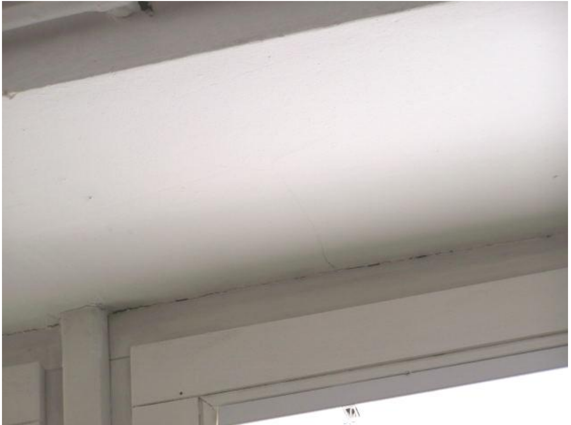
Fot. 89. II piętro – zarysowane nadproże
