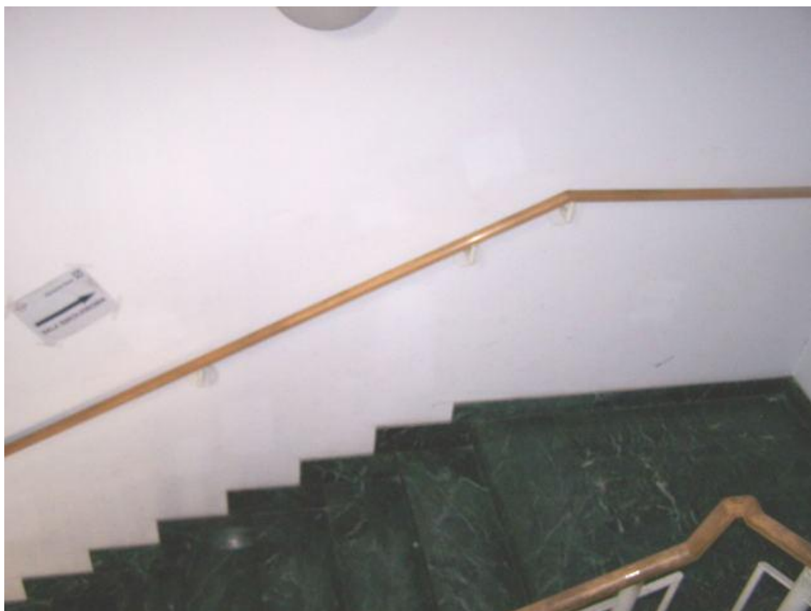
Fot. 83. II piętro – zarysowania ścian klatki schodowej prowadzącej do banku
