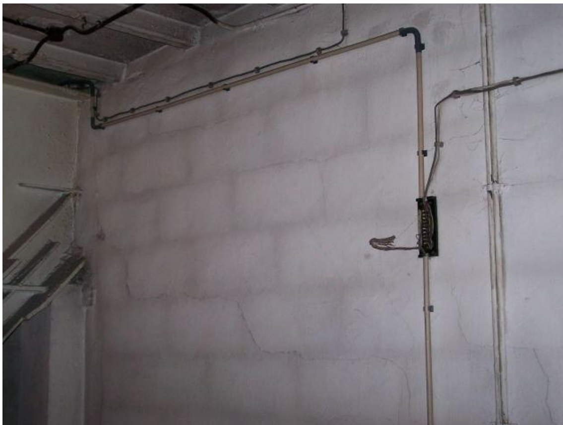
Fot.111 Poziom techniczny nad sceną – spękania ścian, przemarzanie
