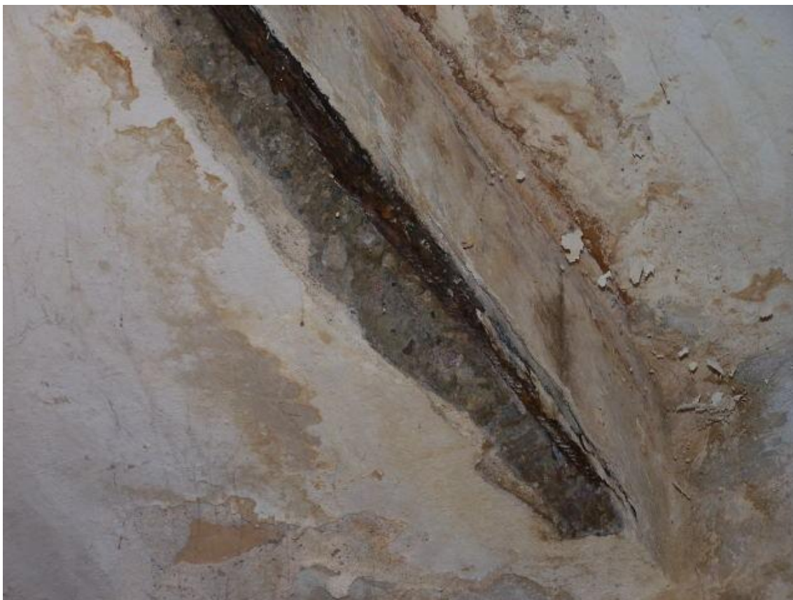
Fot.43 Piwnica – przykładowe zagrzybienie i zawilgocenie ścian, korozja zbrojenia podciagu (narożnik południowo – zachodni)
