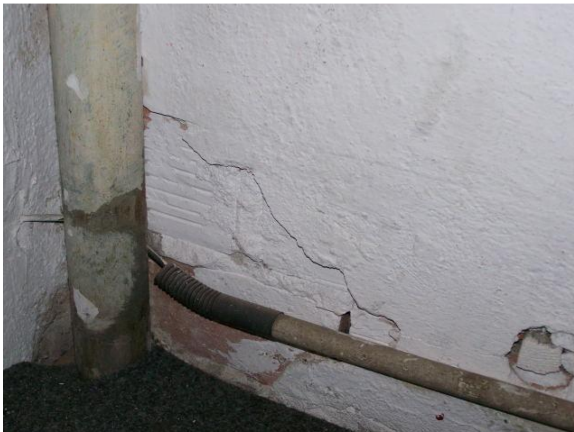
Fot. 97. II piętro – zarysowania i zawilgocenie ścian zewnętrznych
