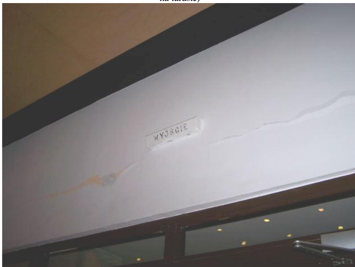
Fot.62. Parter – zarysowania ściany działowej przy wejściu do teatru
