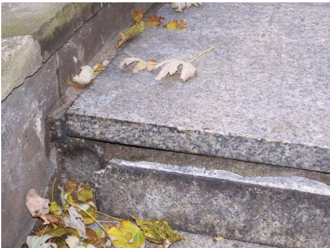
Fot. 144 Elewacja tylna teatru – odspojenia płytek w strefie cokołu
