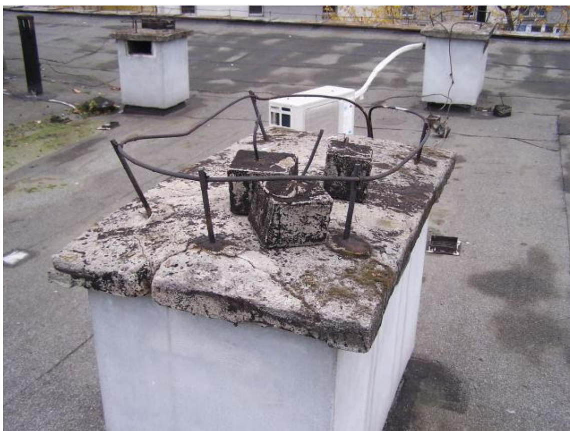
Fot. 130 Dach – przykładowe spękania czap kominowych
