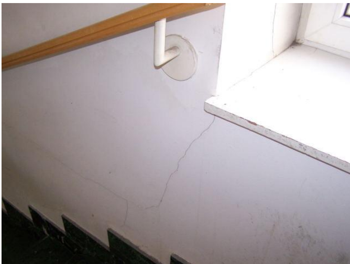
Fot.84. II piętro – zarysowania ścian klatki schodowej prowadzącej do banku
