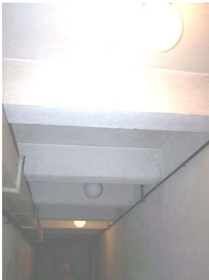
Fot.13. Piwnica – Widok stropu płytowo – żebrowego
