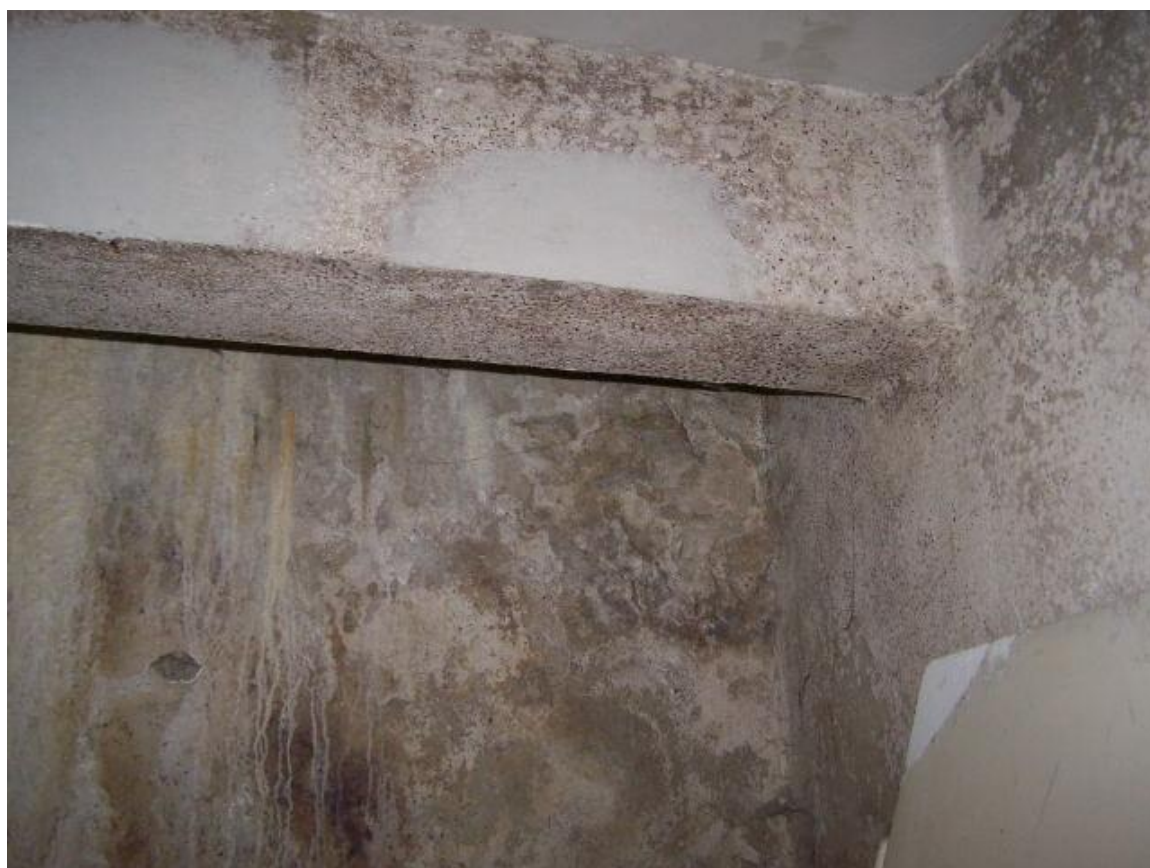
Fot. 16. Piwnica - przykładowe zawilgocenie i zagrzybienie ścian piwnicznych (w pomieszczeniu skrajnym w trakcie przy placu Grzybowskiem)
