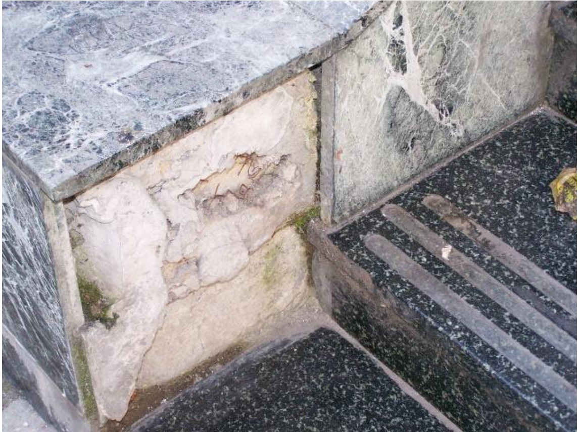
Fot.145 Elewacja boczna – odspojenia płytek w strefie cokołu
