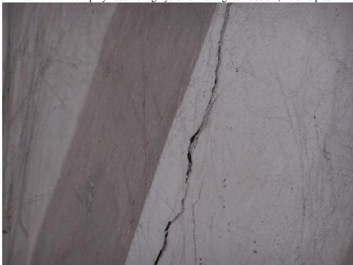
Fot.42. Piwnica – zarysowania w korytarza, odspojenie ścianek działowych
