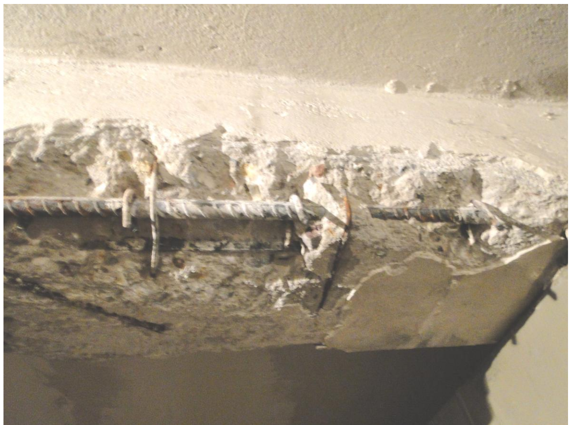
Fot. 2.4. Odkrywka nr 4 - podciąg główny w narożniku południowym
