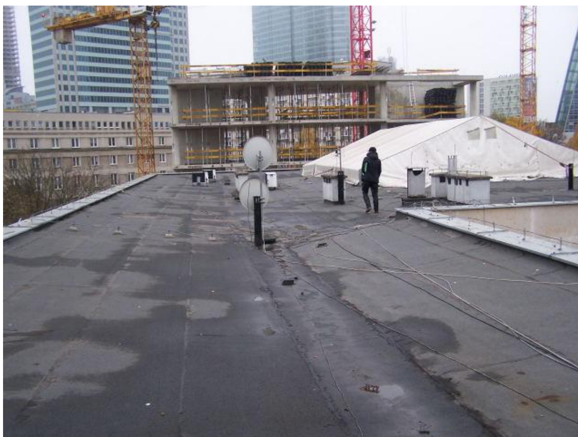
Fot. 122 Dach - widok ogólny, widoczne zastoiny wody
