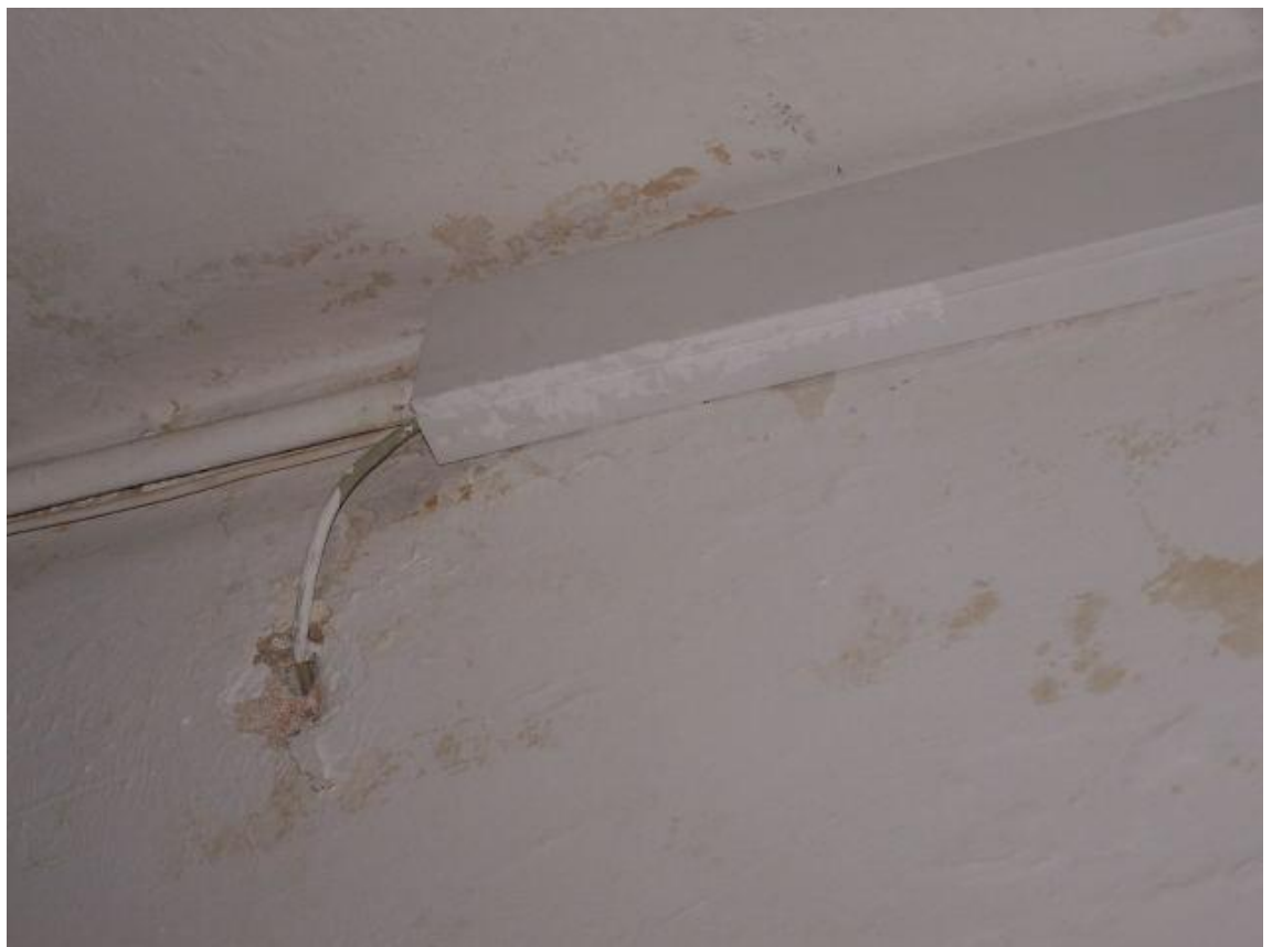
Fot.90. II piętro – zacieki na ścianach i suficie (stropodach)
