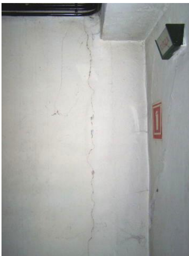
Fot. 104 II piętro – rysa pionowa w ścianie zewnętrznej (elewacja tylna )
