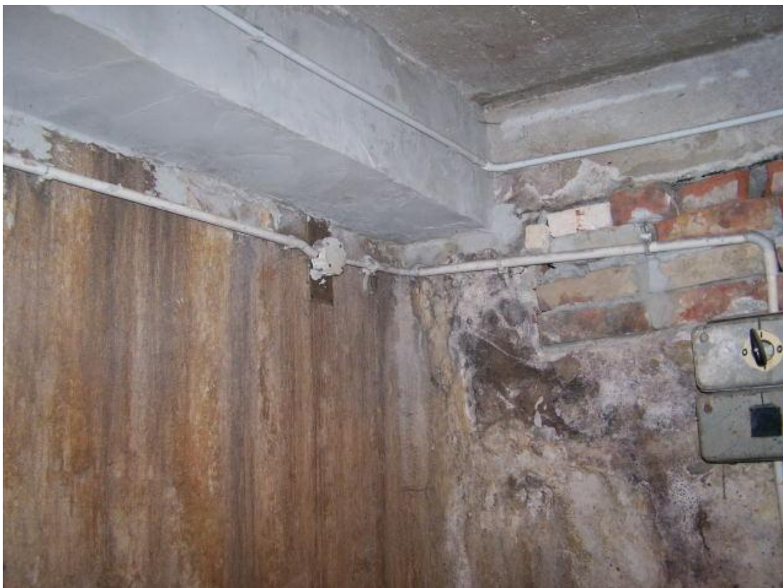
Fot.53 Piwnica – przecieki wody i zawilgocenie ścian w trakcie od strony podwórka
