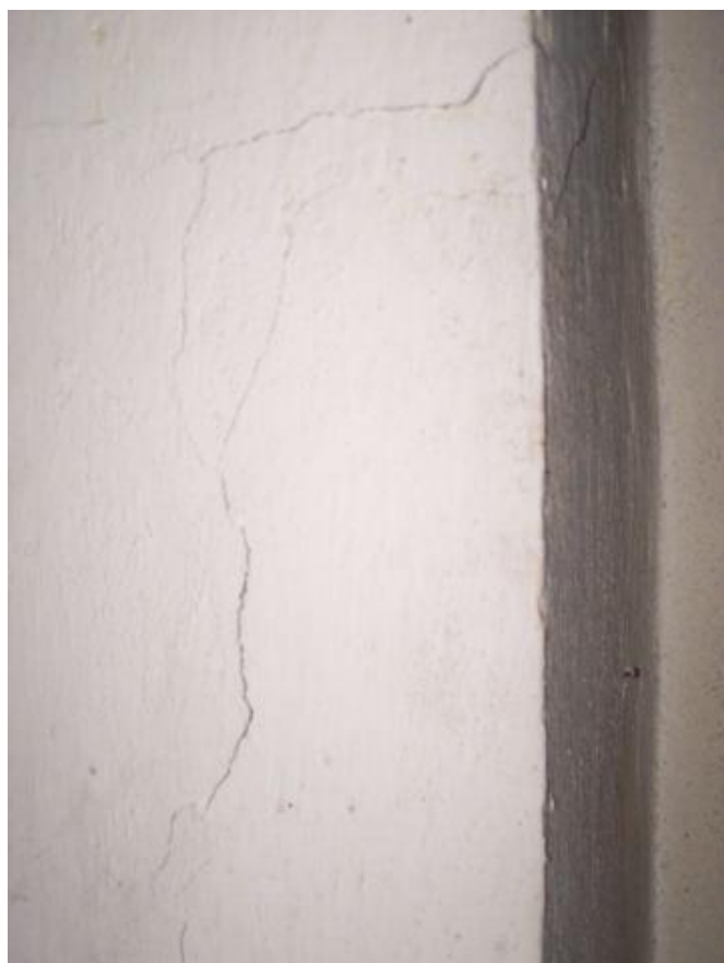
Fot.68. Garderoby teatru( ½ pietra)– rysa ukośna w ścianie działowej
