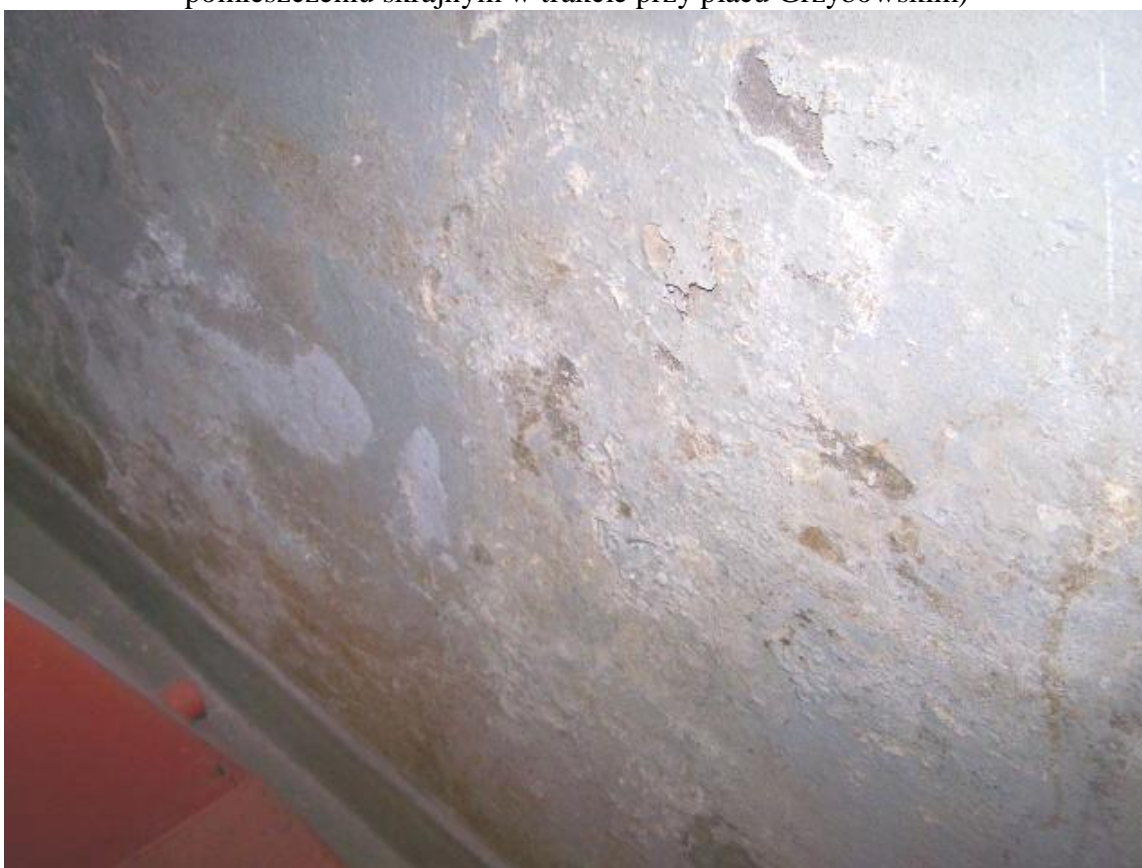
Fot.18 Piwnica - przykładowe zawilgocenie i zagrzybienie ścian piwnicznych(w pomieszczeniu skrajnym w trakcie przy placu Grzybowskiem)
