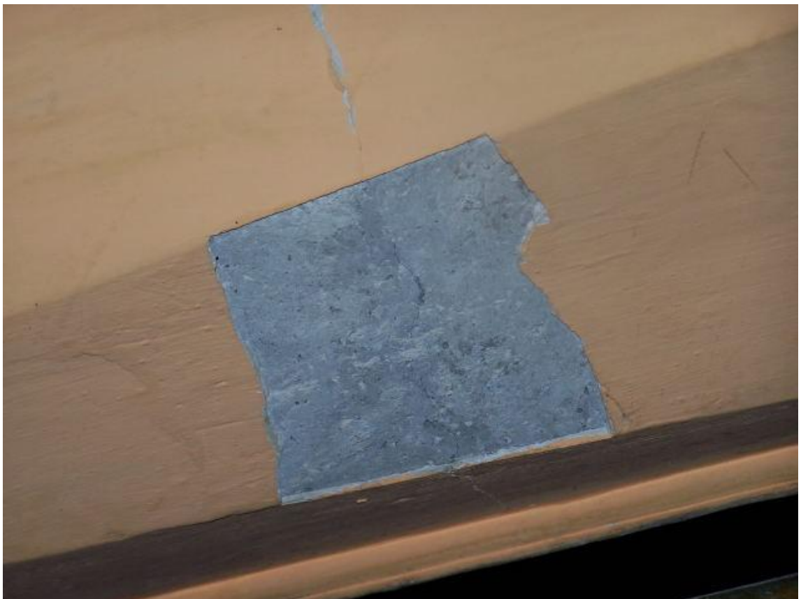
Fot. 2.12. Odkrywka nr 11 – zarysowany bieg schodów wspornikowych w holu Teatru Żydowskiego
