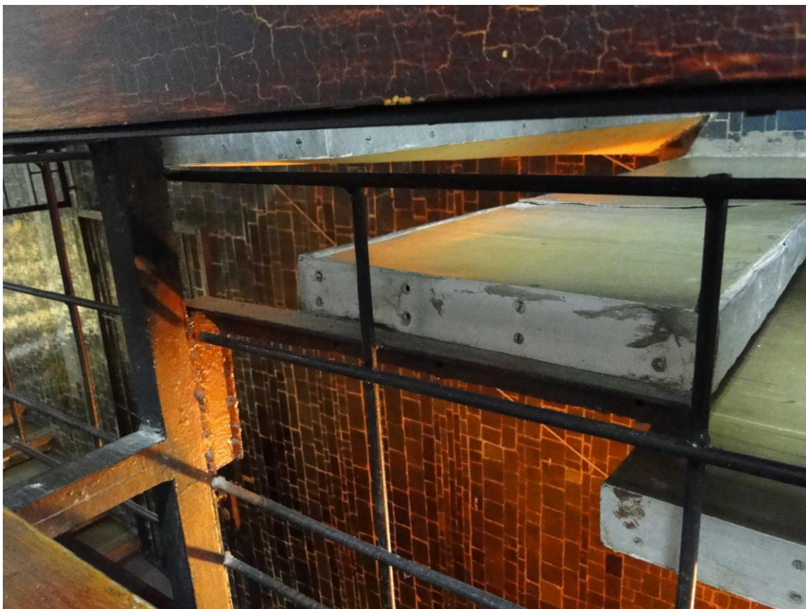
Fot.71. I piętro – zarysowanie stopni wspornikowych schodów , wadliwe podparcie stopni
