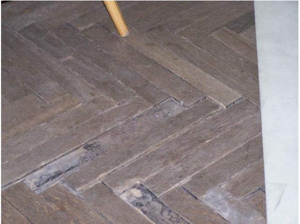
Fot. 95. II piętro – zniszczenia podłogi w sali ćwiczeń teatru
