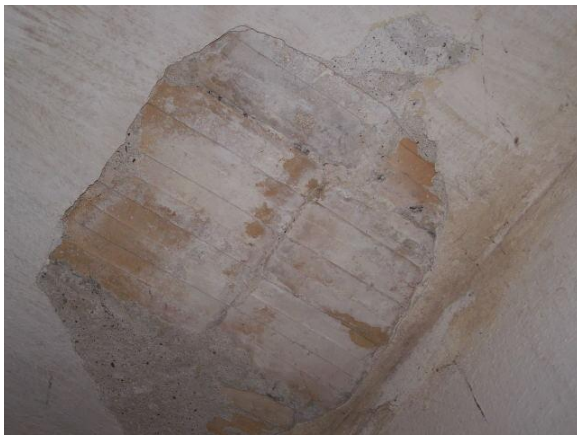
Fot.30 Piwnica – przykładowe zagrzybienie i zawilgocenie ścian i stropu w pomieszczeniu w trakcie północno – wschodnim, odspojenie tynku, widoczne pustaki Akermana
