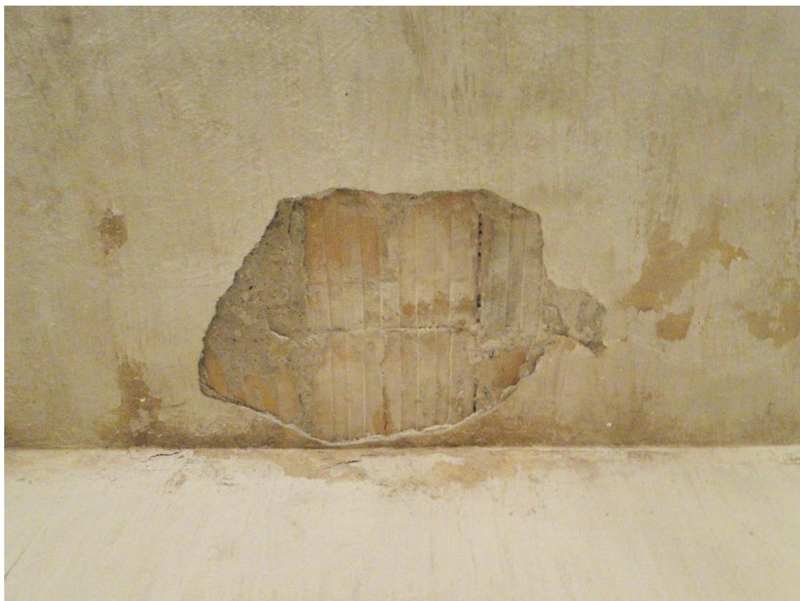
Fot. 2.7. Odkrywka nr 6 – strop Akermana nad piwnicą
