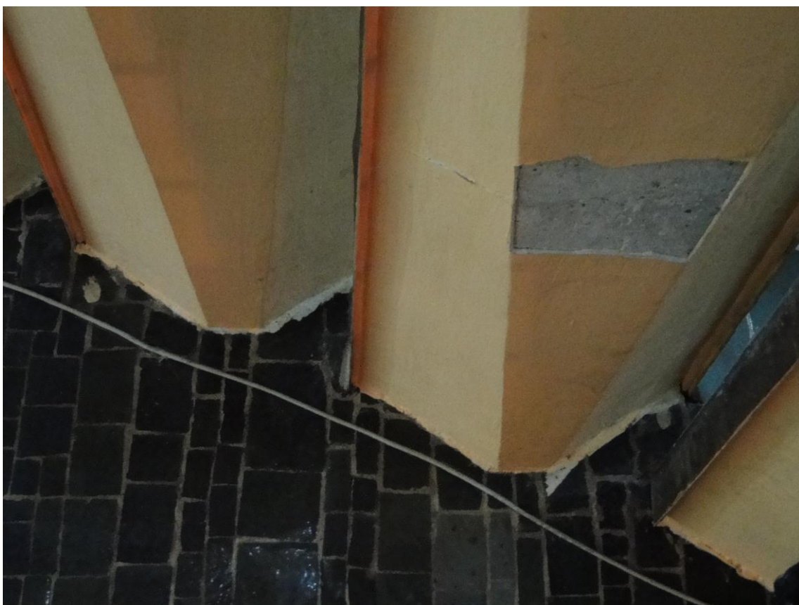
Fot. 70 I piętro I piętro – zarysowanie stopni wspornikowych schodów
