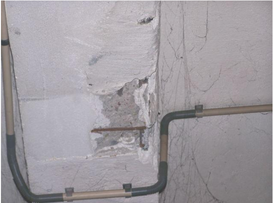
Fot.49 Piwnica – ubytki otuliny i korozja zbrojenia podciagu
