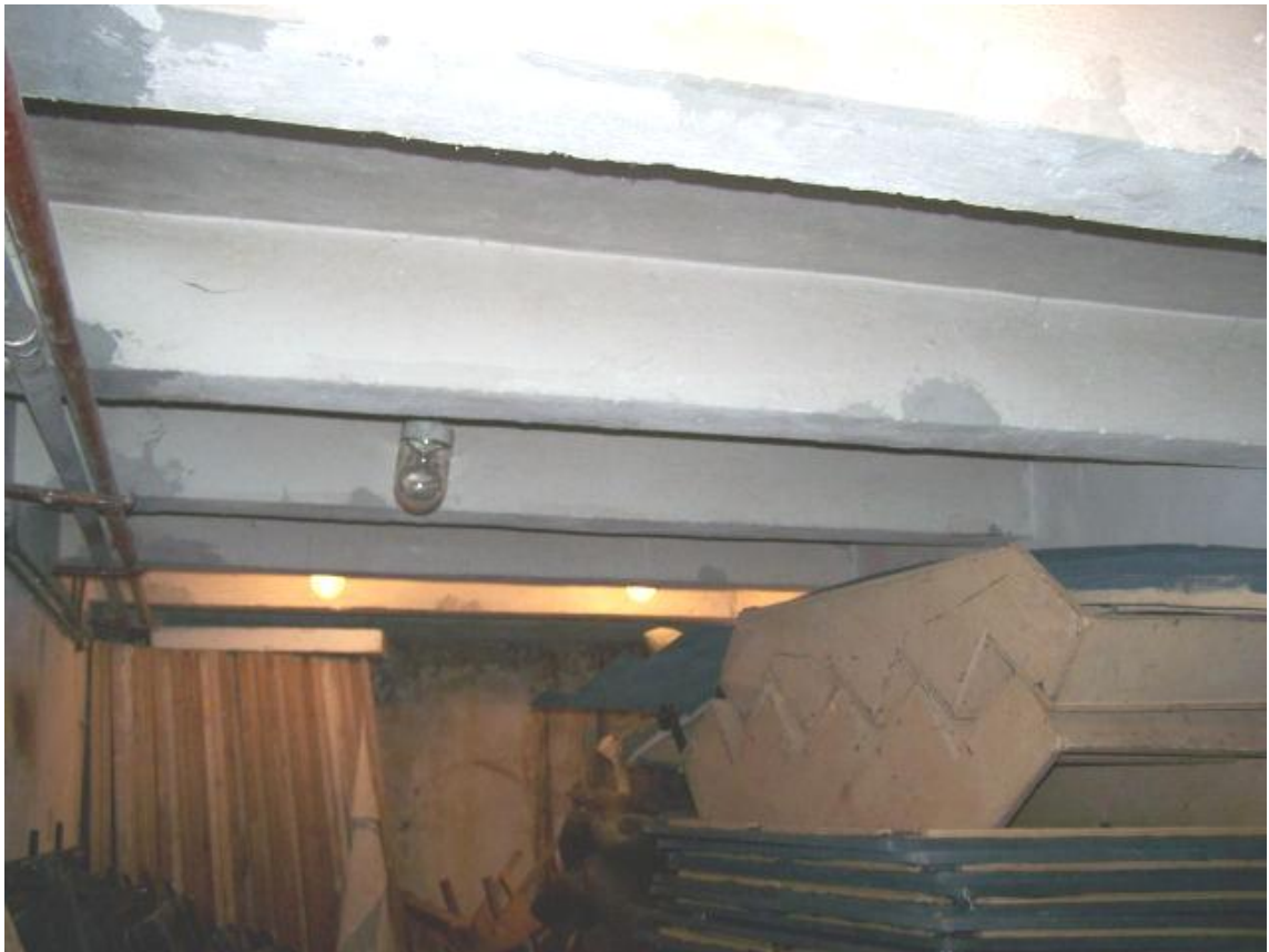
Fot.55 Piwnica – naprawiane żebra w pomieszczeniu pod podwórkiem
