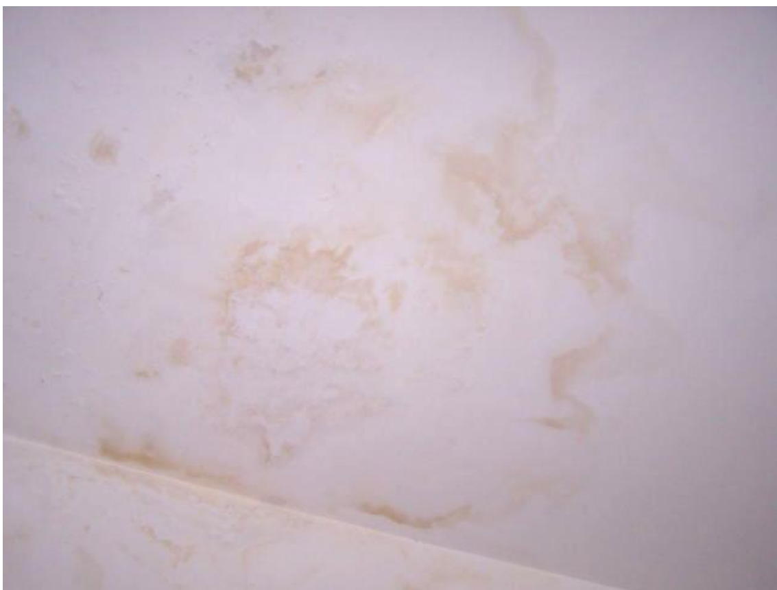
Fot.88. II piętro – zacieki na suficie
