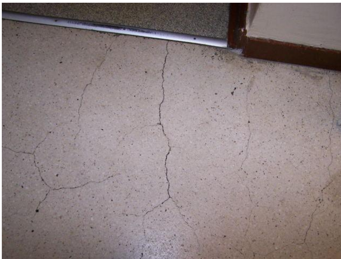
Fot.92. II piętro – zarysowania posadzki podestu schodów
