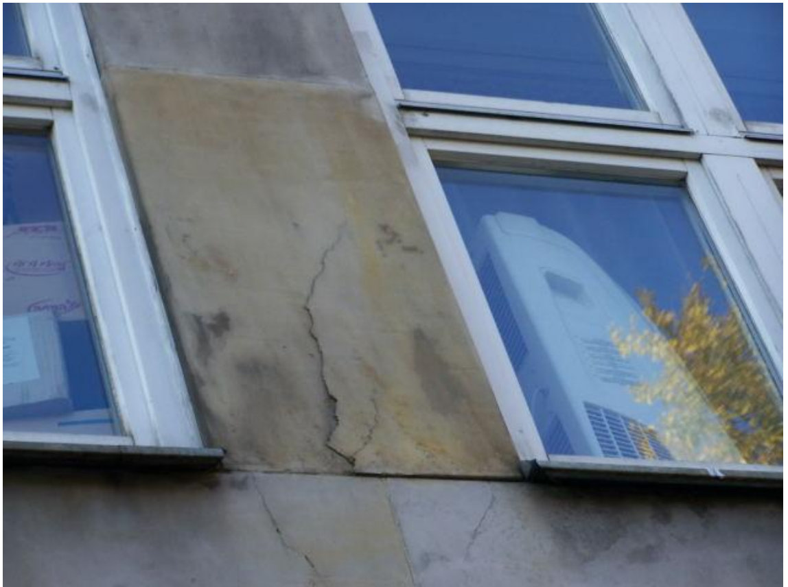
Fot. 146. Elewacja boczna - spękania okładziny kamiennej
