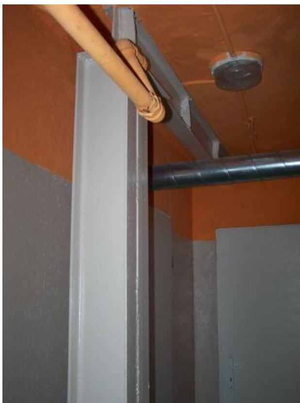
Fot.6. piwnice - widok wzmocnień stalowych
