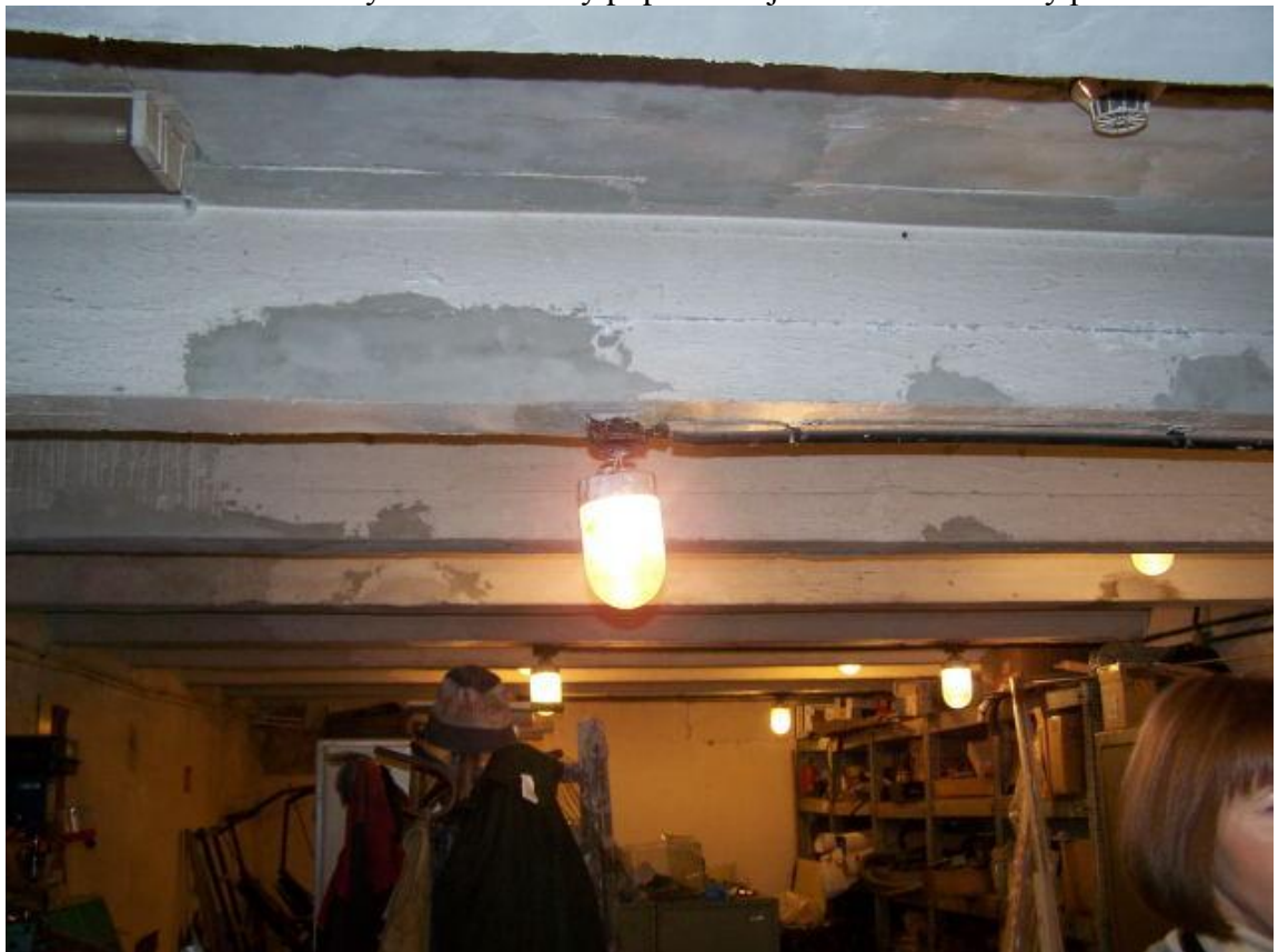
Fot.52 Piwnica – naprawiane żebra w trakcie od strony podwórka
