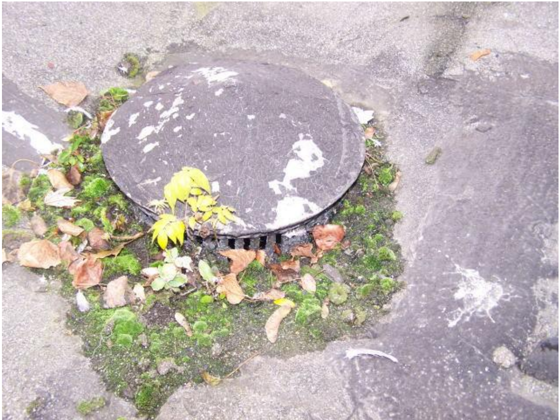
Fot. 127 Dach – zanieczyszczone odpływy wody
