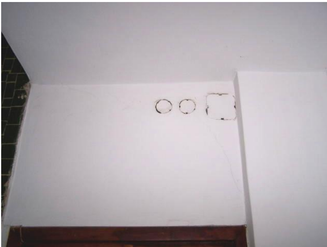
Fot.73. I piętro – zarysowania ściany pomiędzy holem a salą ćwiczeń
