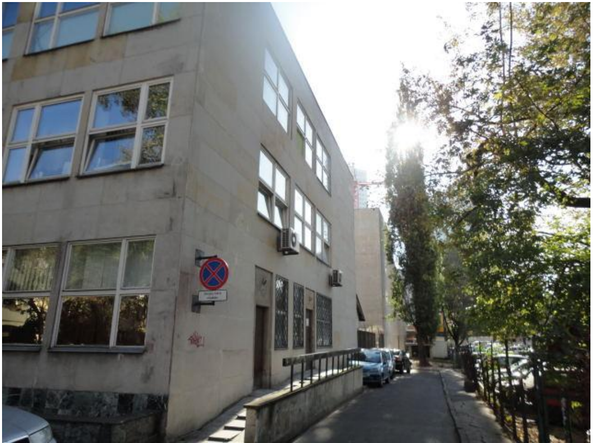
Fot. 3 Elewacja tylna (północno - zachodnia)
