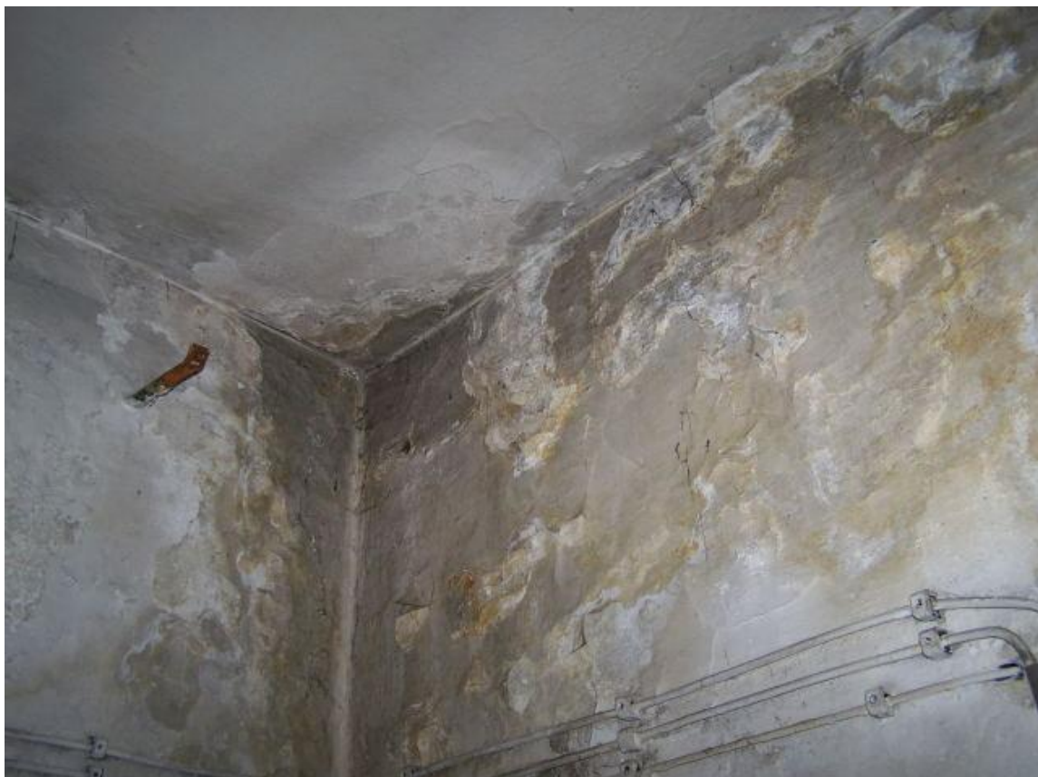
Fot.39. Piwnica – przykładowe zagrzybienie i zawilgocenie ścian, korozja tynku
