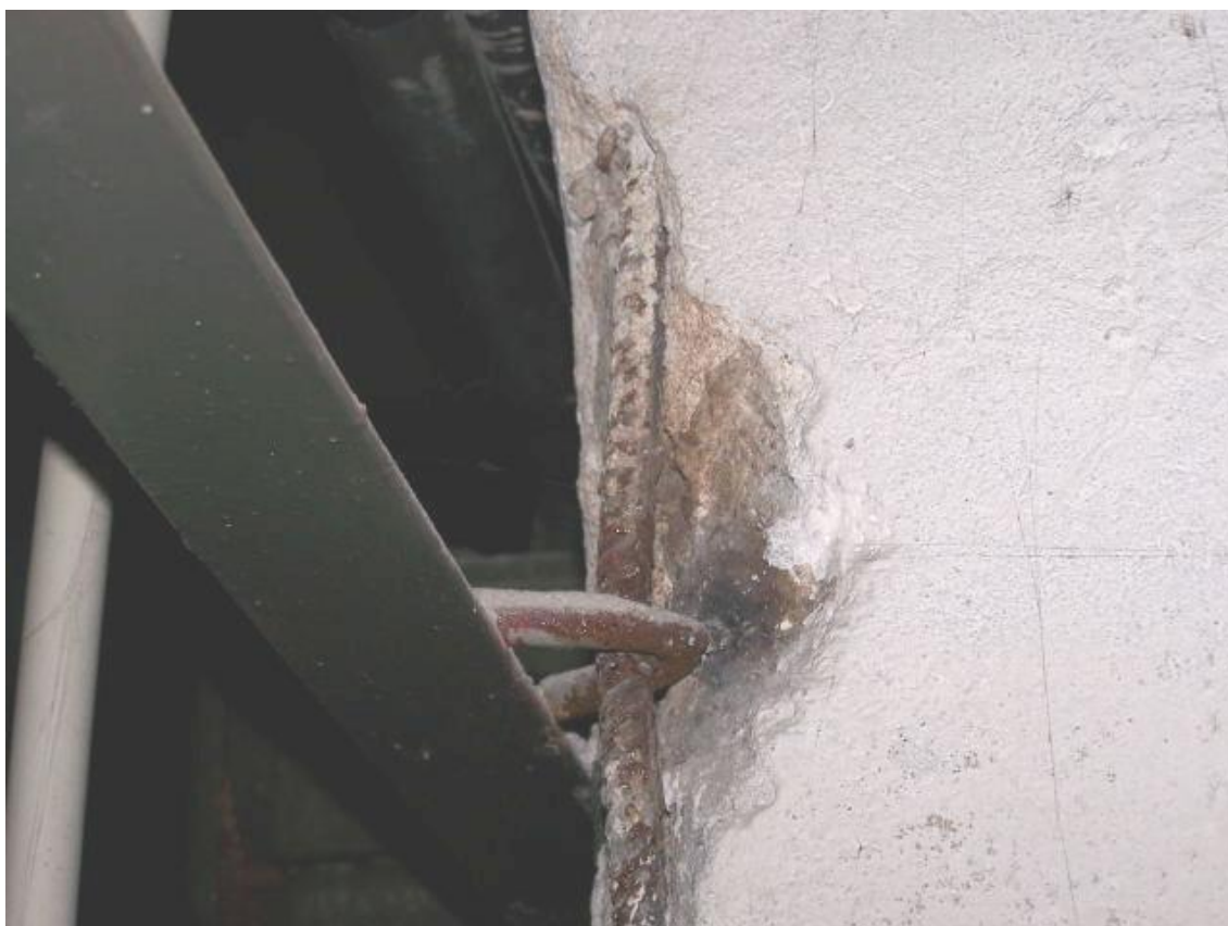
Fot.47 Piwnica – mocowanie do elementów konstrukcyjnych...
