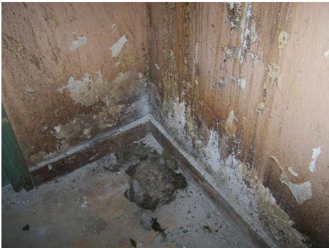
Fot.7. Piwnice – zagrzybienie i zawilgocenie ścian
