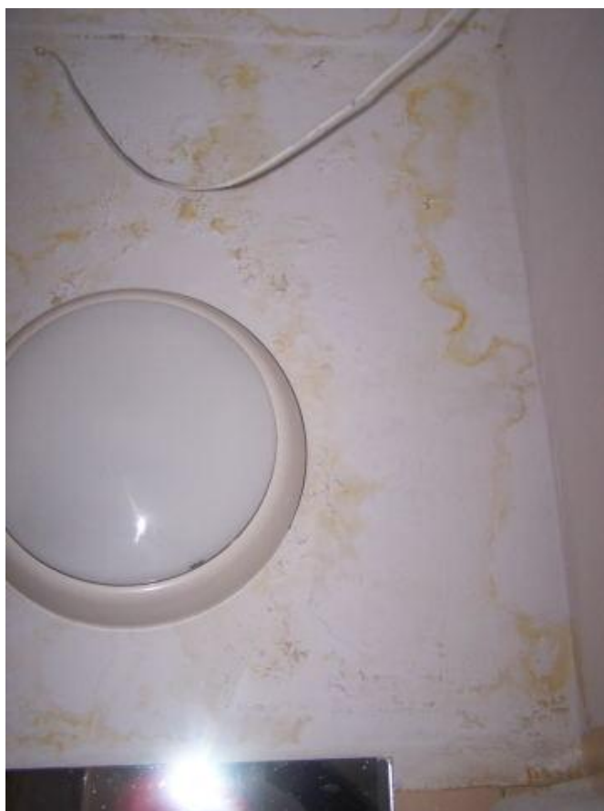
Fot.67 Garderoby teatru( ½ pietra) – zacieki na ścianie kominowej
