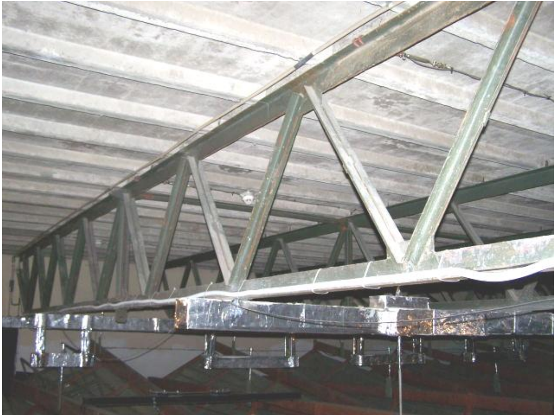
Fot.99 II piętro – dźwigary stalowe - konstrukcja przekrycia nad widownią
