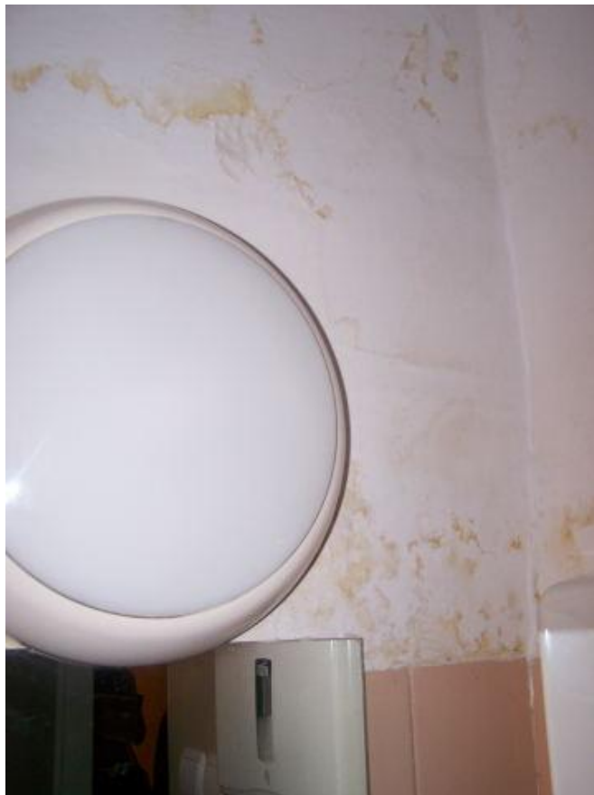
Fot.78 Garderoby teatru( 1 ½ pietra) – zacieki na ścianie kominowej
