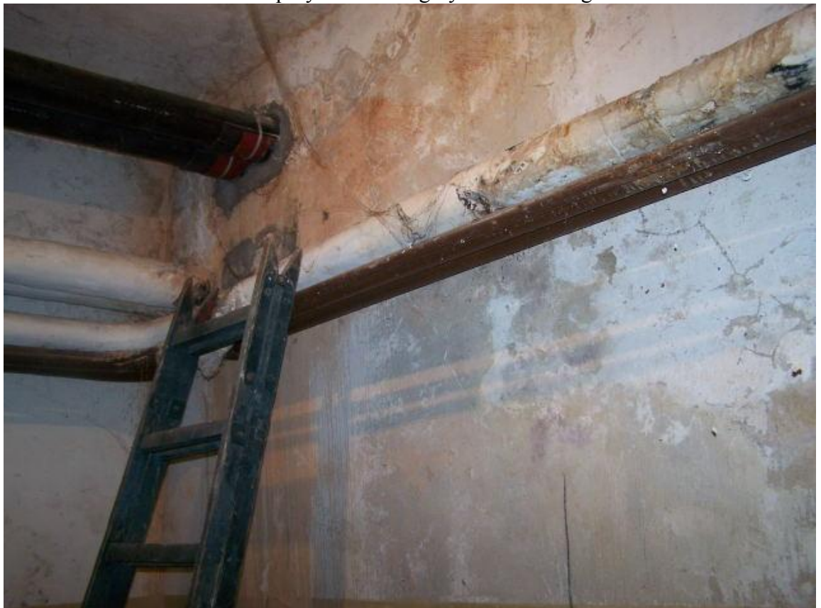
Fot.46. Piwnica - przykładowe zagrzybienie i zawilgocenie ścian, trakt od strony elewacji tylnej
