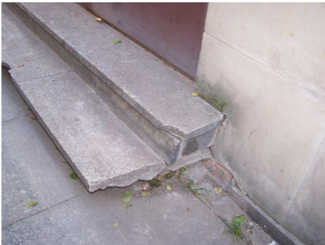
Fot.137 Elewacja tylna teatru – spękania schodów, odspojenia i zawilgocenie płytek w strefie cokołu
