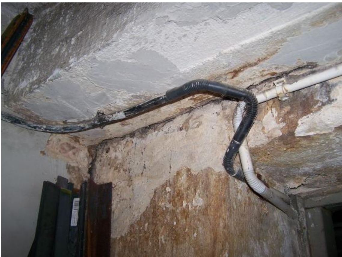
Fot.54 Piwnica - przykładowe zagrzybenie i zawilgocenie ścian, trakt od strony podwórka
