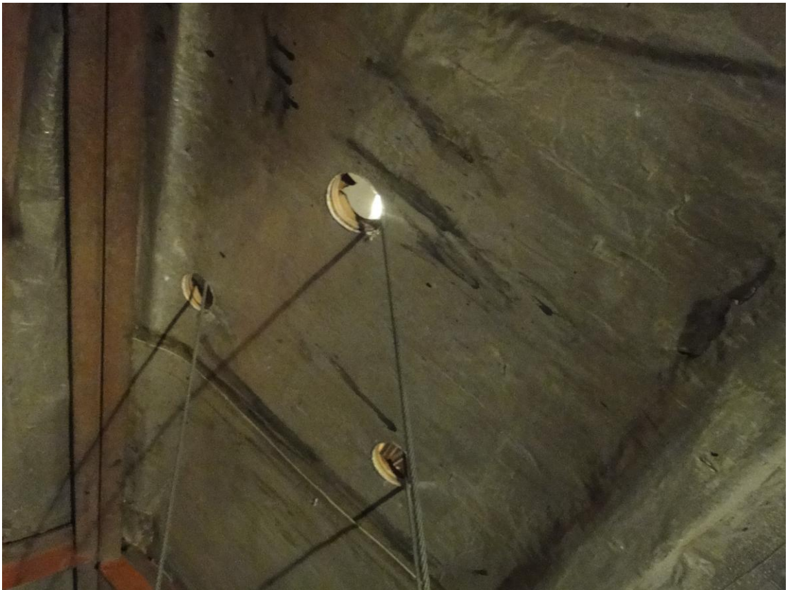
Fot. 118 Poziom techniczny nad sceną - konstrukcja przekrycia
