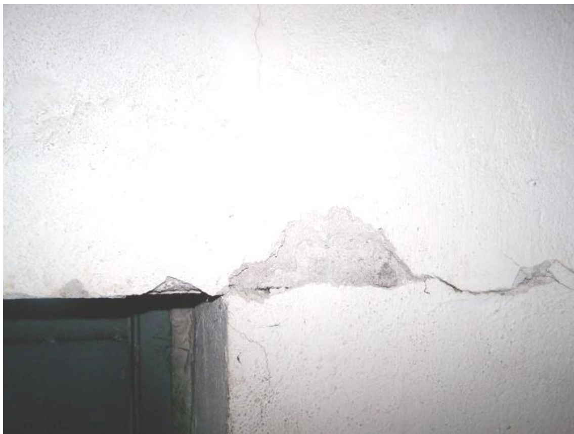
Fot.109 Poziom techniczny nad sceną – spękania ściany zewnętrznej (kolankowa dachu)
