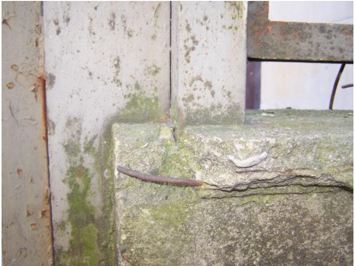
Fot.139 Elewacja tylna teatru – zawilgocenie i porośnięcie mchami i porostami ścian, w strefie cokołu
