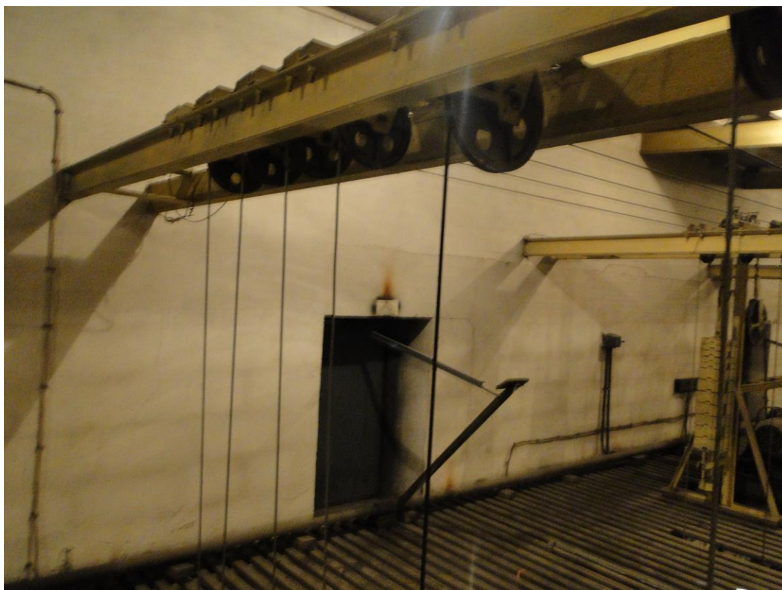
Fot. 116 Poziom techniczny nad sceną – podwieszane elementy dekoracji teatralnych
