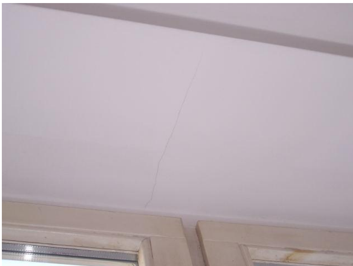
Fot. 82 I piętro – restauracja „Magat”, rysy w nadprożu okiennym
