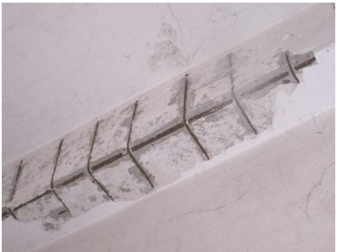
Fot. 2.6. Odkrywka nr 5 - strop gęstożebrowy Akermana – Żebro
