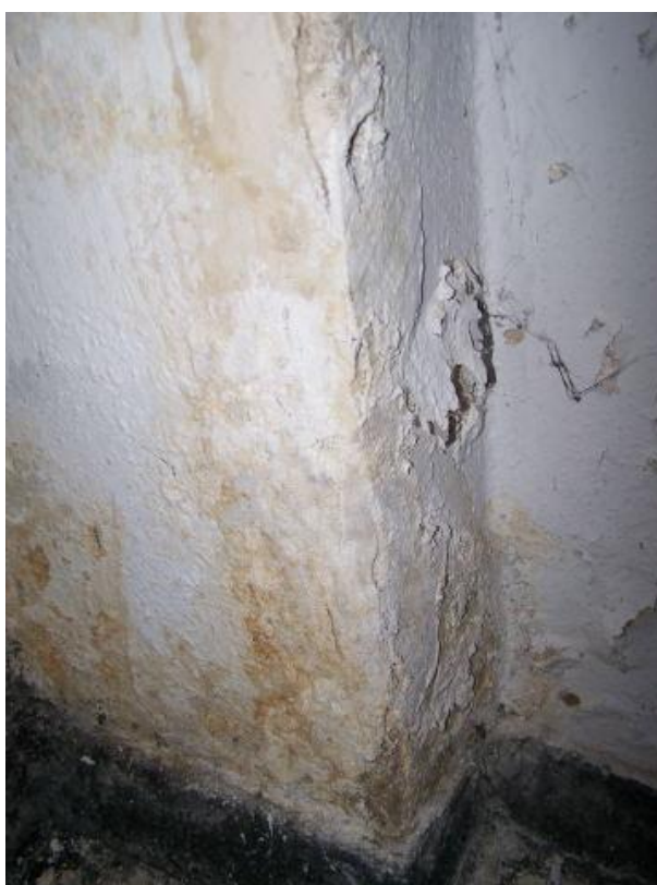
Fot.10 Piwnica – przykładowa korozja biologiczna ścian piwnicznych, odspojenie tynku
