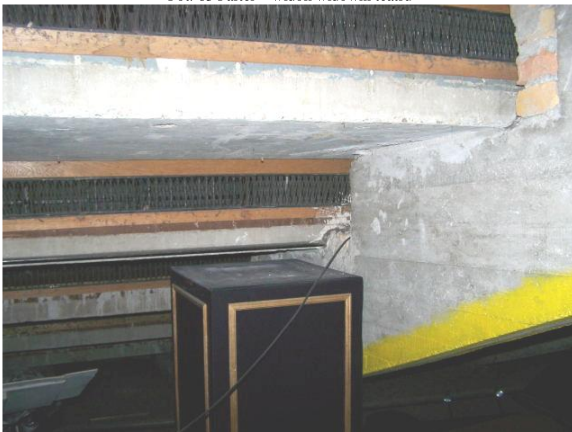
Fot.64. Parter – widok widowni od spodu siedzeń
