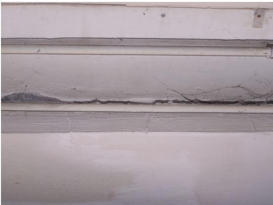
Fot.105 II piętro – zarysowania w strefie nadproży
