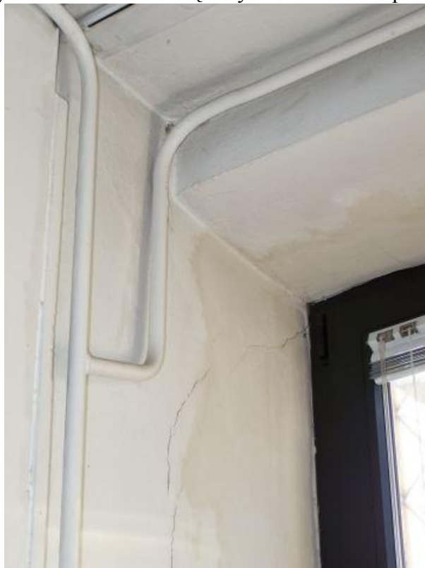
Fot. 94 .II piętro – zarysowania ścian zewnętrznych w strefie nadproży – sala ćwiczeń teatru
