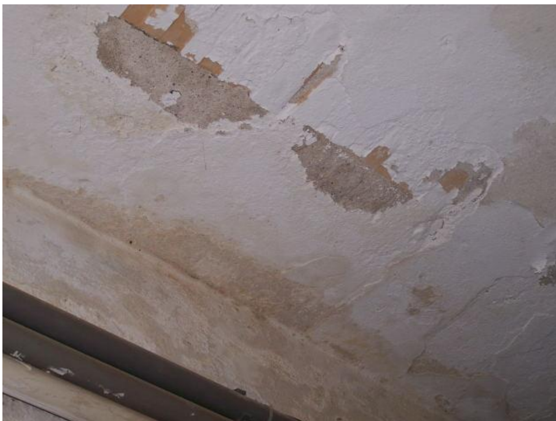
Fot. 25. Piwnica – przykładowe zawilgocenie i zagrzybienie ścian i stropu
