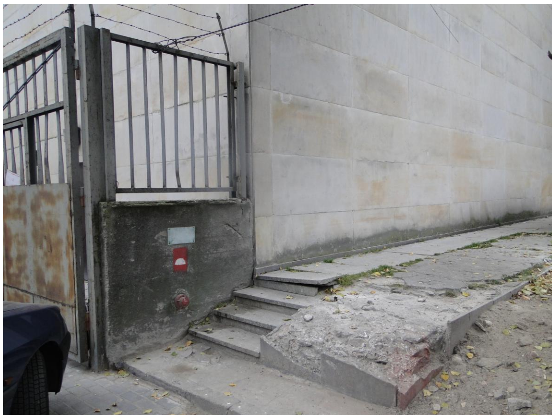
Fot.141 Elewacja od strony podwórka – zniszczone schodki zewnętrzne, spękanie murki oporowe
