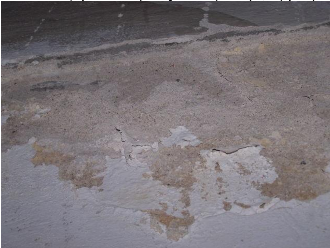
Fot.12. Piwnica – ubytki otuliny, widoczne skorodowane zbrojenie podciagu
