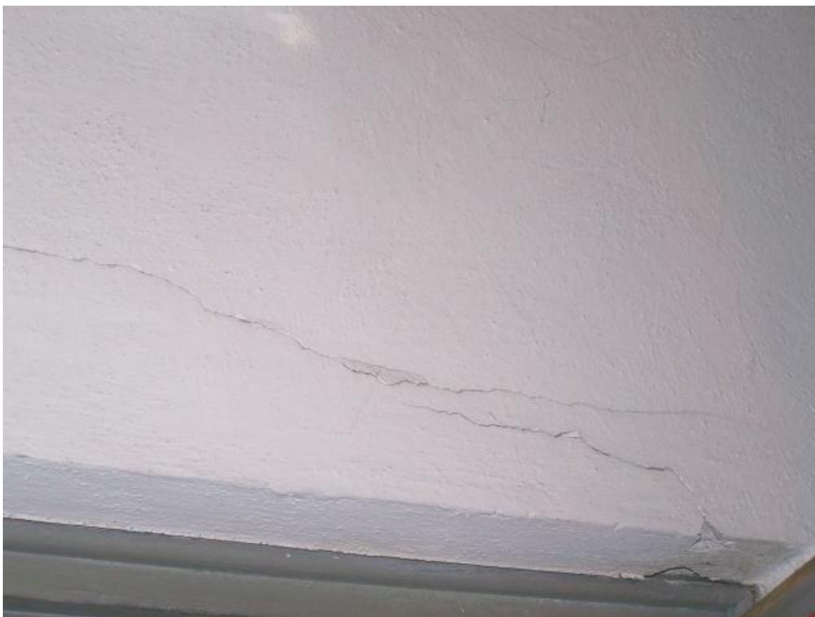
Fot.107 Poziom techniczny nad sceną – spękania ścian
