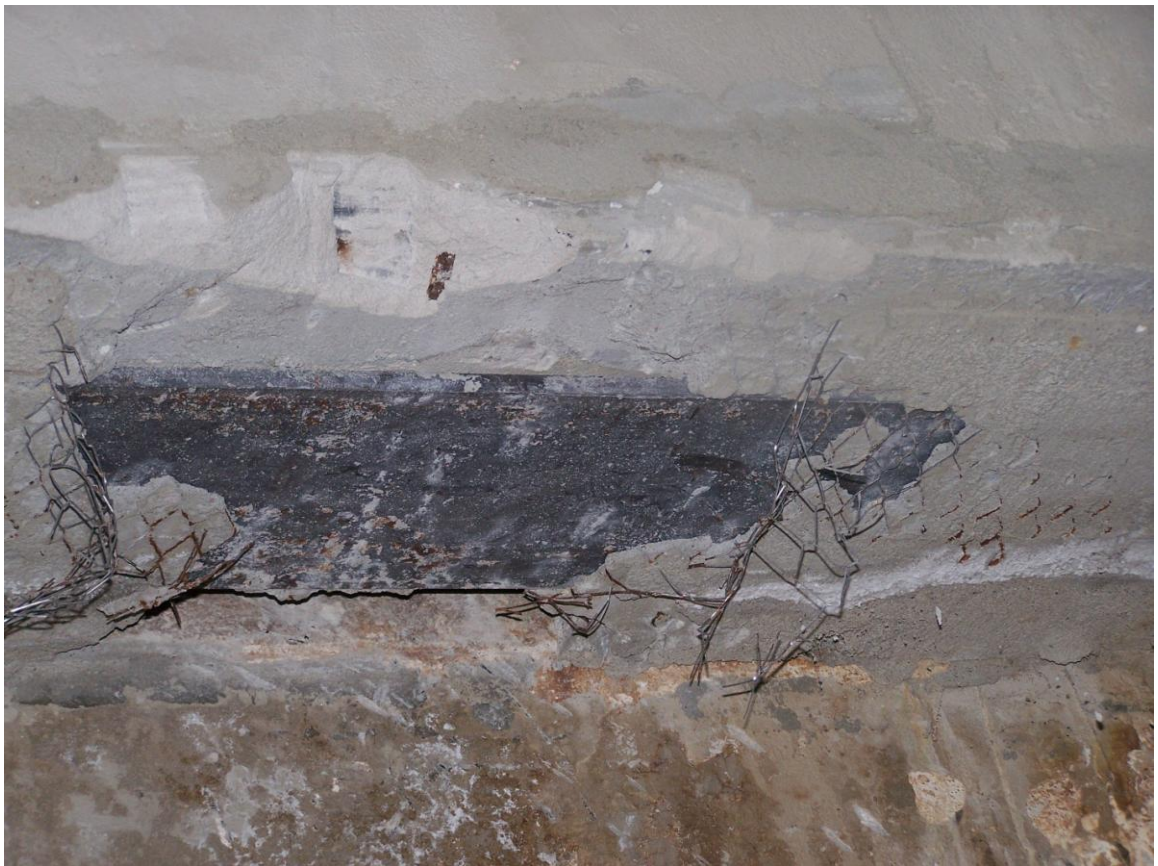
Fot.2.3 . Odkrywka nr 3 – naprawiane żebro stropowe w pomieszczeniu pod podwórkim
