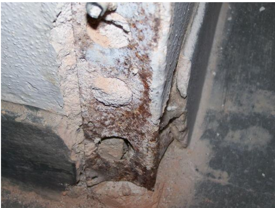
Fot. 23 Piwnica – skorodowana od wilgoci ościeżnica drzwi
