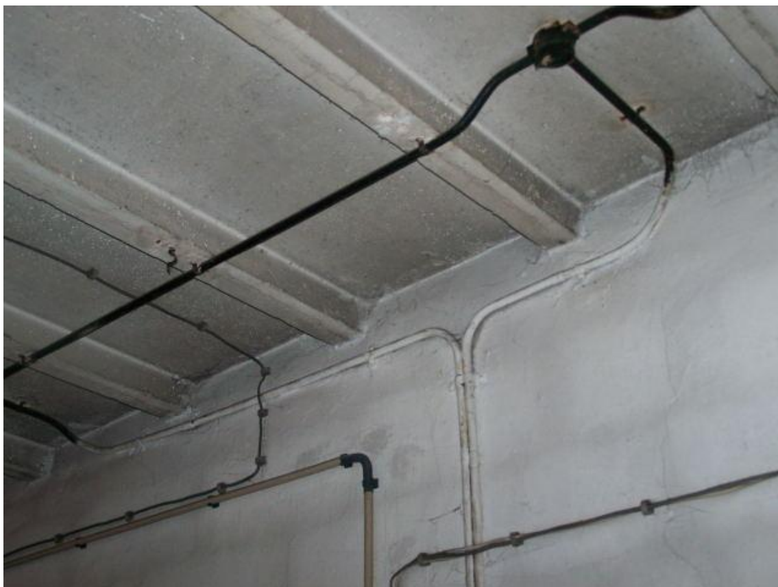
Fot. 112 Poziom techniczny nad sceną - płytki korytkowe dachu, przemarzanie ściany
