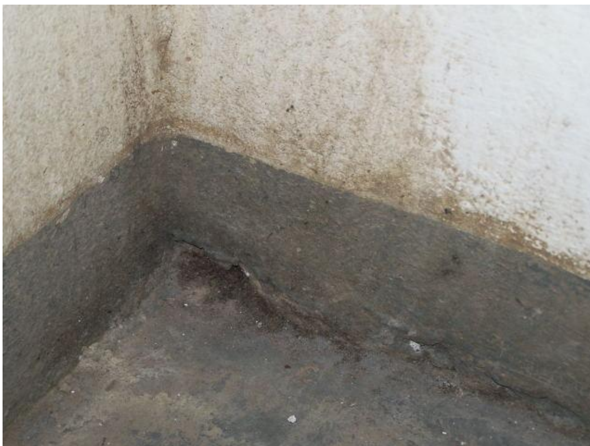
Fot. 21. Piwnica – przykładowe zawilgocenie i zagrzybienie ścian
