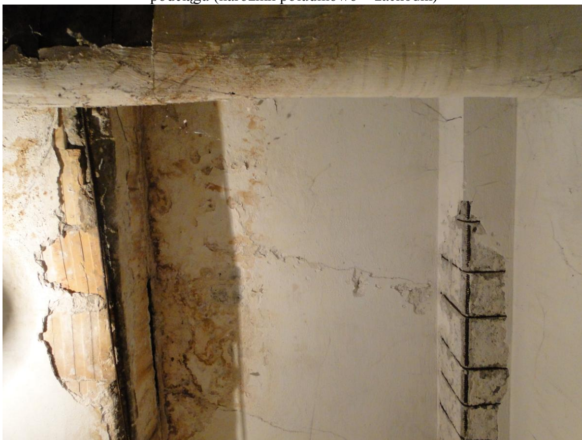
Fot.44. Piwnica – opuszczenie stropu, , korozja zbrojenia (narożnik południowo – zachodni)
