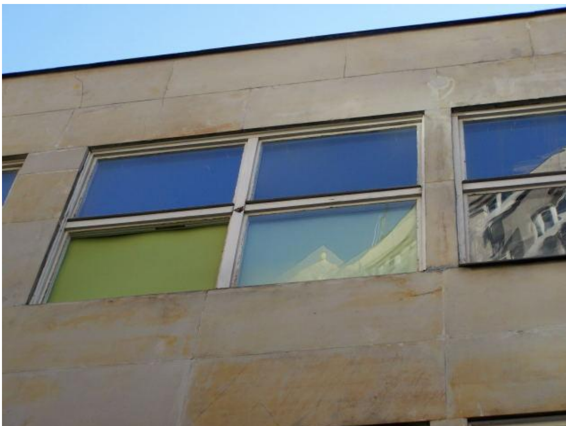
Fot. 142 Elewacja od strony podwórka brak obróbek blacharskich
