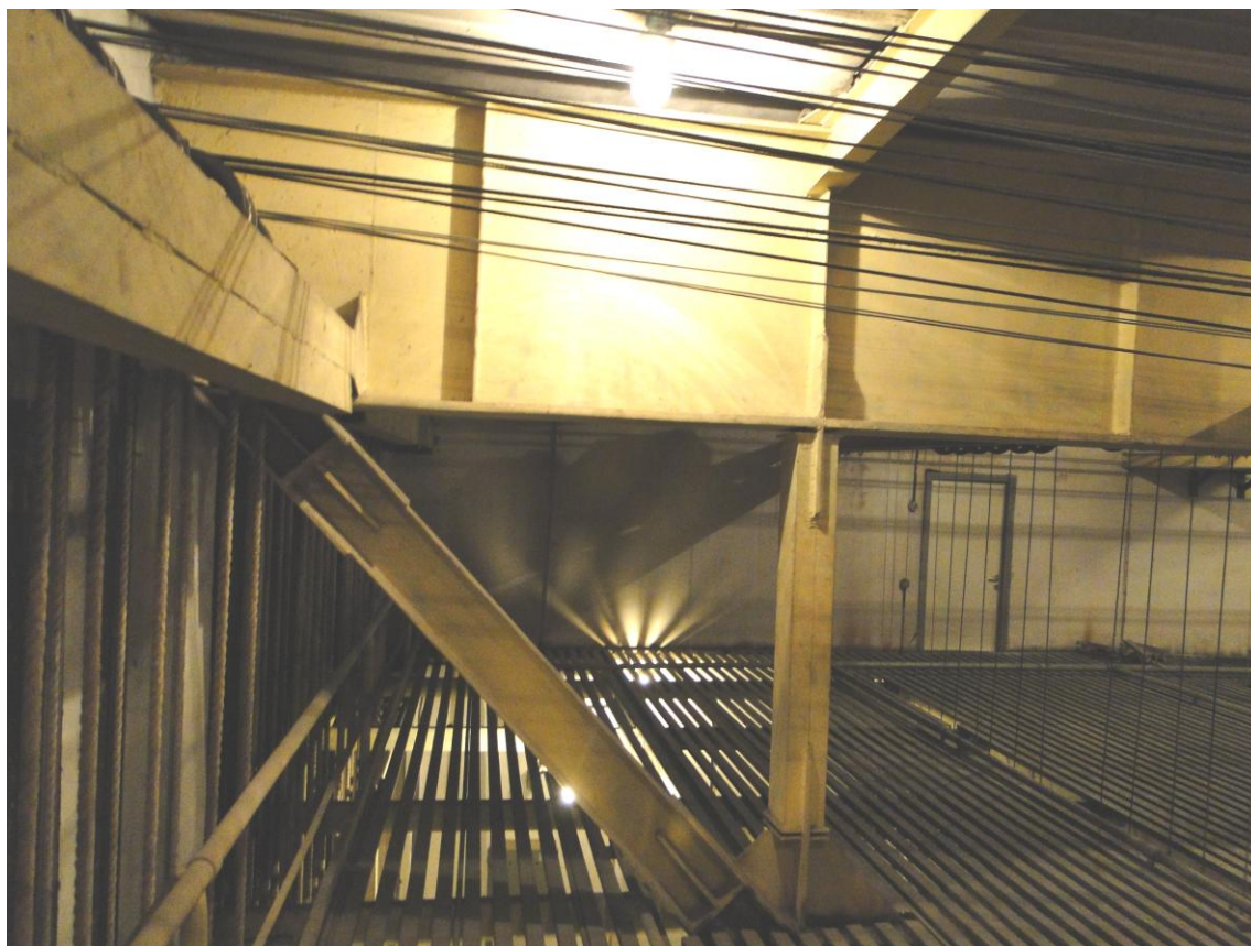
Fot. 120 Poziom techniczny nad sceną - konstrukcja przekrycia
