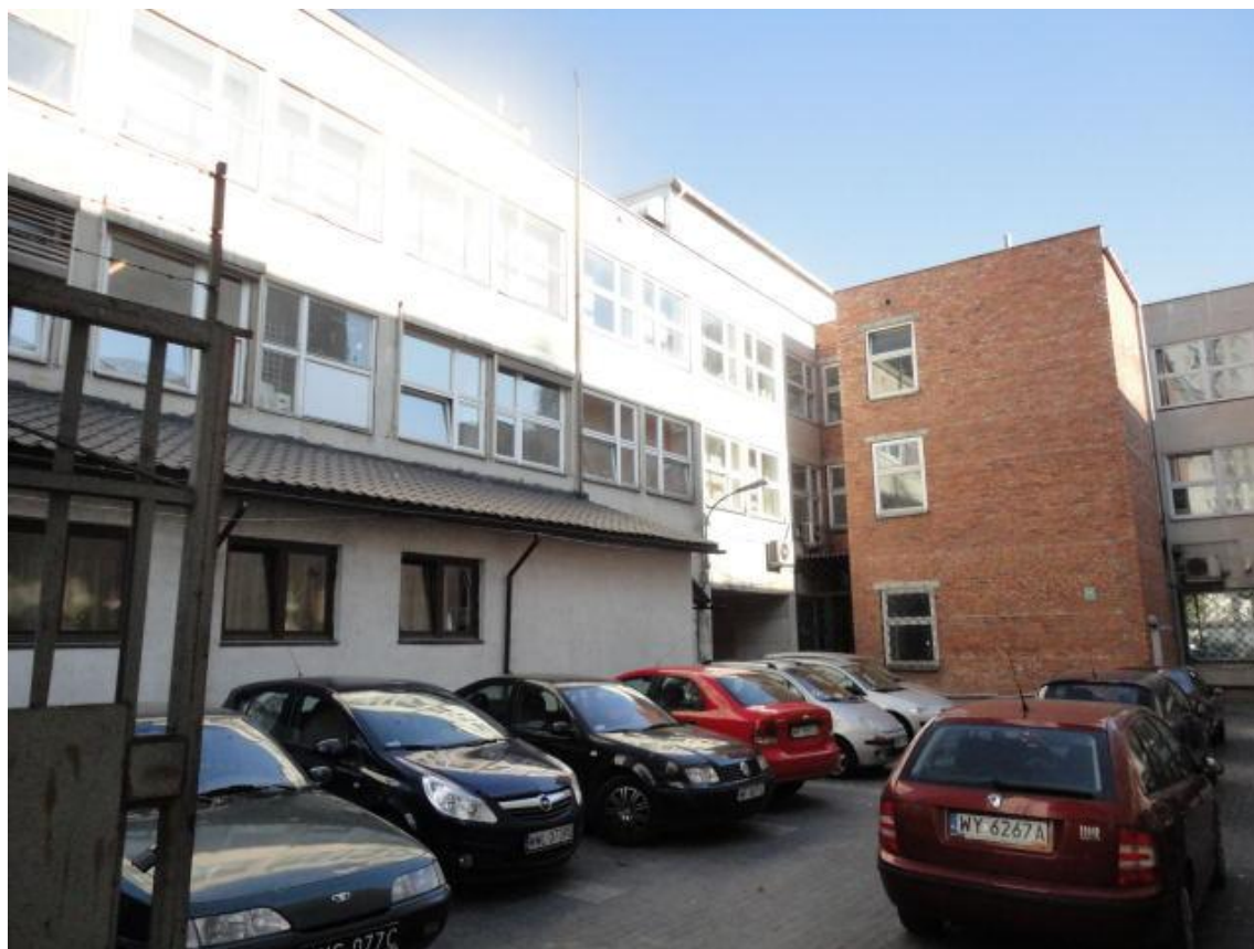
Fot. 148 Elewacja od strony podwórka
