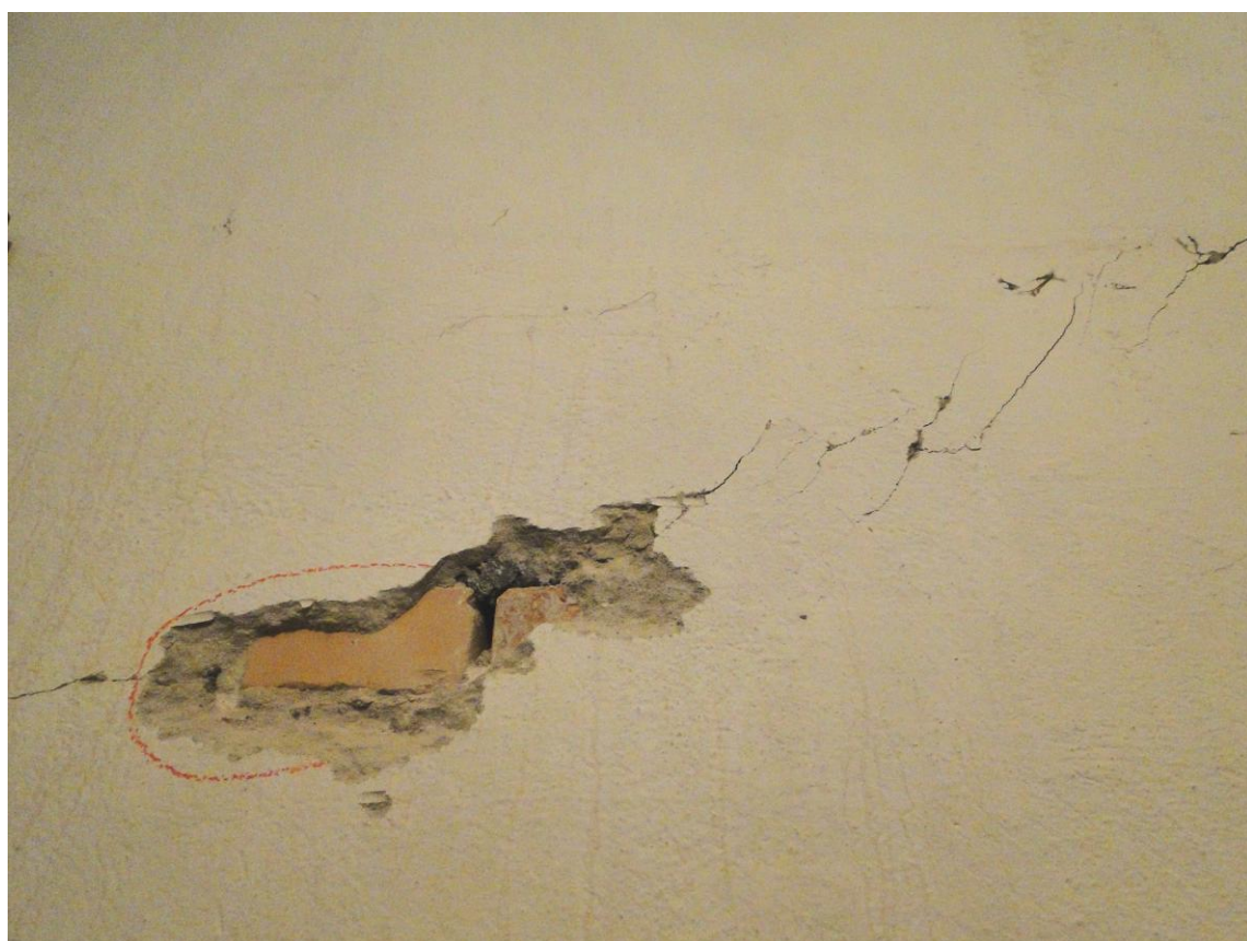
Fot. 2.8. Odkrywka nr 7 - zarysowana ściana prostopadła do elewacji od strony placu Grzybowskiego
