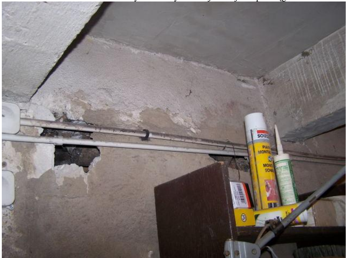
Fot.50. Piwnica - zarysowania ściany od strony podwórka
