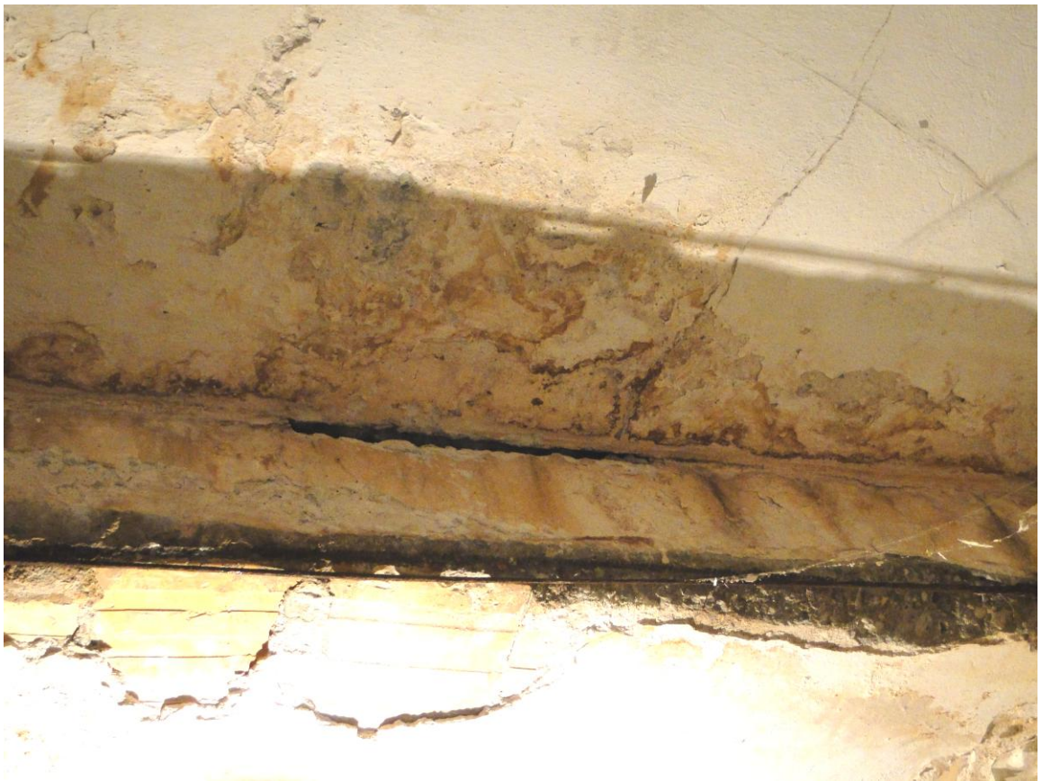
Fot. 2.5. Odkrywka nr 5 - strop gęstożebrowy Akermana – ugięcie stropu
