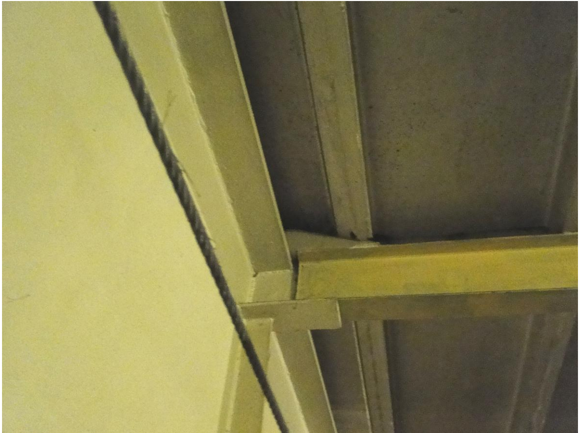
Fot.117 Poziom techniczny nad sceną – oparcie belki stalowej
