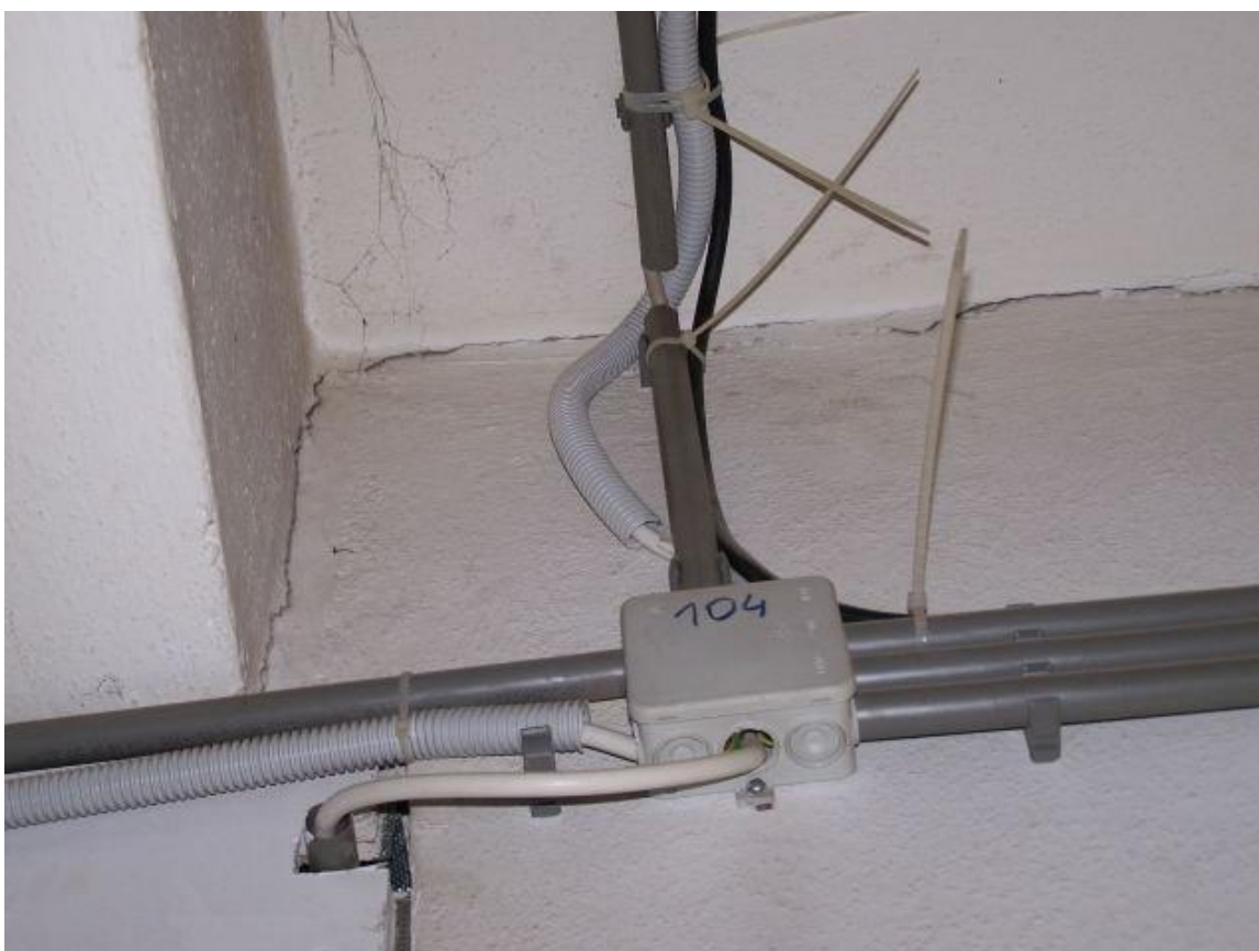
Fot.24. Piwnica – odspojenie od stropu ścian działowych
