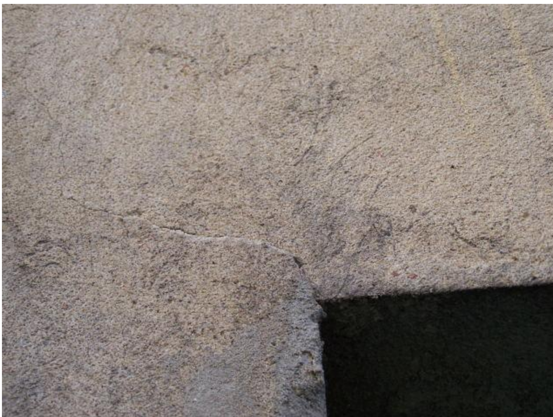
Fot.143 Elewacja od strony podwórka – zarysowania w strefie nadproży
