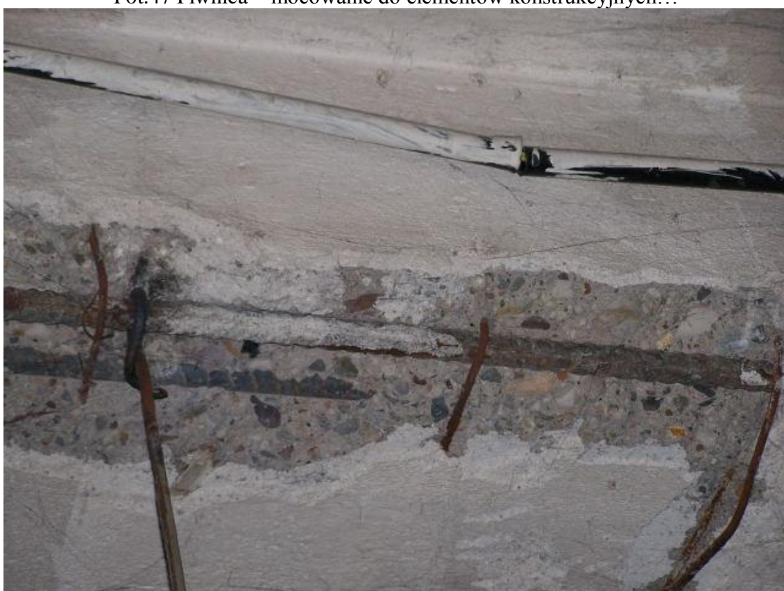
Fot.48. Piwnica – ubytki otuliny i korozja zbrojenia podciagu
