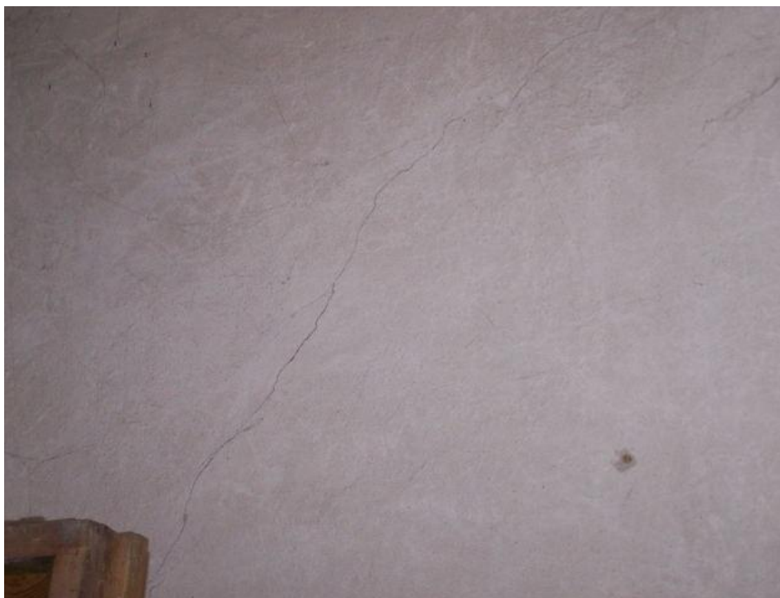
Fot.19. Piwnica – zarysowania ścian działowych w korytarzu
