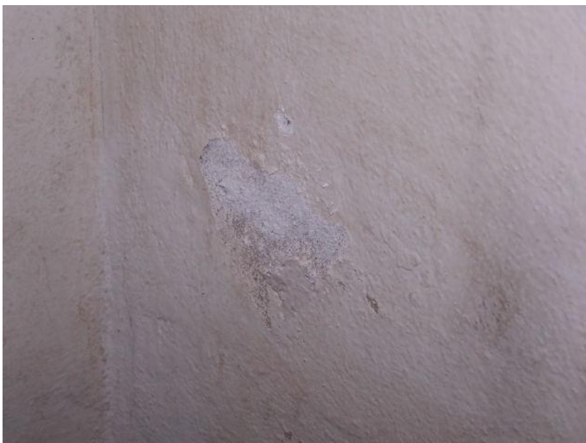
Fot.22. Piwnica – przykładowe zawilgocenie i zagrzybienie ścian
