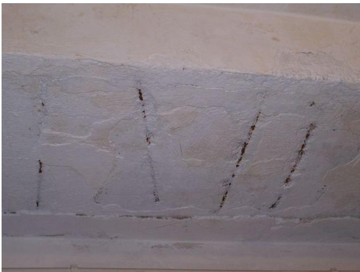
Fot. 26. Piwnica - widoczne skorodowane zbrojenie podciągu (pomieszczenia skrajne od strony elewacji tylnej)
