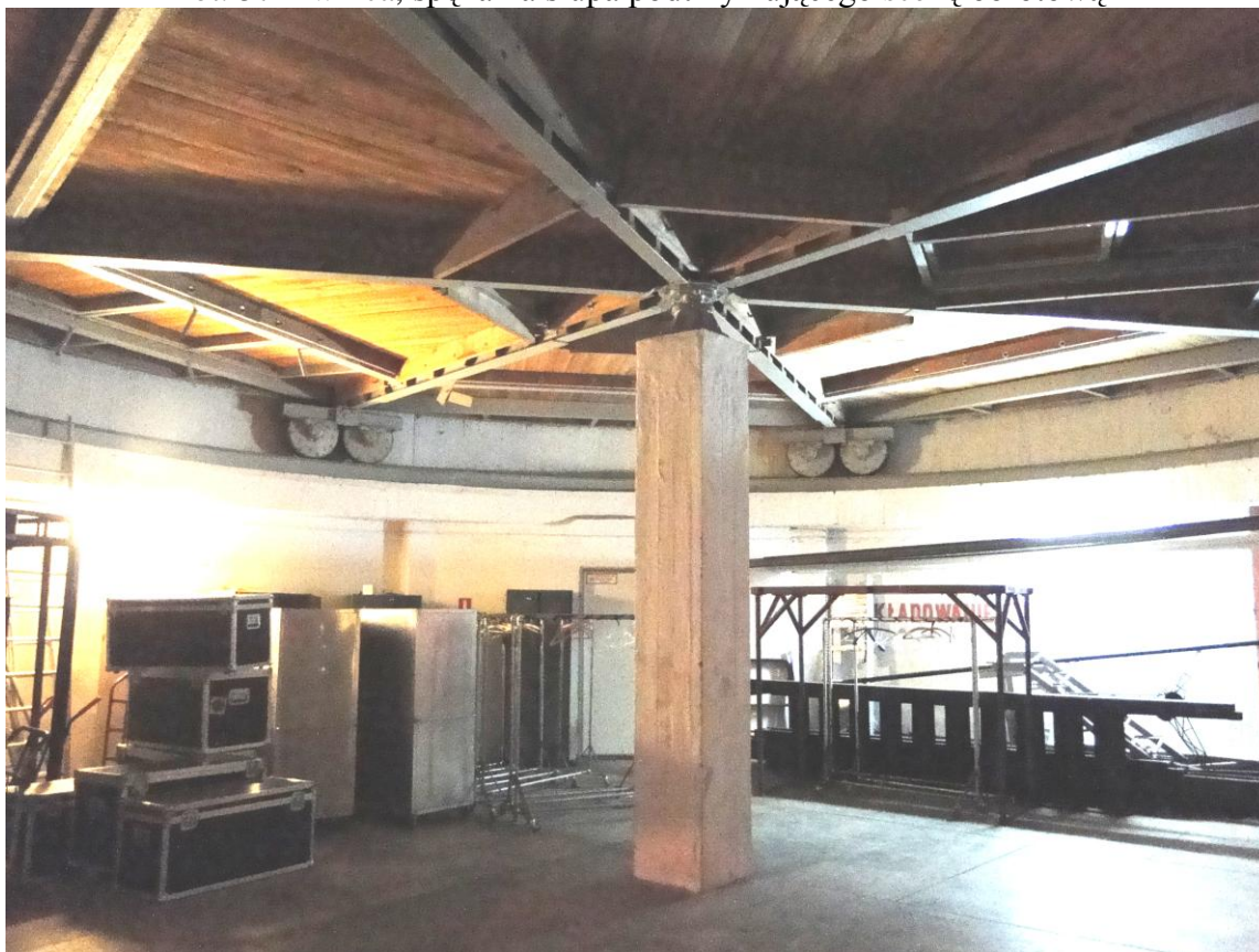
Fot.58. Piwnica – widok podparcia sceny obrotowej
