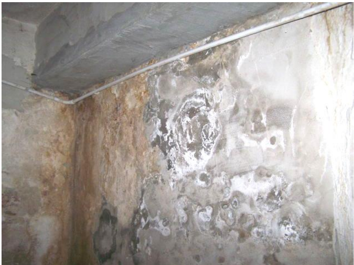
Fot.56. Piwnica – zawilgocenie i zagrzybienie ścian w pomieszczeniu pod podwórkiem
