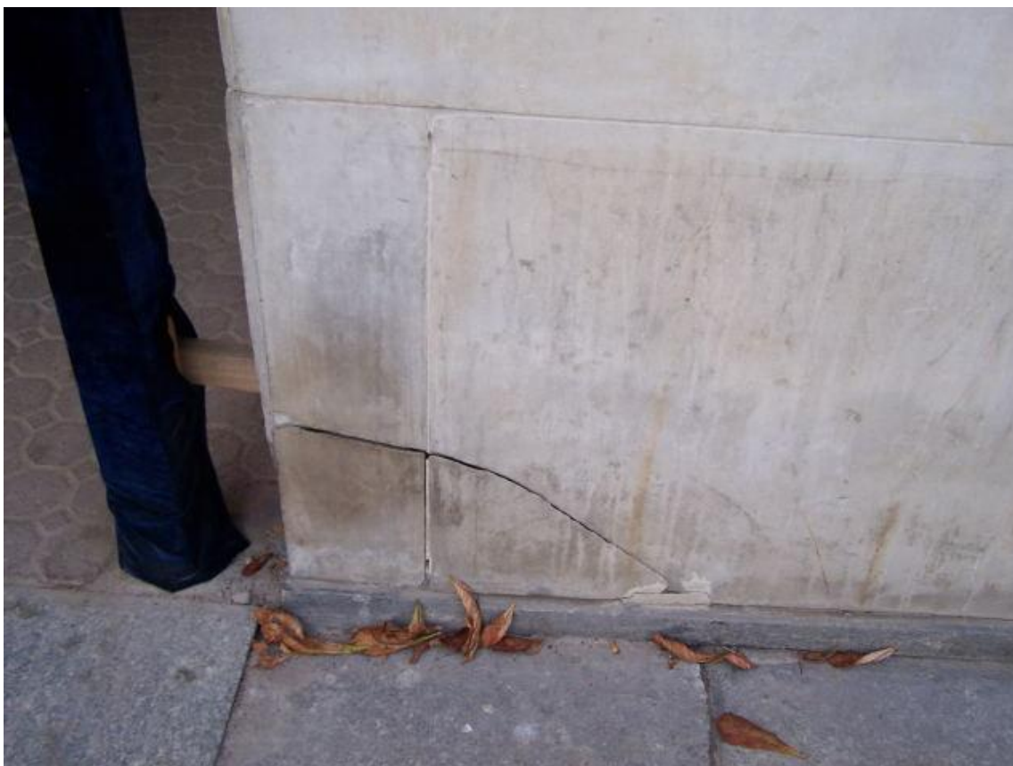
Fot. 132 Elewacja od strony placu Grzybowskiego – zarysowania okładziny w strefie cokołu
