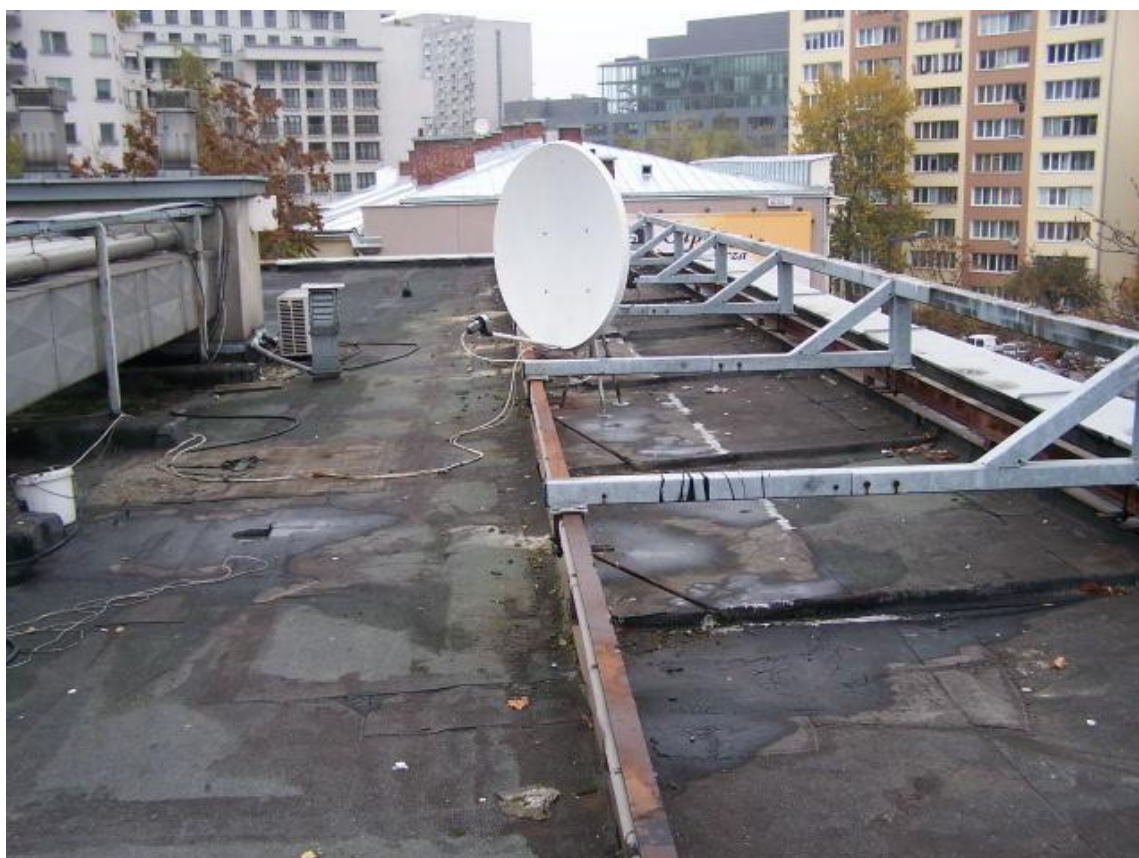
Fot.121 Dach – widok ogólny, widoczne spękania i zastoiny wody
