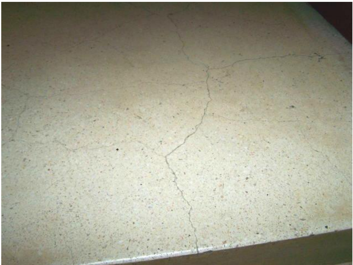
Fot.66. Garderoby teatru( ½ pietra) - zarysowania podestu schodów
