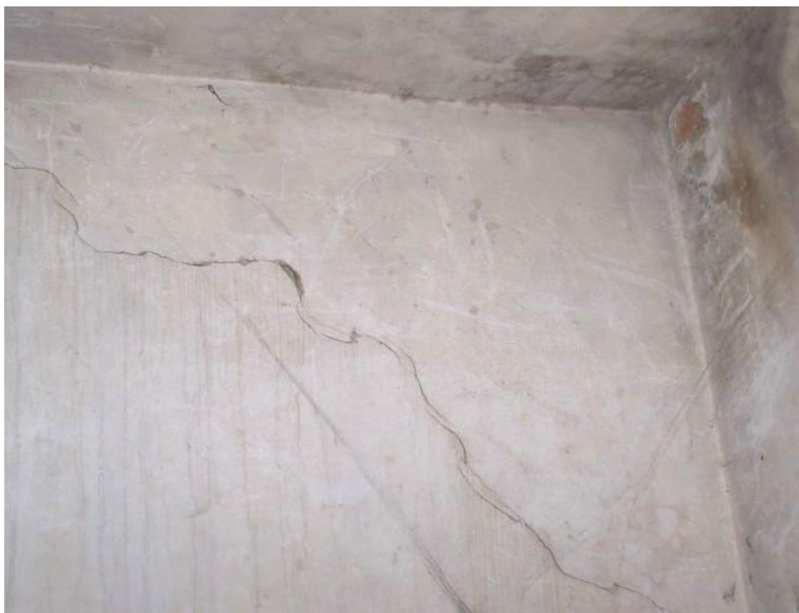
Fot. 20 Piwnica – zarysowania ścian poprzecznych (w pomieszczeniu skrajnym w trakcie przy placu Grzybowskiem)
