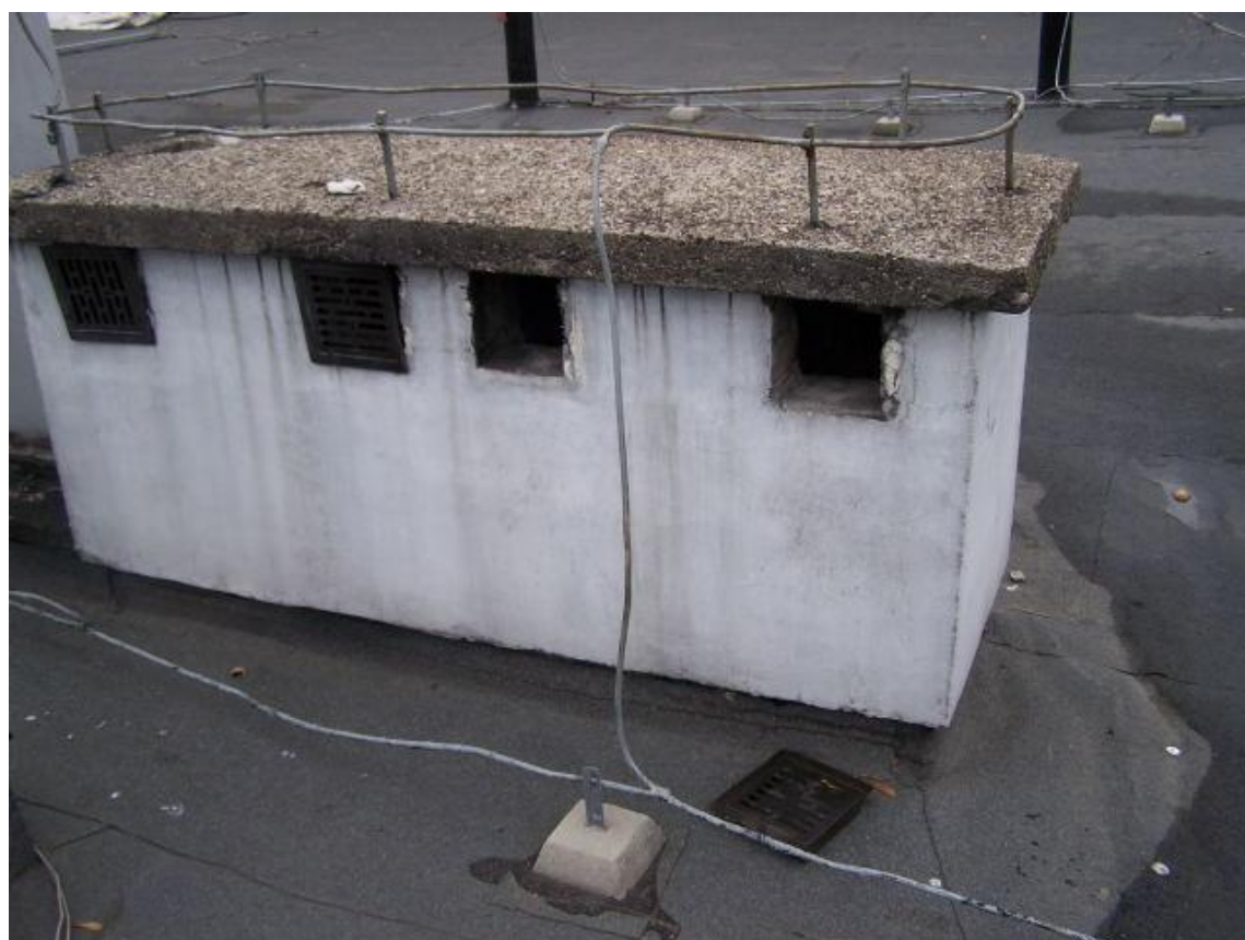
Fot. 124 Dach – uszkodzone kratki wentylacyjne
