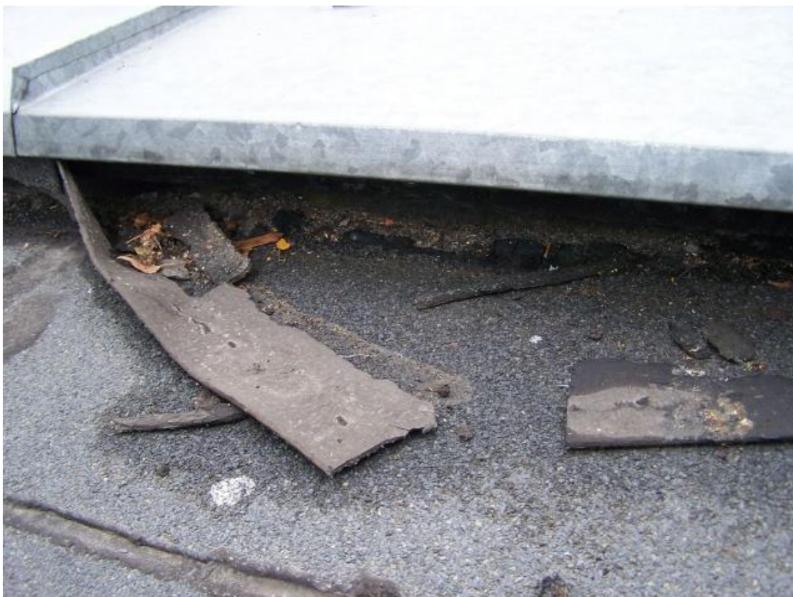
Fot.125 Dach – uszkodzone wywiniecie papy
