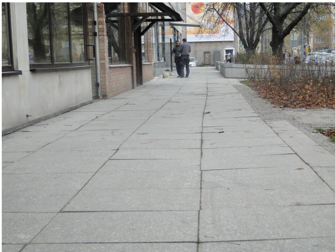
Fot.133 Elewacja od strony placu Grzybowskiego – zapadanie się płytek chodnikowych ułożonych na stopie kondygnacji piwnicznej
