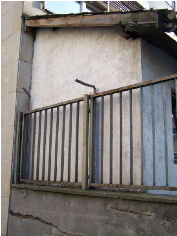
Fot. 140 Elewacja od strony podwórka – spękania muru dawnego tarasu (obecnie oparta na nim przybudówka od strony podwórka)
