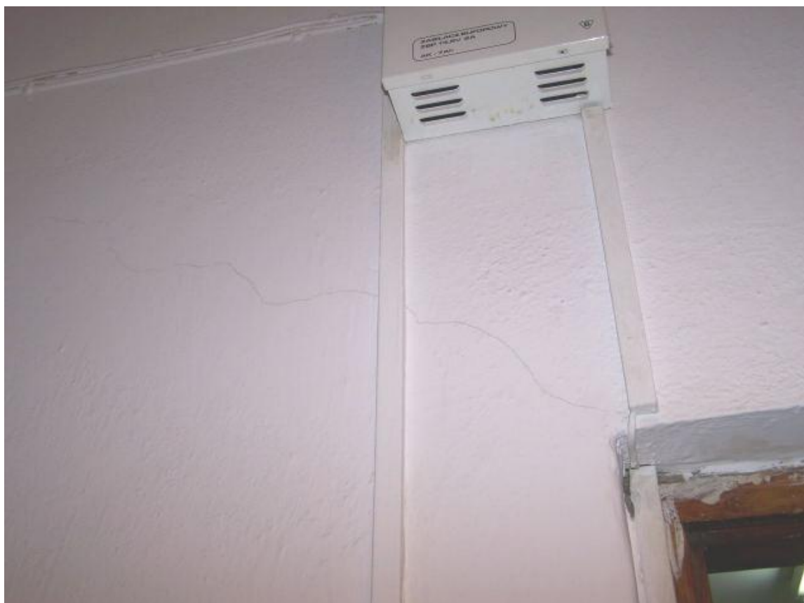
Fot.91 II piętro – zarysowania ściany działowej
