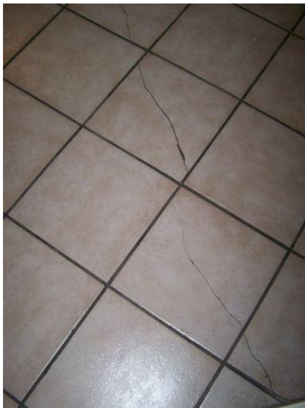
Fot. 61 Parter – zarysowania posadzki w miejscu dylatacji (nadbudowane pomieszczenie na tarasie)
