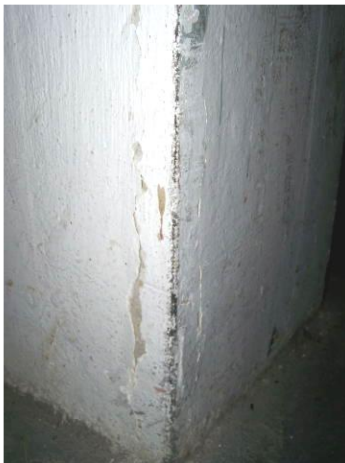
Fot. 57 Piwnica, spękania słupa podtrzymującego scenę obrotową
