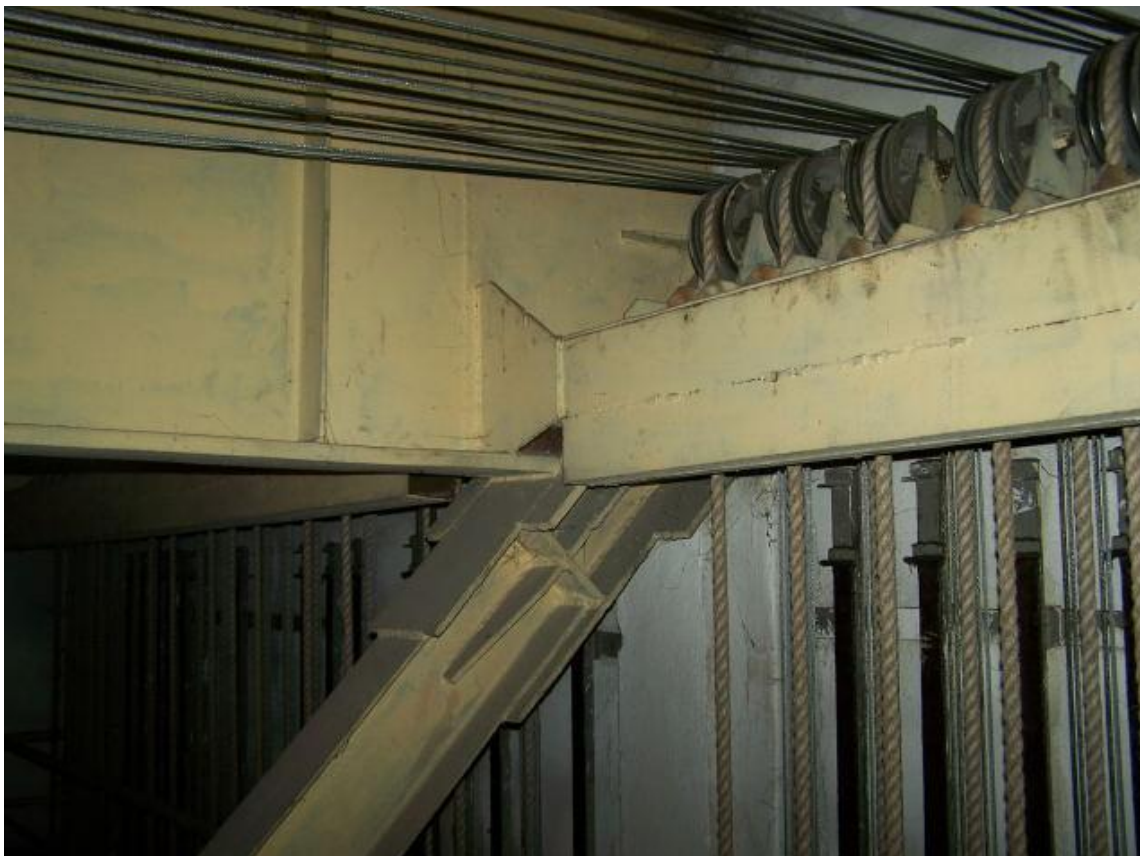
Fot.113 Poziom techniczny nad sceną – konstrukcja przekrycia nad sceną
