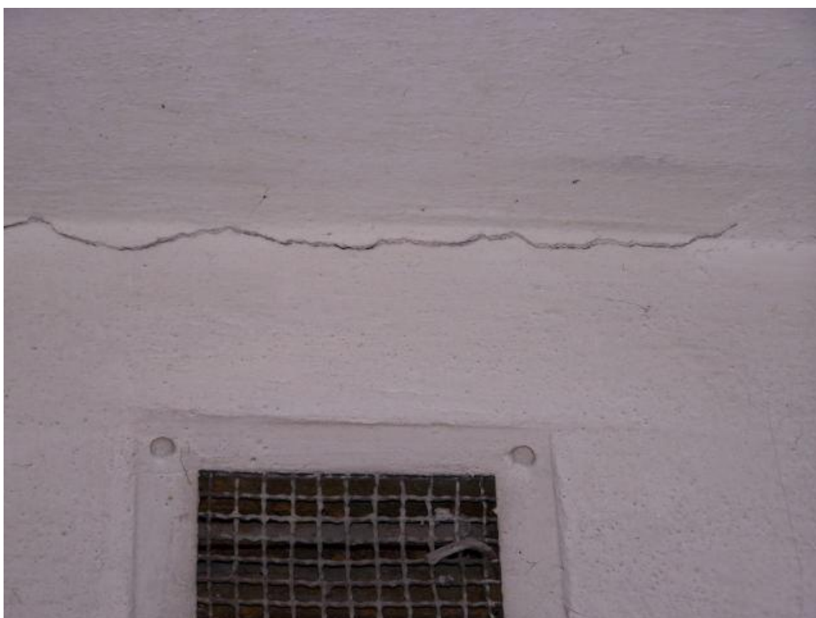
Fot. 8. Piwnice – zarysowania pod stropem, odspojenie ścian działowych
