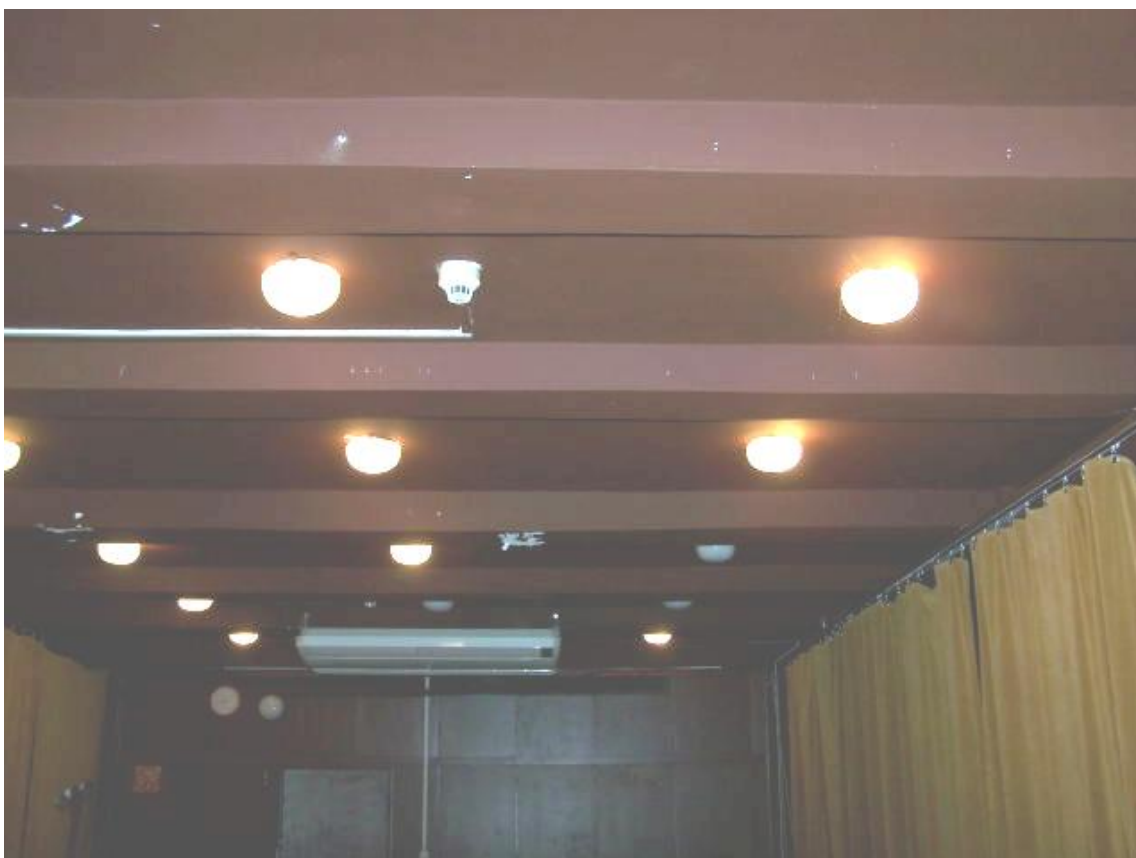
Fot.74. I piętro – konstrukcja stropu w Sali ćwiczeń teatru
