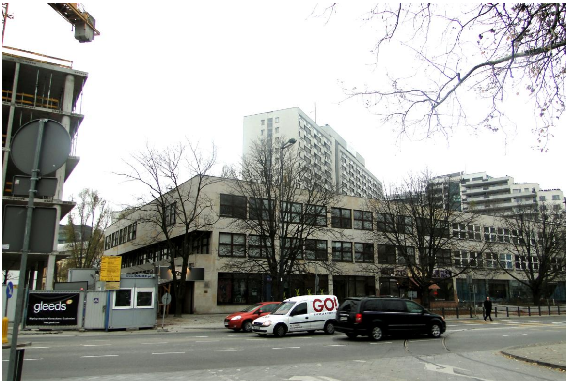
Fot.1. Elewacja frontowa budynku TSKŻ od strony placu Grzybowskiego (południowo – wschodnia)
