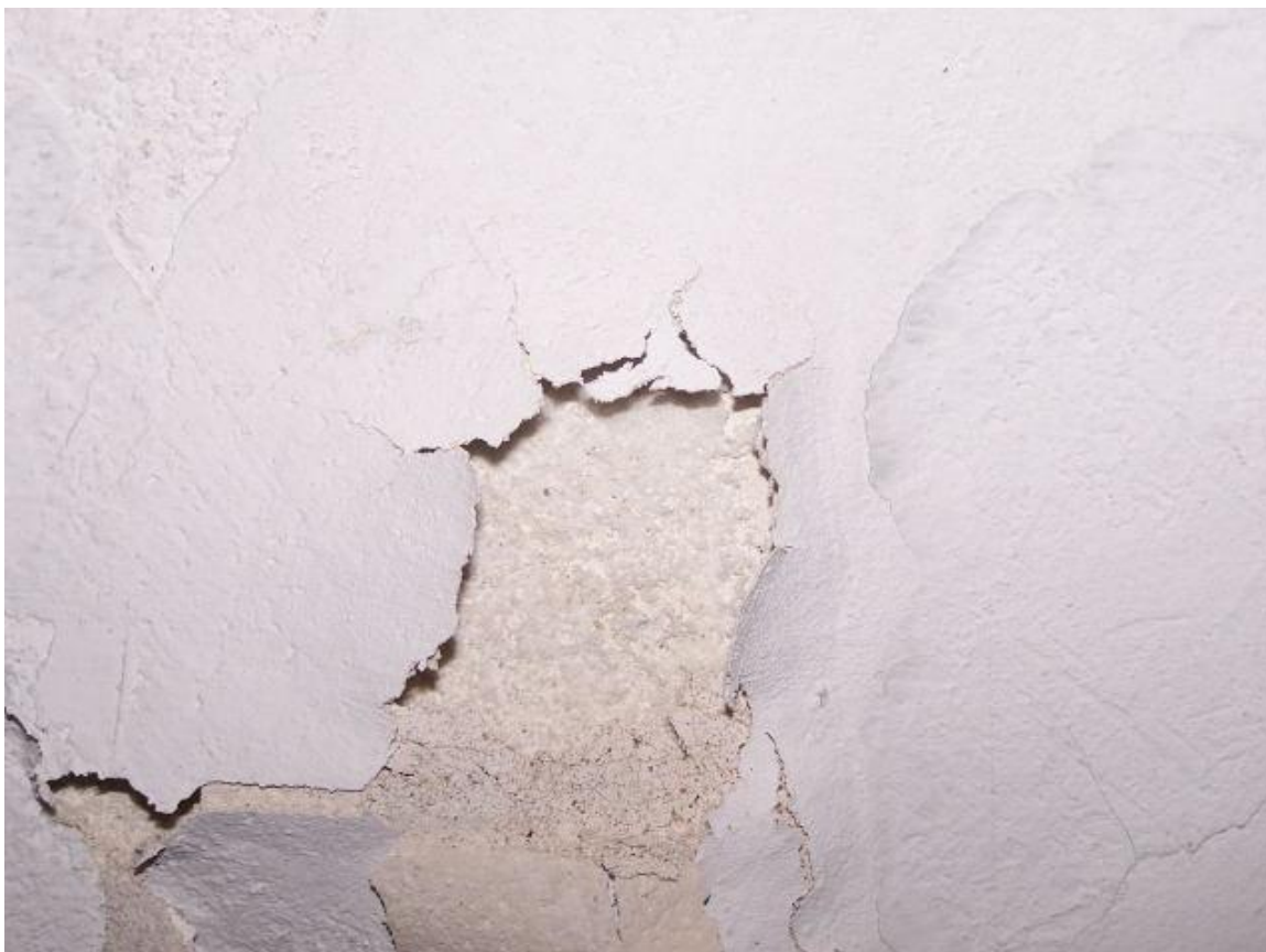
Fot.11. Piwnica – przykładowa korozja biologiczna ścian piwnicznych, odspojenie tynku
