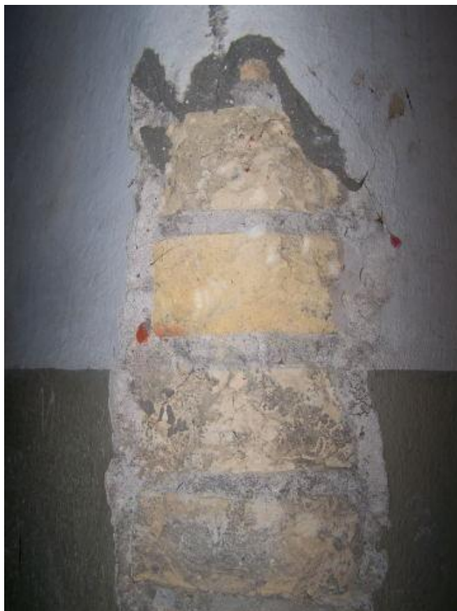
Fot.35. Piwnica – przykładowe zagrzybienie i zawilgocenie ścian, odspojenie tynku
