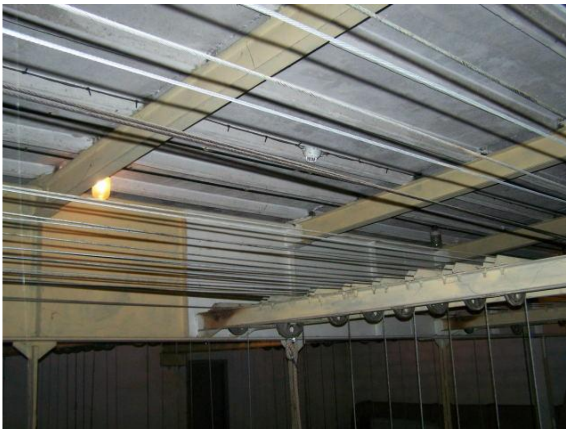
Fot.119 Poziom techniczny nad sceną – konstrukcja przekrycia
