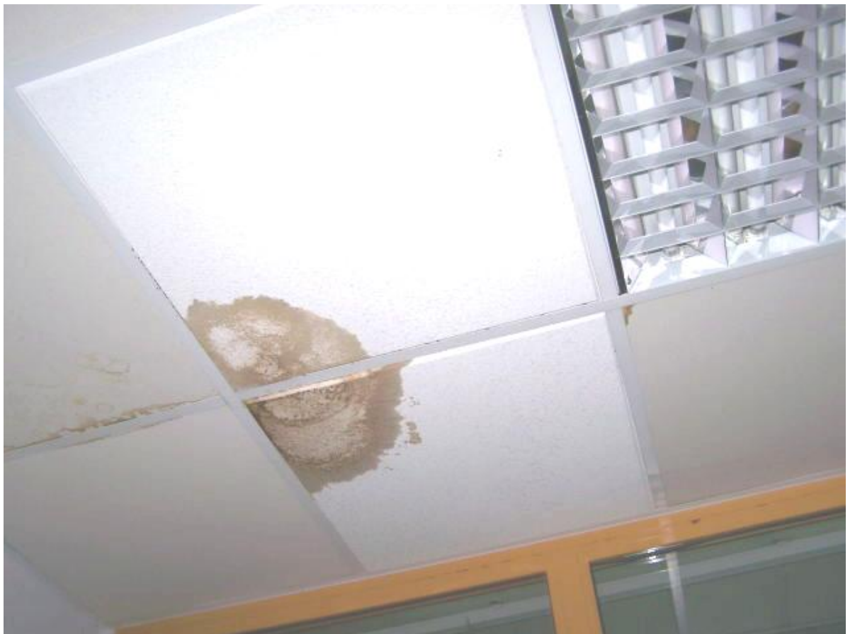
Fot. 86 II piętro – zacieki na płytach sufitu podwieszanego w banku
