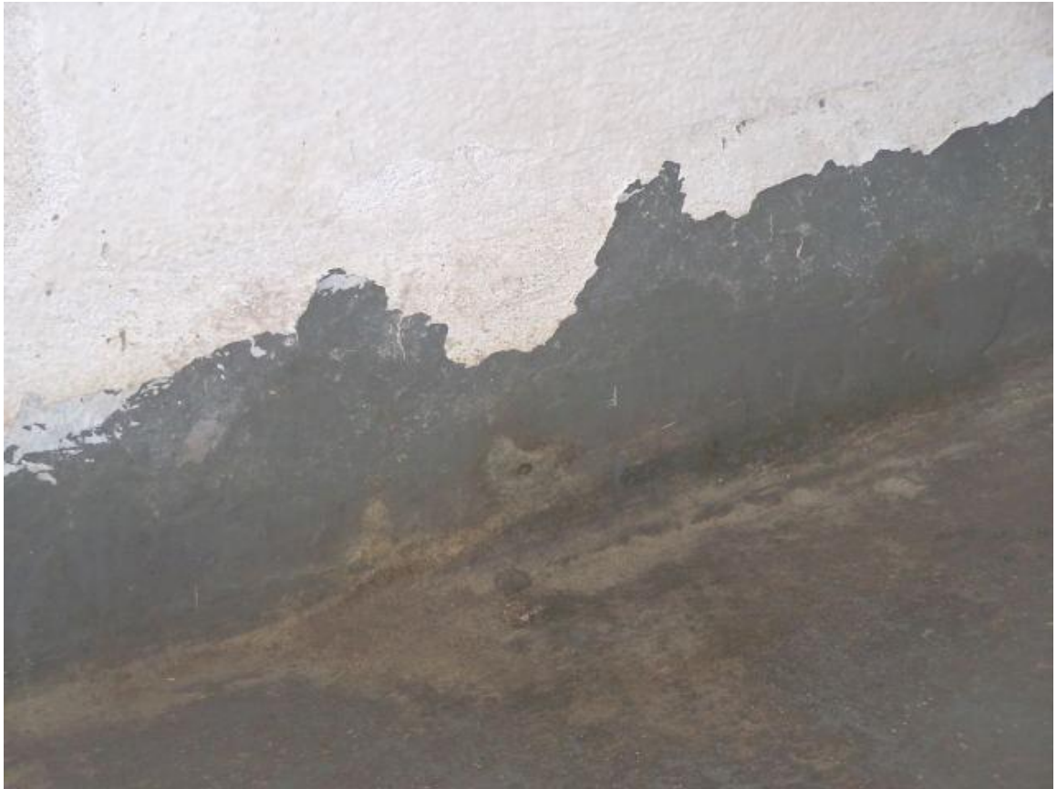
Fot.27. Piwnica – przykładowe zawilgocenie ścian
