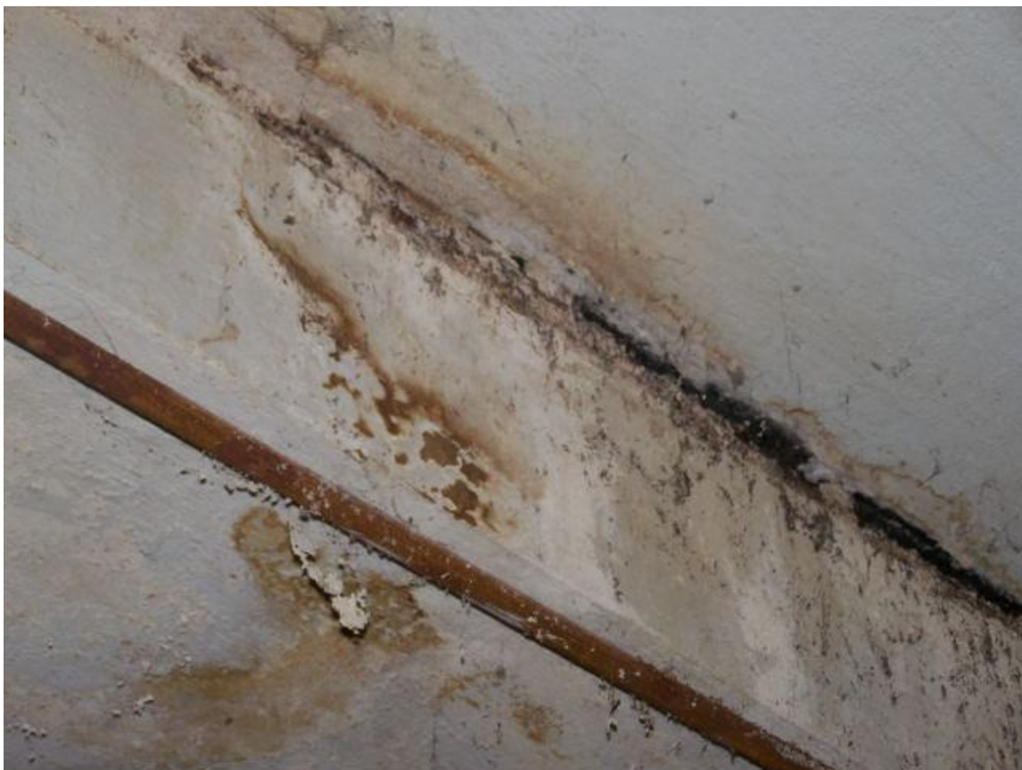
Fot.41. Piwnica – przykładowe zagrzybienie i zawilgocenie ścian , kolonie pleśni
