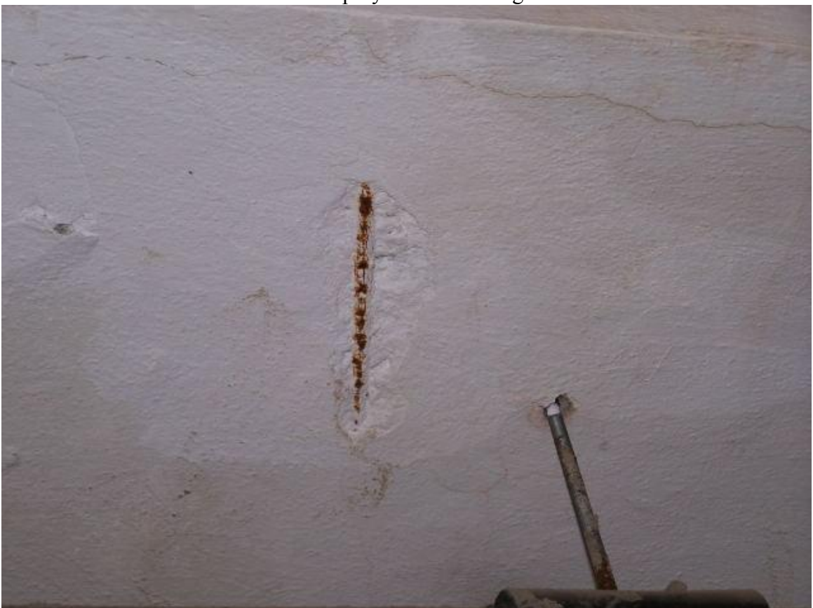
Fot. 28. Piwnica - widoczne skorodowane zbrojenie podciągu (pomieszczenia skrajne od strony elewacji tylnej)
