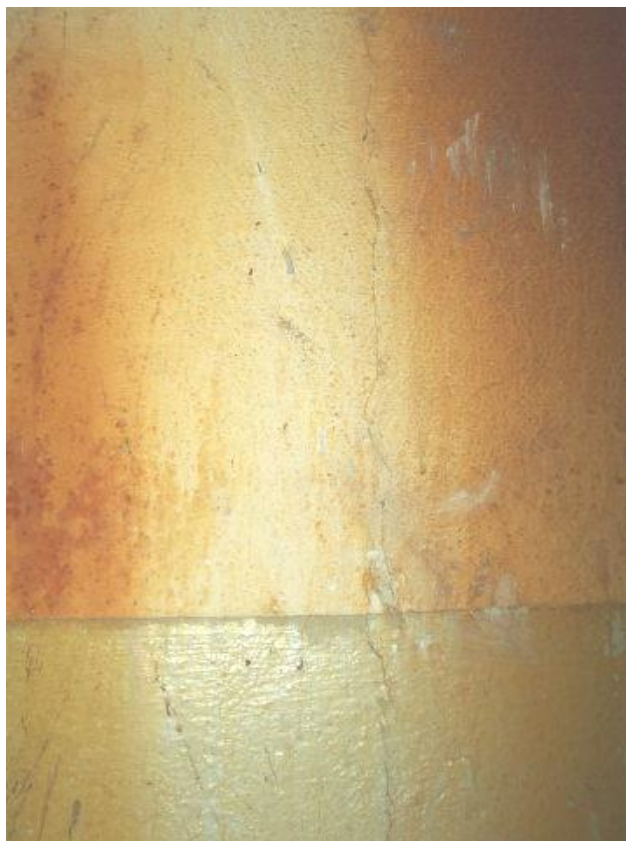
Fot.37. Piwnica – rysa podłużna w ścianie działowej korytarza
