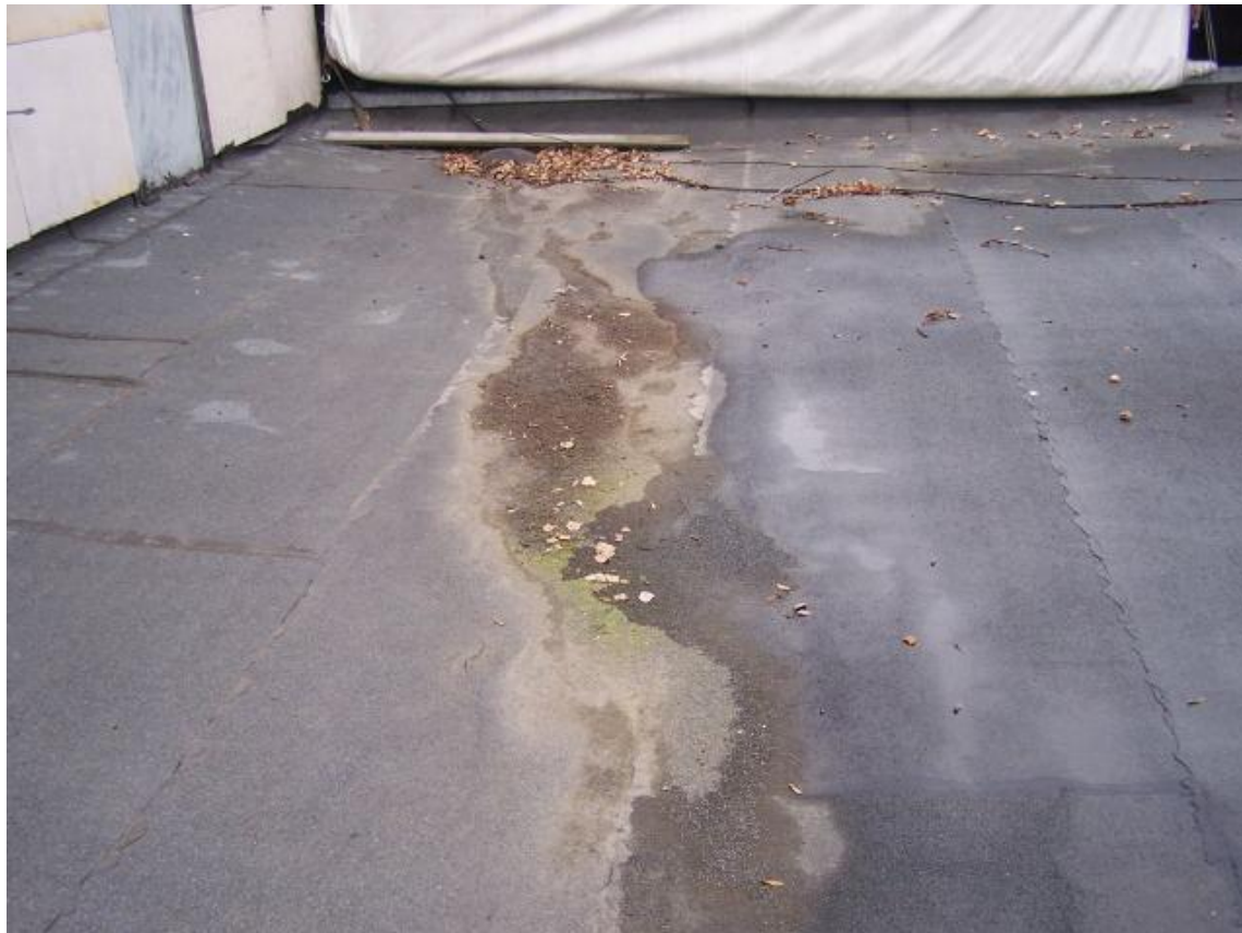
Fot. 126 Dach - spękania papy i zastoiny wody.
