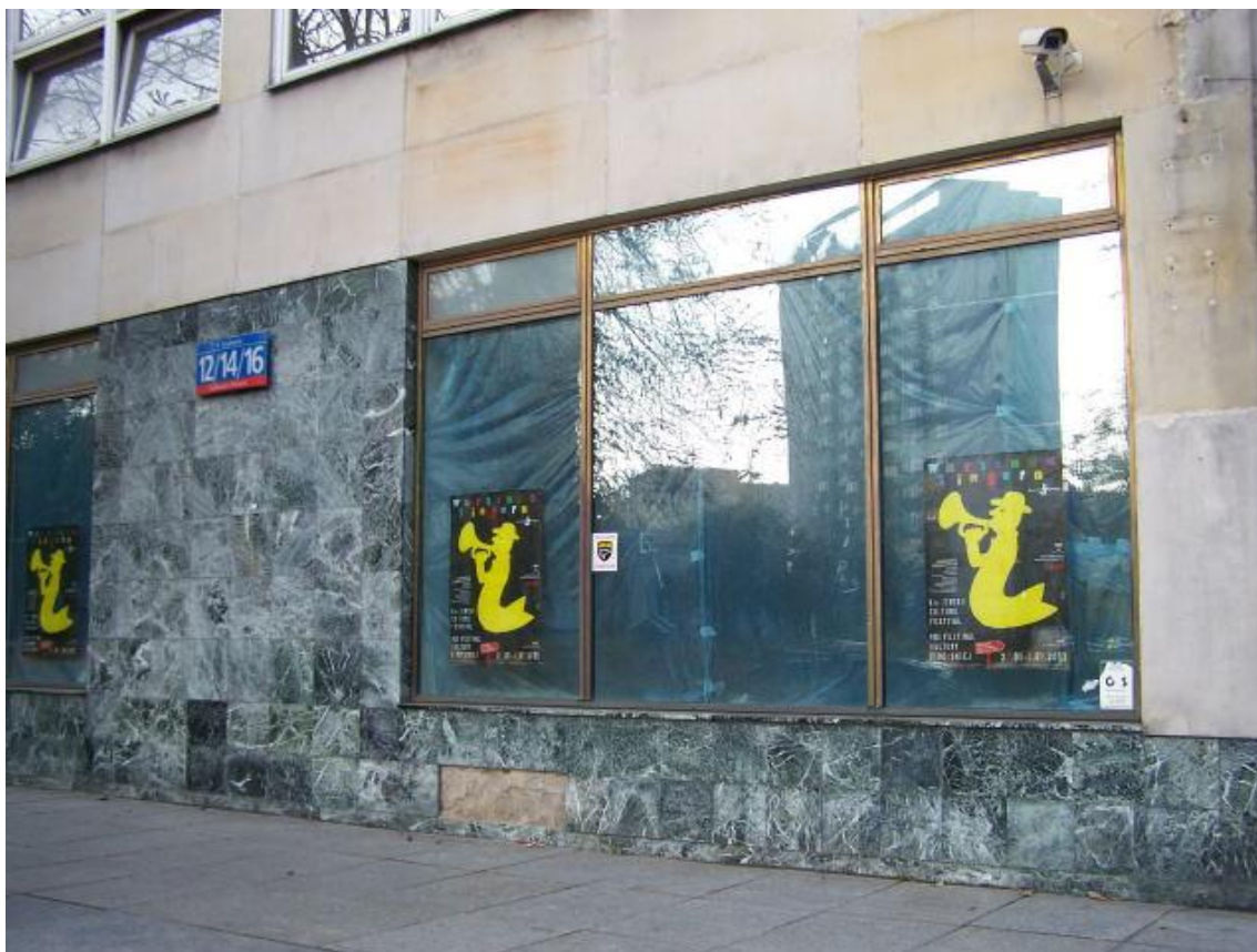
Fot.131 Elewacja od strony placu Grzybowskiego – ubytki płyt okładziny kamiennej
