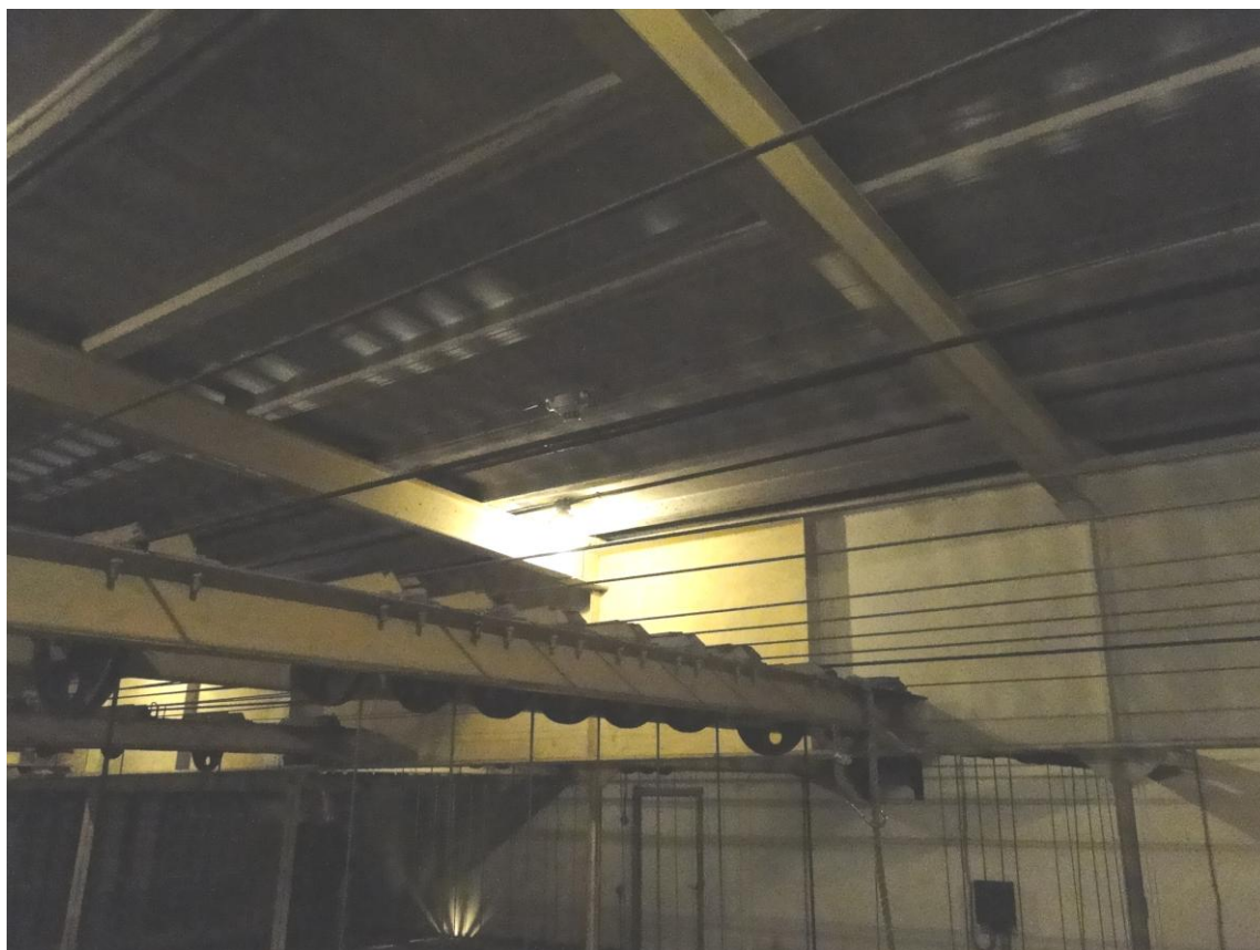
Fot.115 Poziom techniczny nad sceną – podwieszane elementy dekoracji teatralnych
