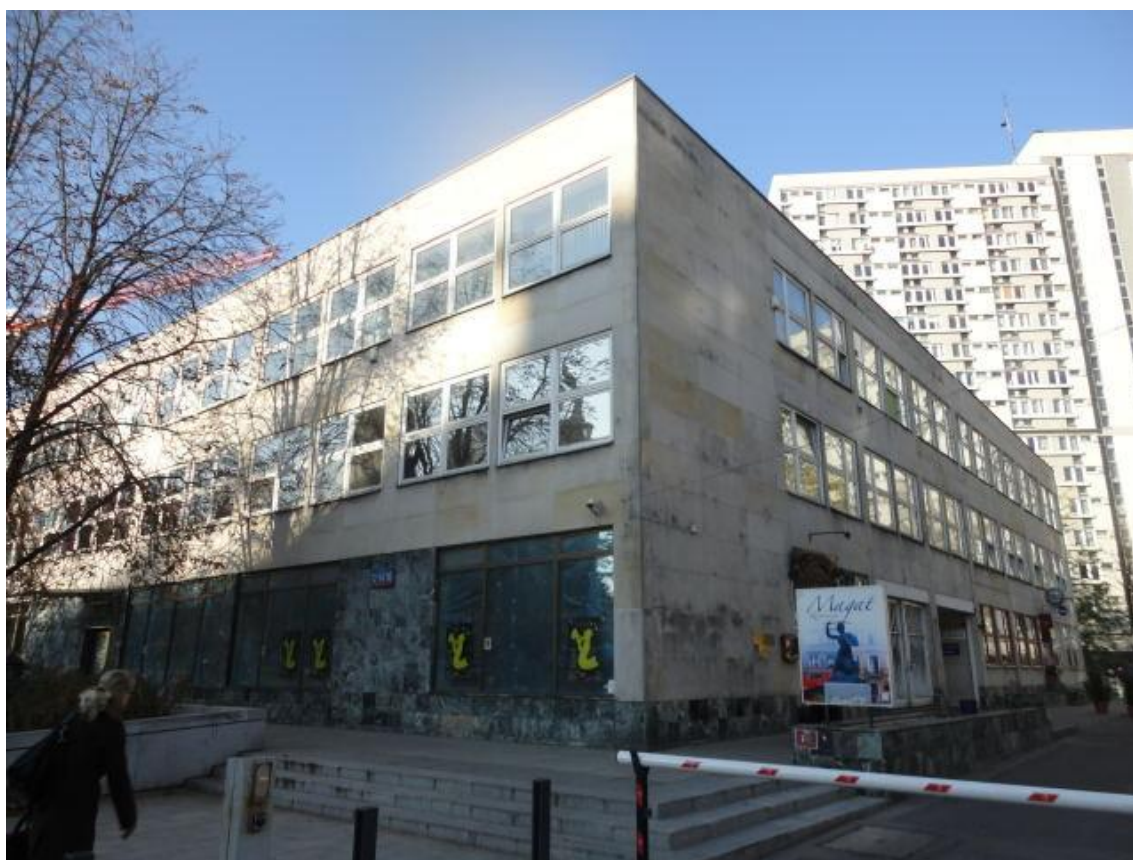
Fot.2. Elewacja frontowa i boczna (północno - wschodnia)
