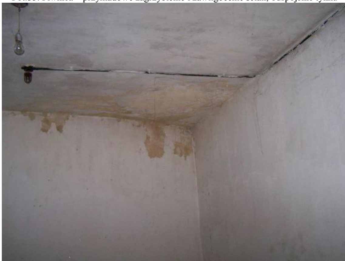
Fot.36. Piwnica – przykładowe zagrzybienie i zawilgocenie ścian
