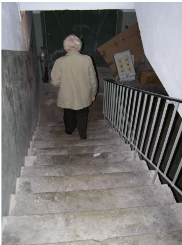
Fot. 5. Widok schodów do piwnicy
