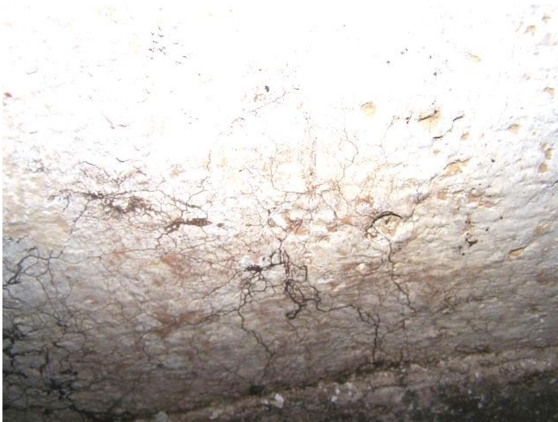
Fot.31. Piwnica – przykładowe zagrzybienie i zawilgocenie ścian
