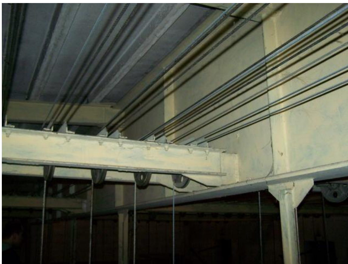
Fot. 108 Poziom techniczny nad sceną - konstrukcja przekrycia
