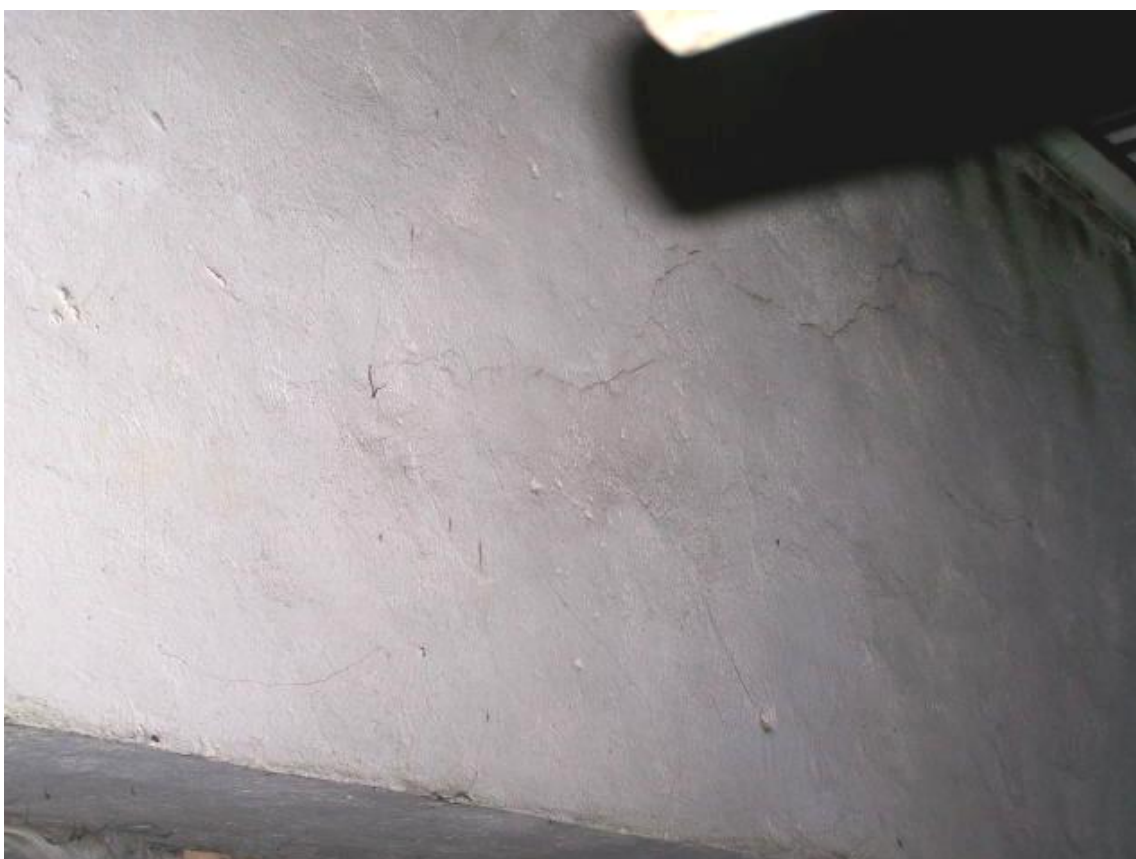
Fot.98. II piętro – zarysowania i zawilgocenie ścian
