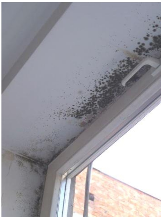
Fot.81 I piętro – restauracja „Magat”, pleśnie na nadprożu okiennym
