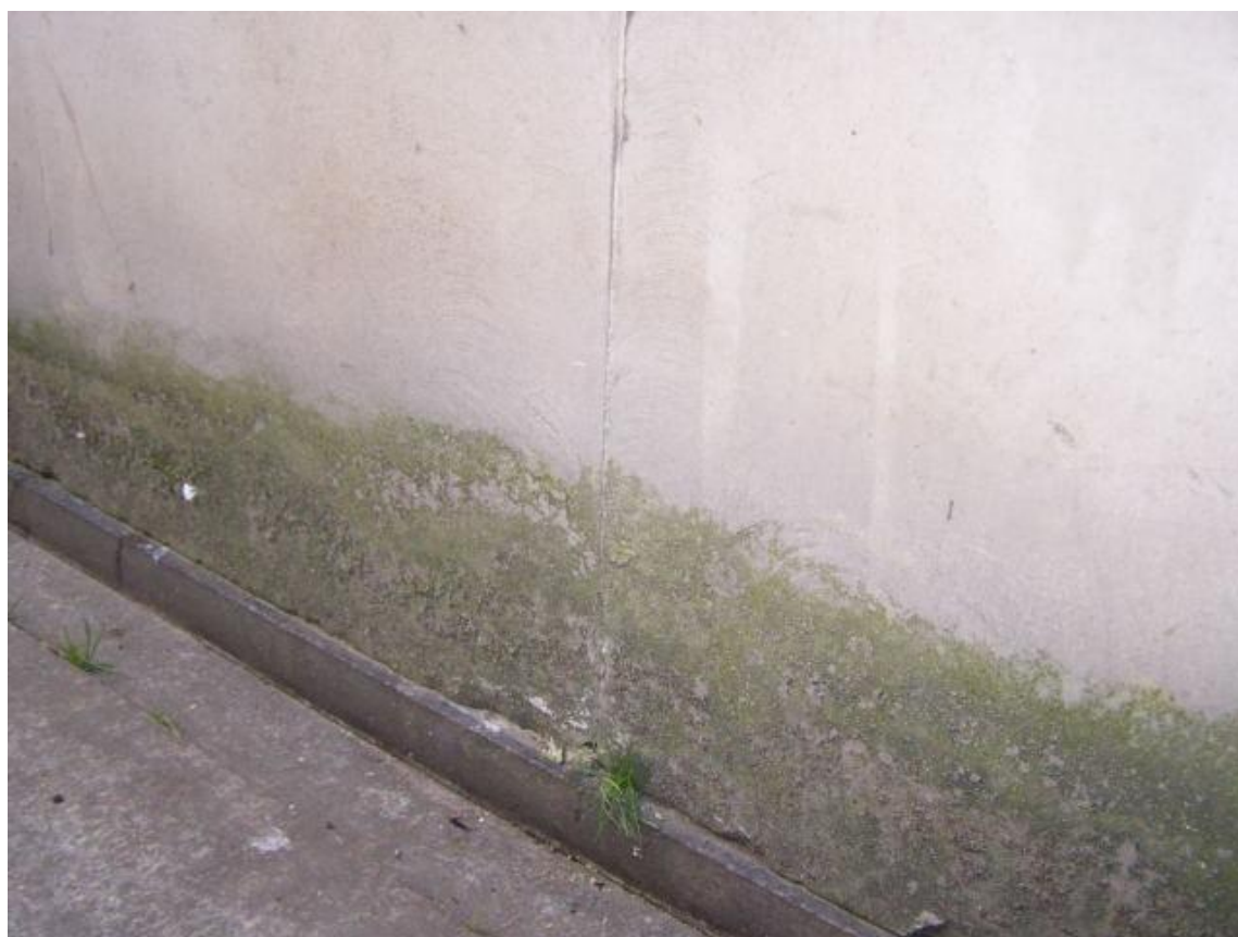
Fot. 138. Elewacja tylna teatru – zawilgocenie i porośnięcie mchami i porostami ścian, w strefie cokołu
